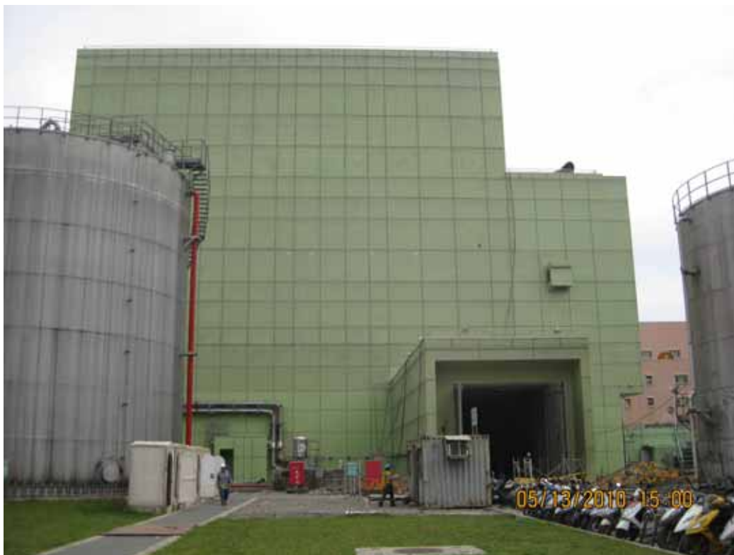
照片 1 龍門核電廠一號機反應器廠房外觀
