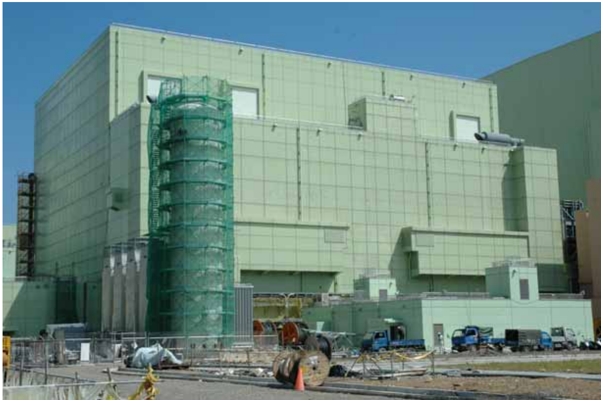
照片 1 龍門核電廠 1 號機反應器廠房施工現況
