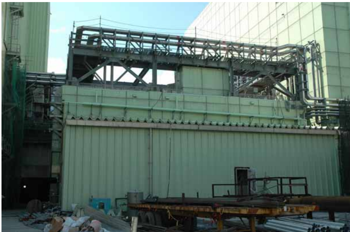
照片 2 龍門核電廠 1 號機控制廠房施工現況
