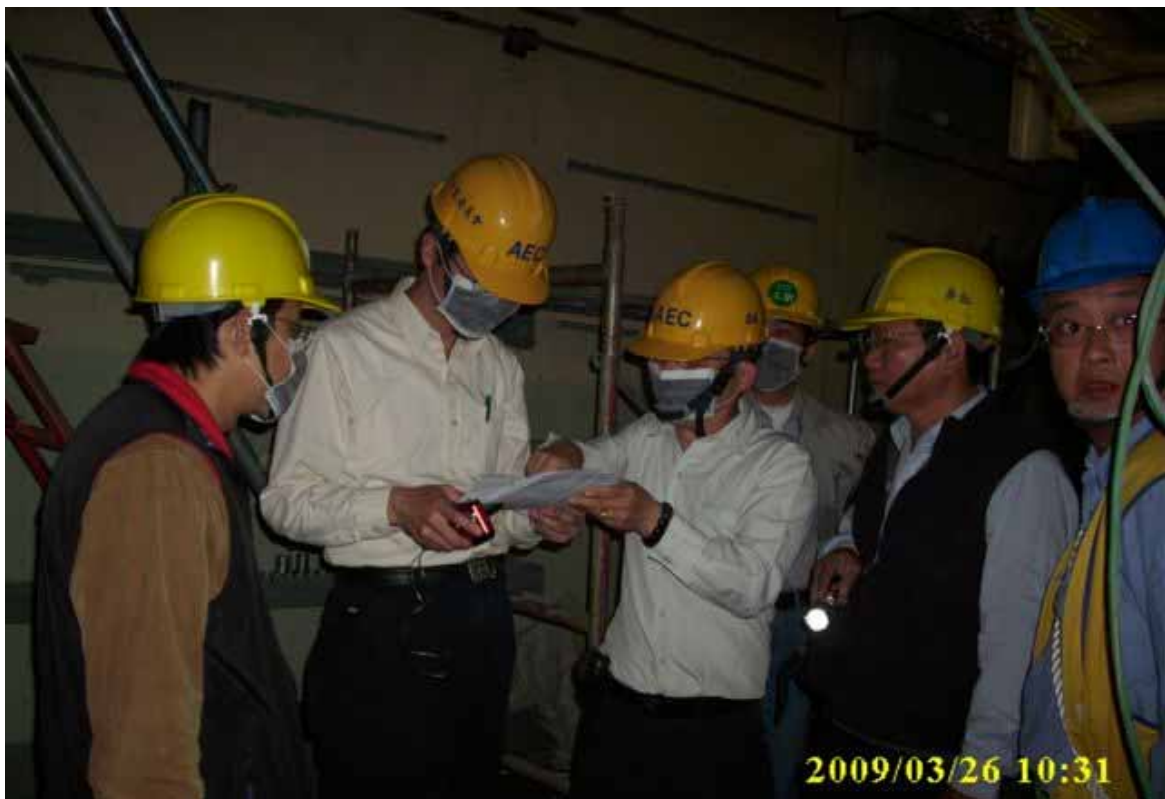
照片2 原能會視察員赴現場視察動火作業管制
