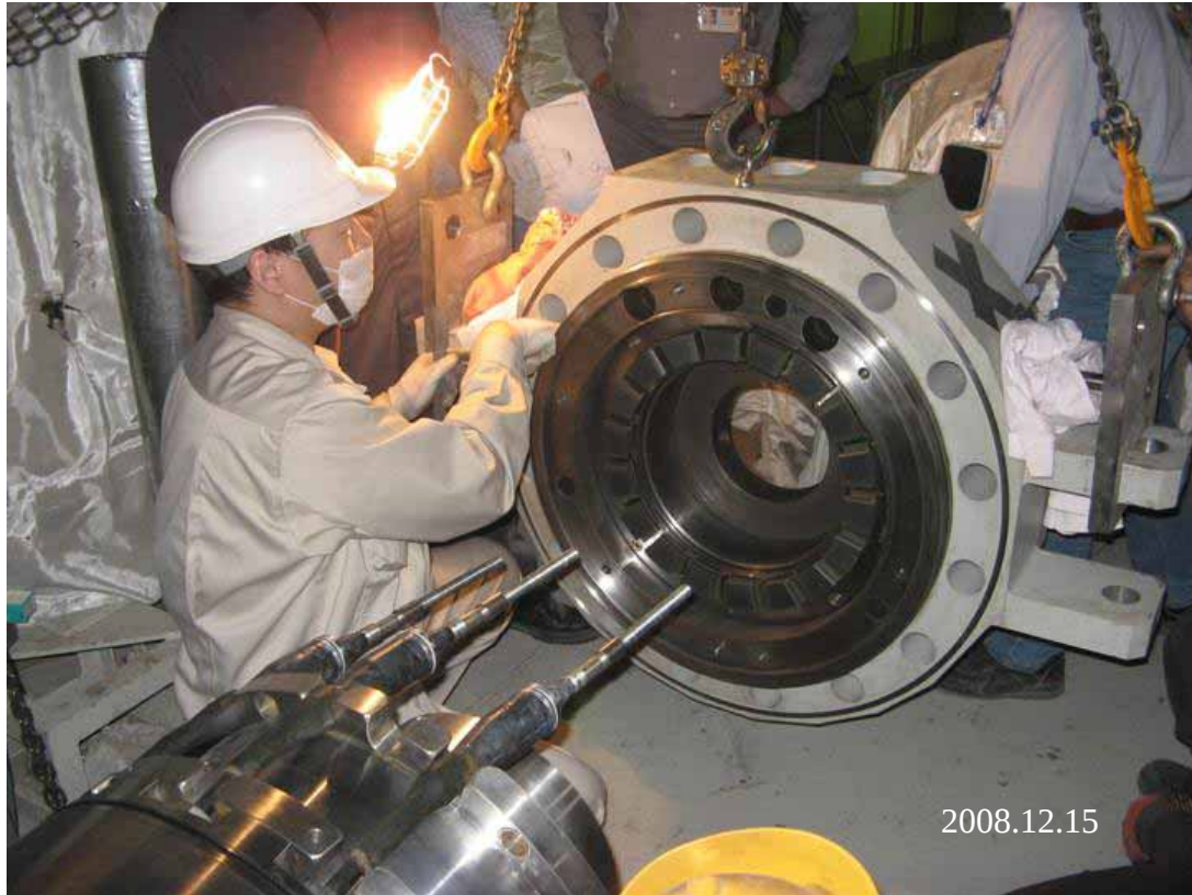
1號機爐內泵分解檢查作業
