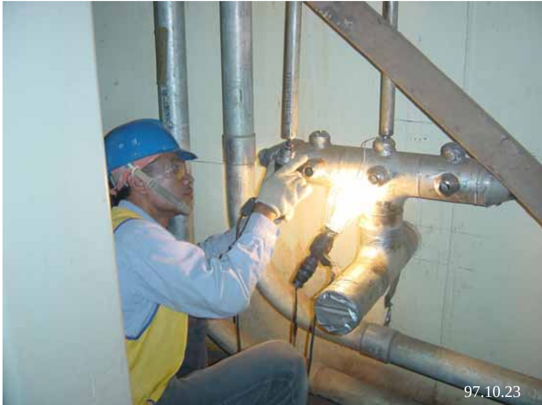
圖一：核能四廠1號機下乾井洩水管路銲接作業
