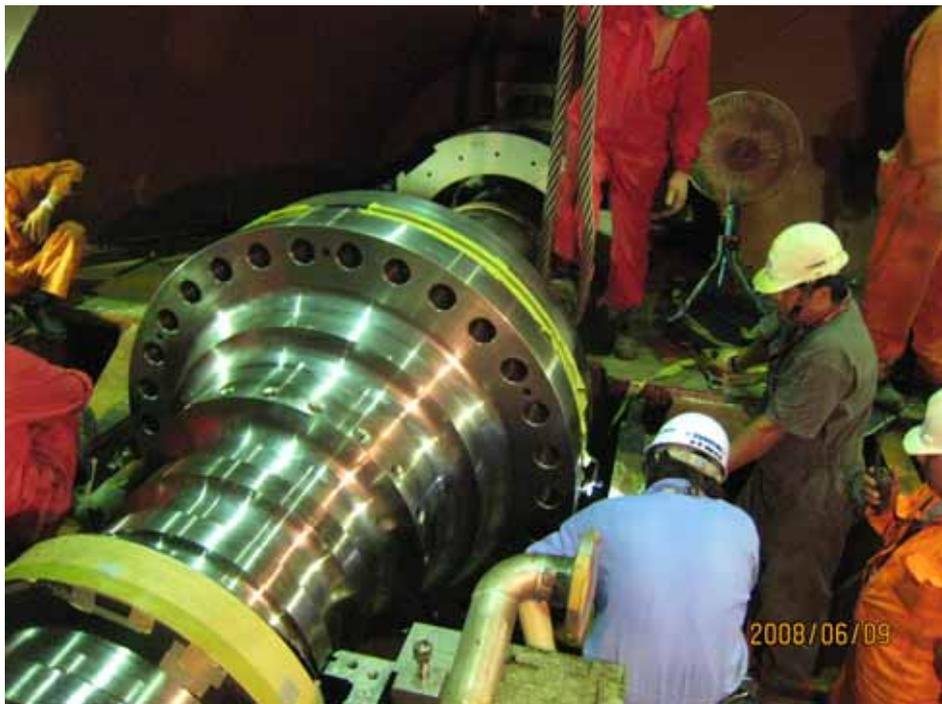
圖二：1號機汽機連接軸安裝作業
