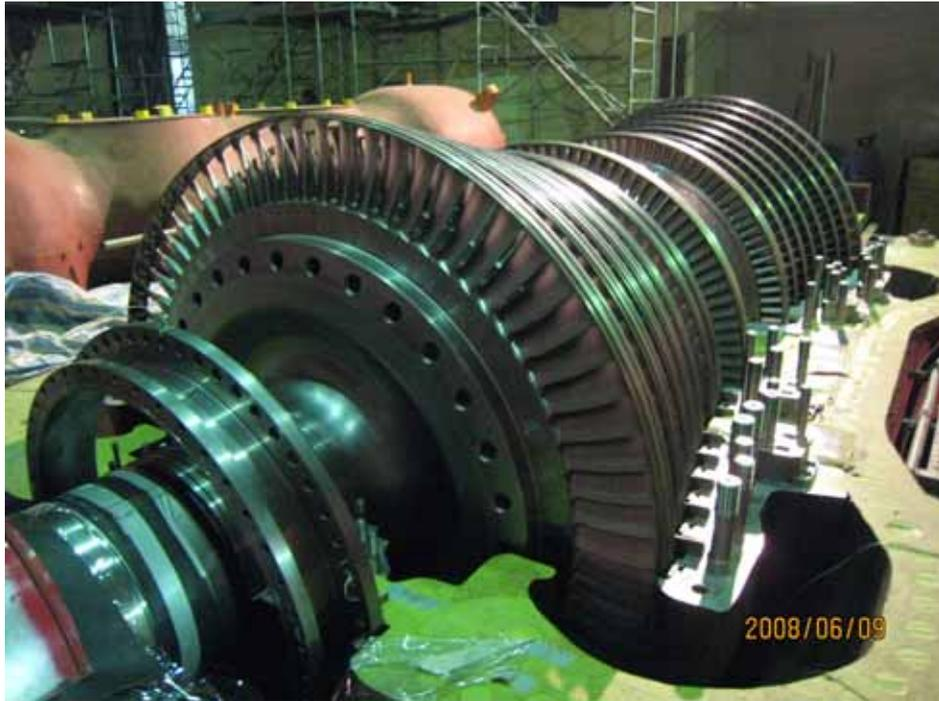
圖一：1號機高壓汽機安裝作業
