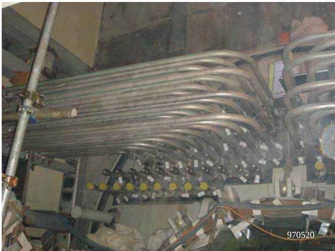
圖二：1 號機控制棒急停管路安裝作業
