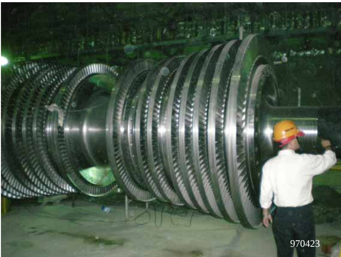
圖二：1 號機高壓汽機轉子維護保養作業
