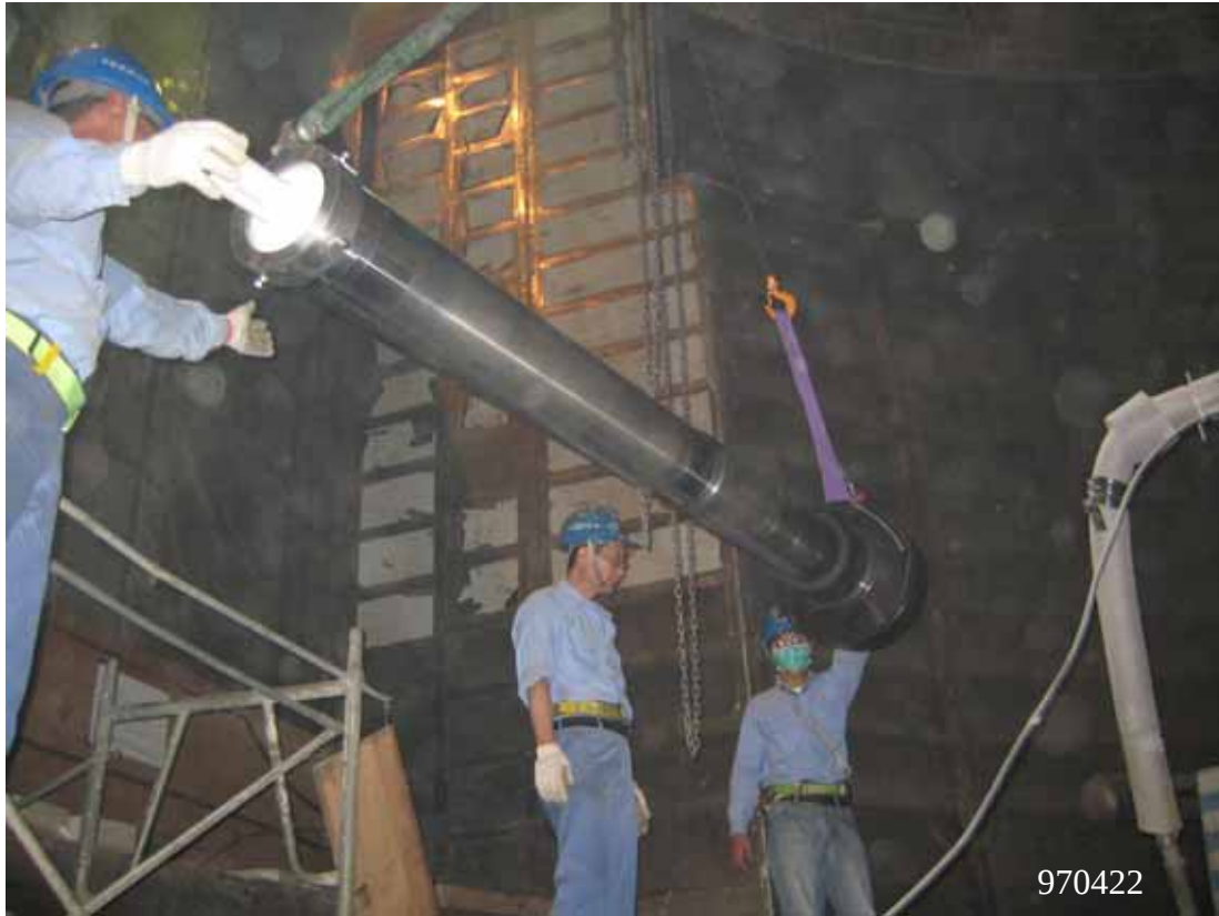
圖一：1 號機爐內泵葉輪安裝作業
