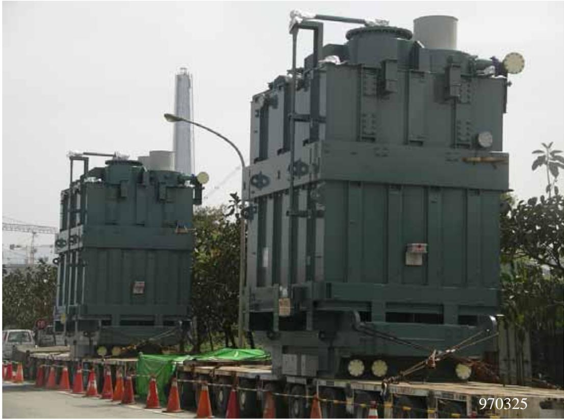
圖一：1 號機主變壓器運抵核四工地
