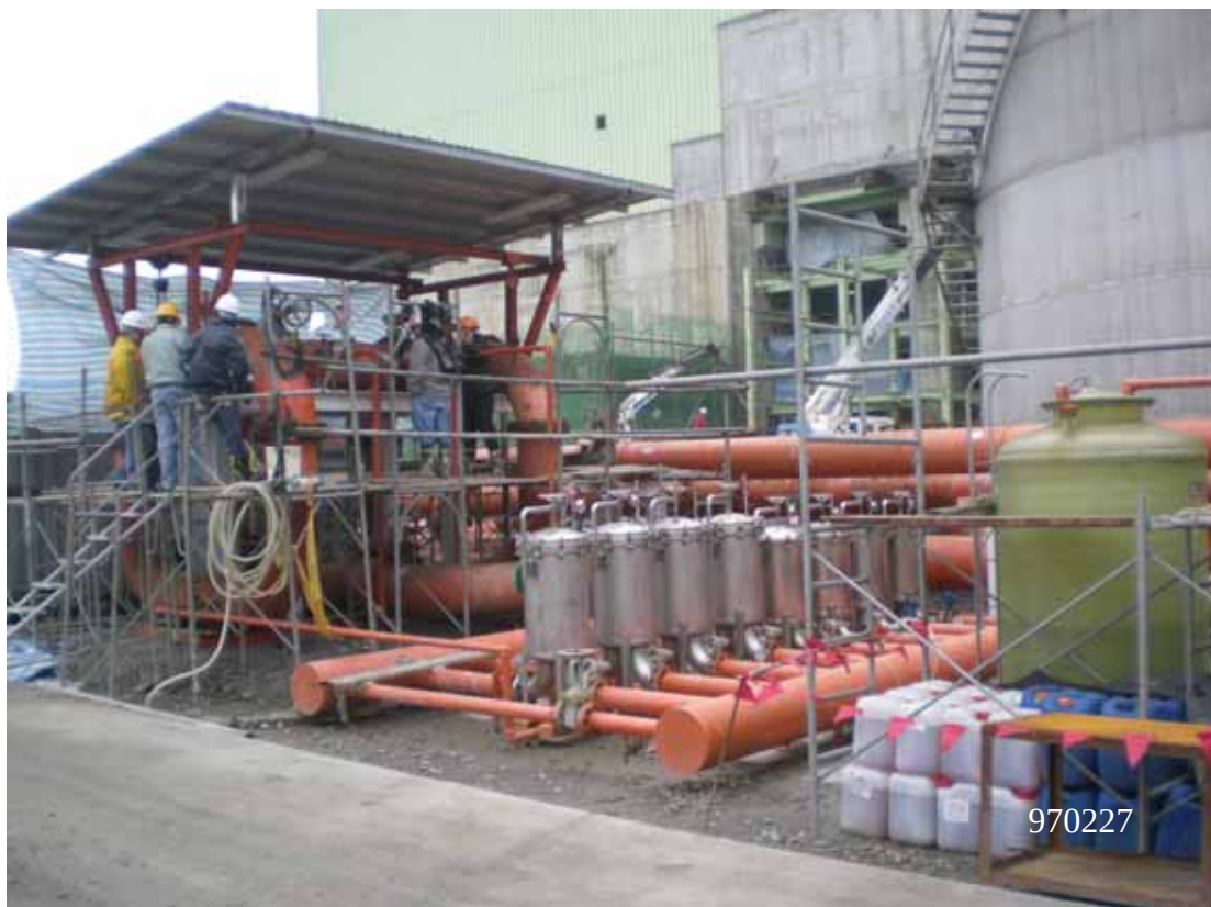
圖二：1 號機管路沖洗作業工作站現況
