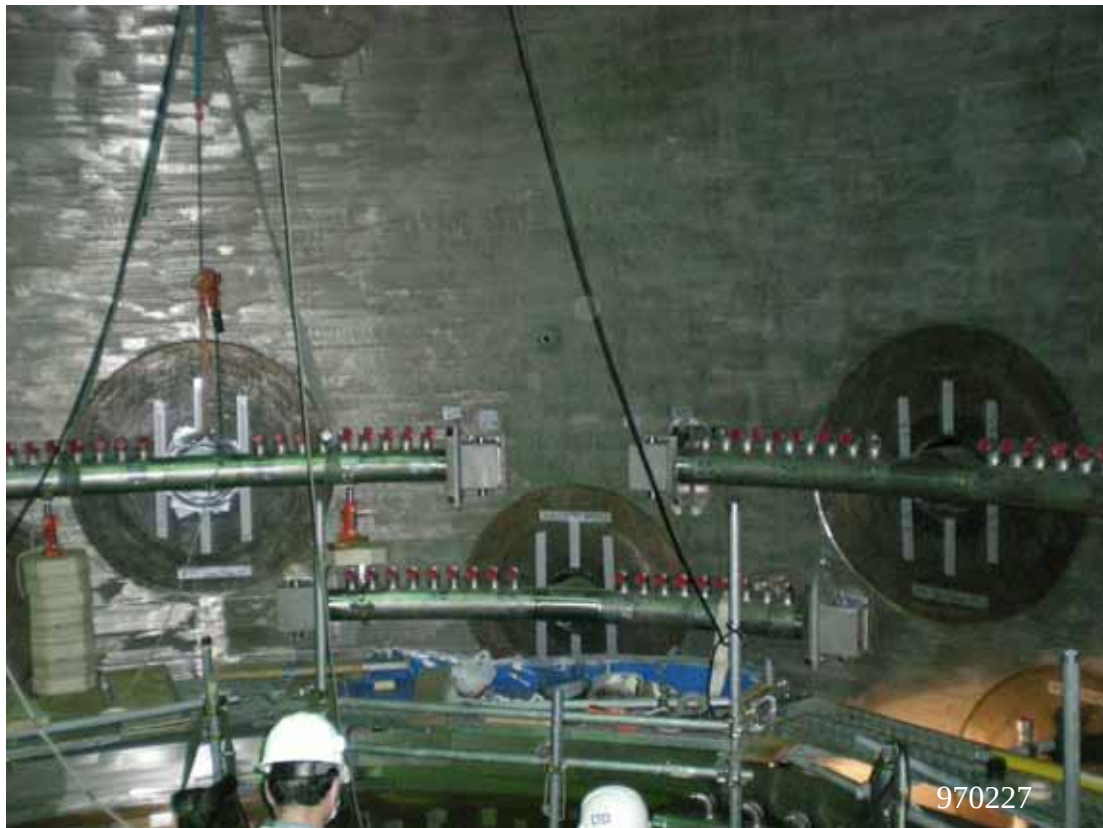
圖一：1號機反應爐內頂部導架(Top Guide)上方之各系統噴嘴安裝現況
