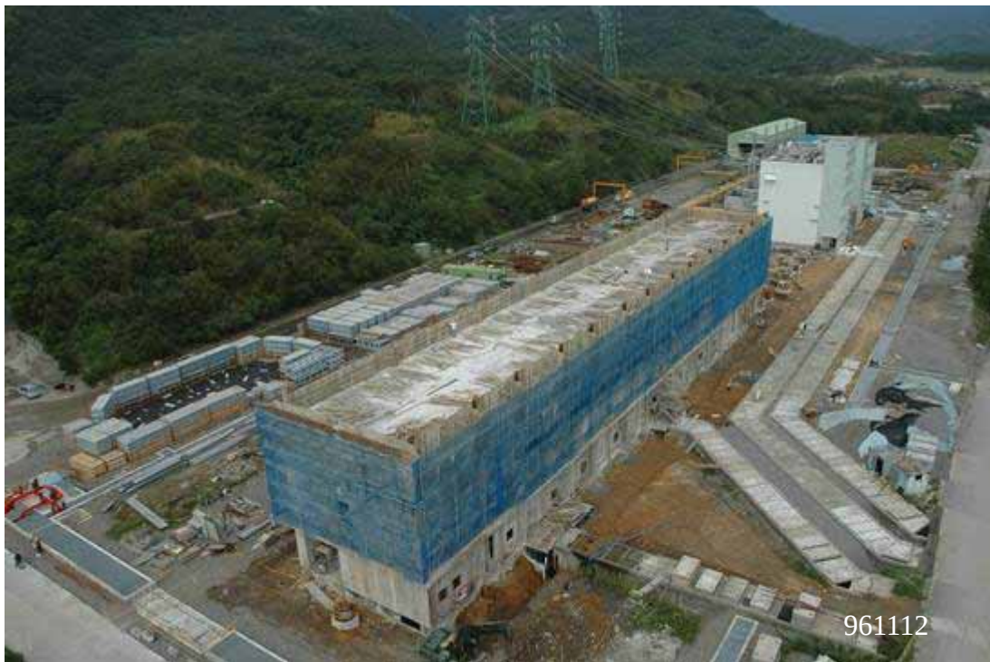
圖八：開關場施工現況圖景
