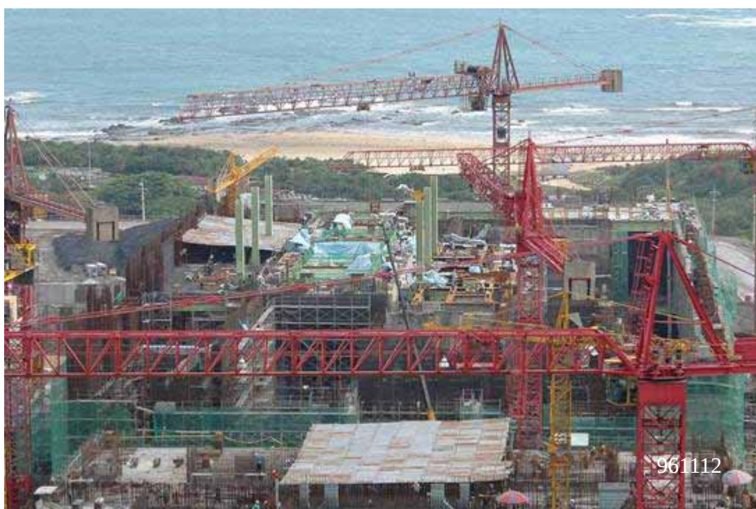
圖六：二號機汽機廠房施工現況圖景
