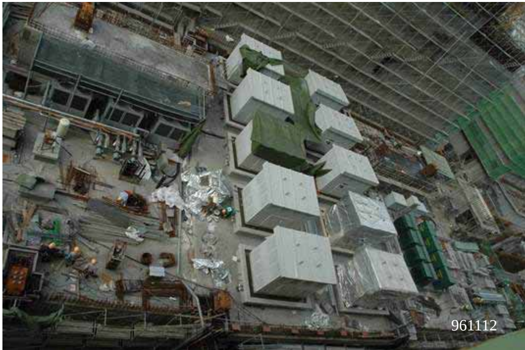
圖三：一號機控制廠房施工現況圖景
