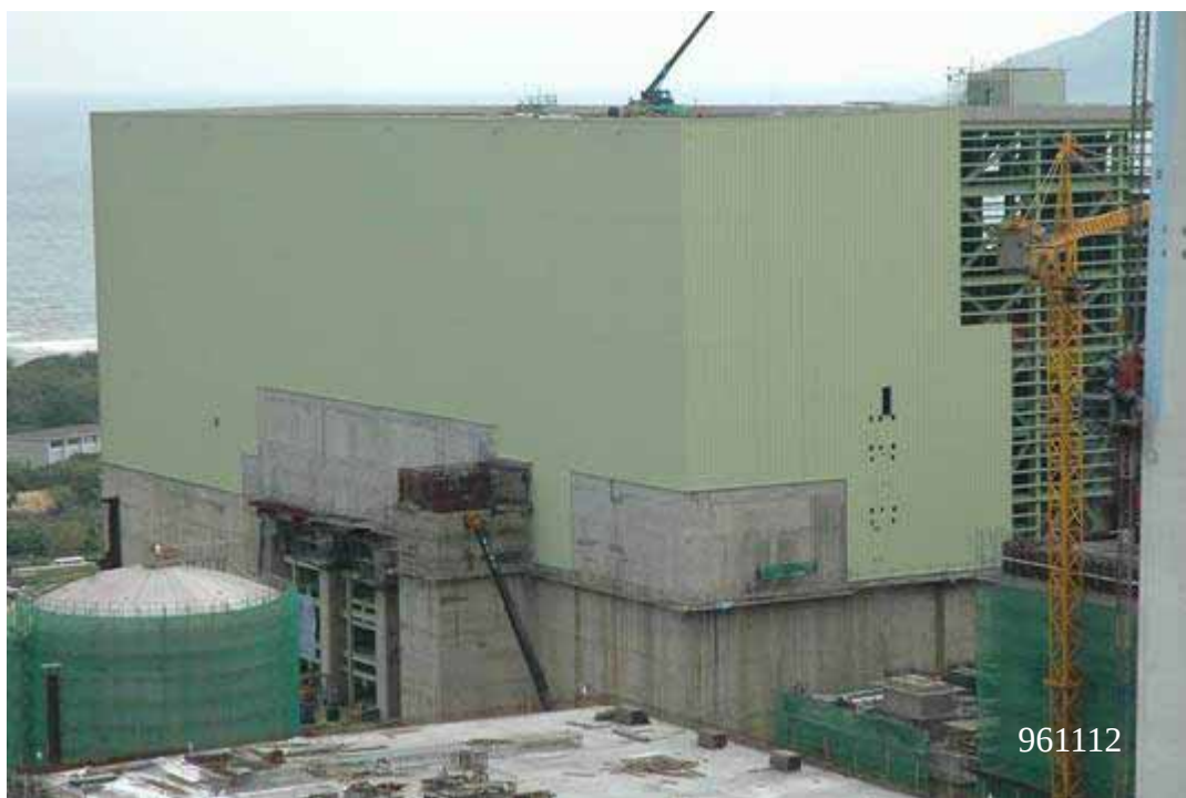
圖五：一號機汽機廠房施工現況圖景
