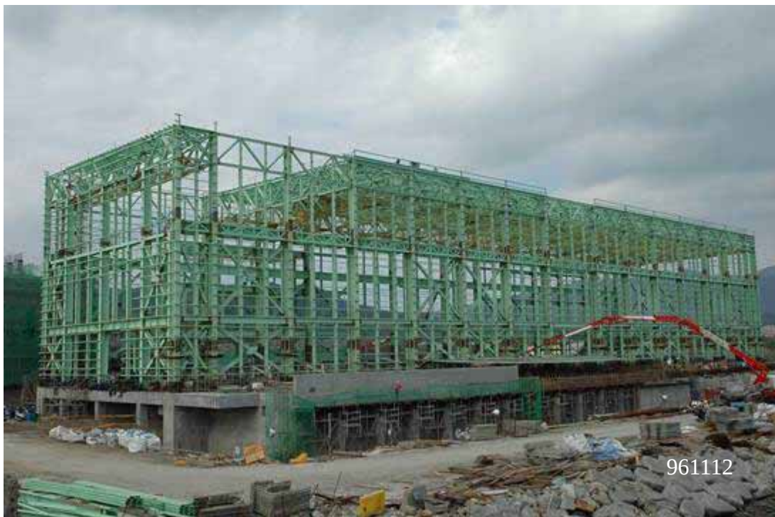
圖四：抽水機廠房施工現況圖景
