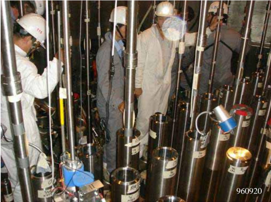
圖九 一號機反應爐內控制棒驅動殼焊接現場一角
