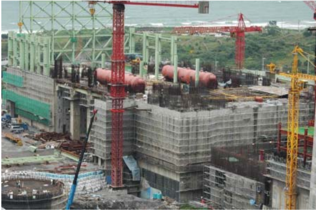
圖五：一號機汽機廠房施工現況圖景
