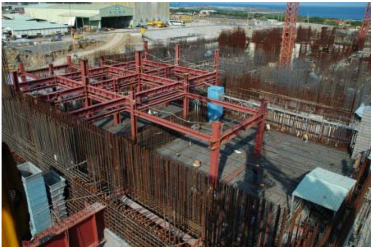
圖四：二號機控制廠房施工現況圖景
