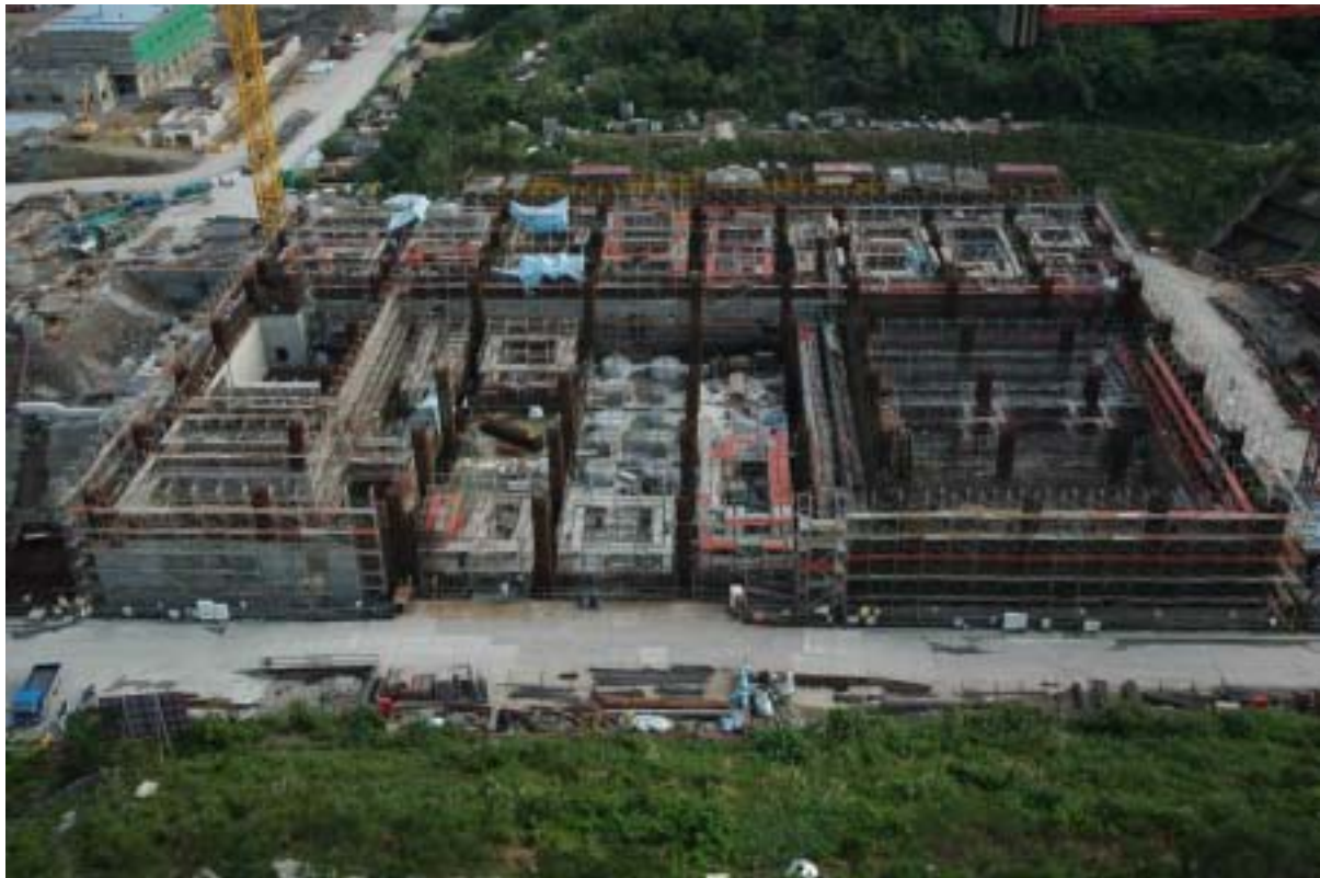
圖八：核廢料廠房施工現況圖景
