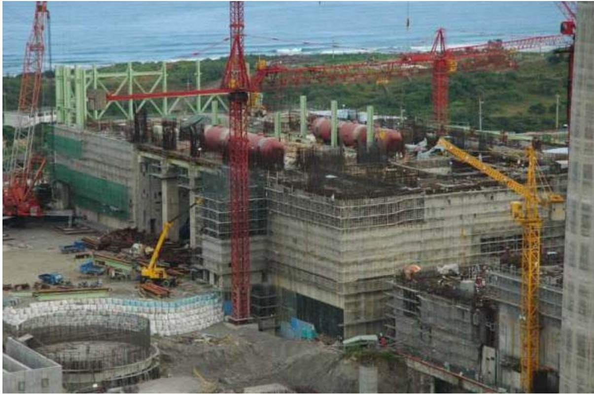
圖五：一號機汽機廠房施工現況圖景
