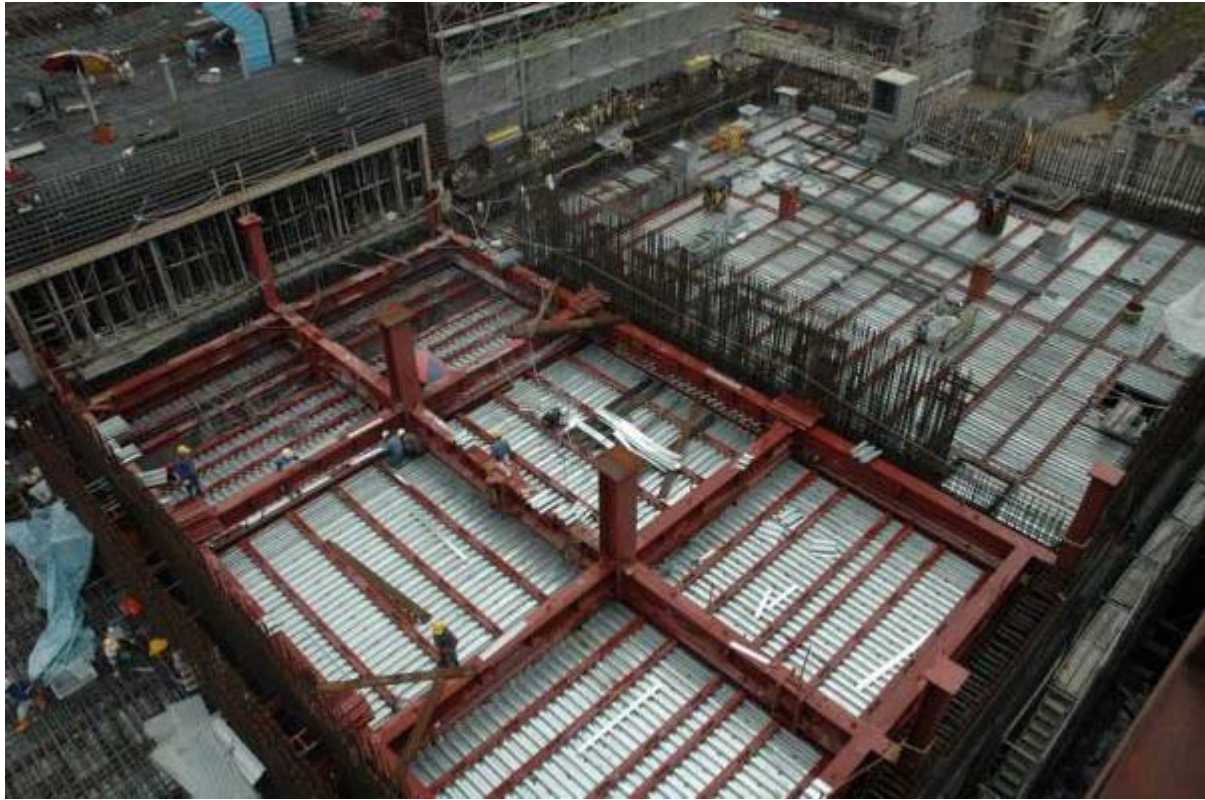
圖三：一號機控制廠房施工現況圖景
