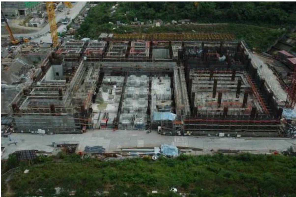
圖八：核廢料廠房施工現況圖景
