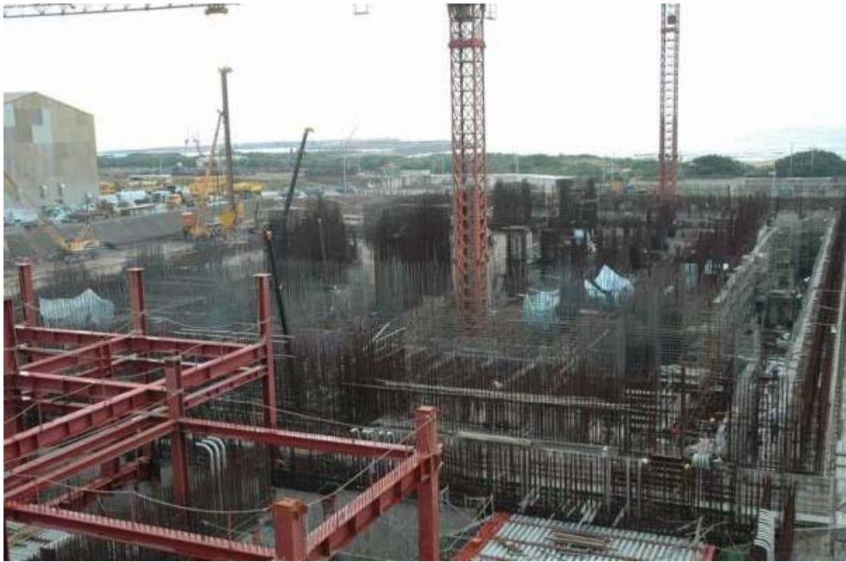
圖六：二號機汽機廠房施工現況圖景
