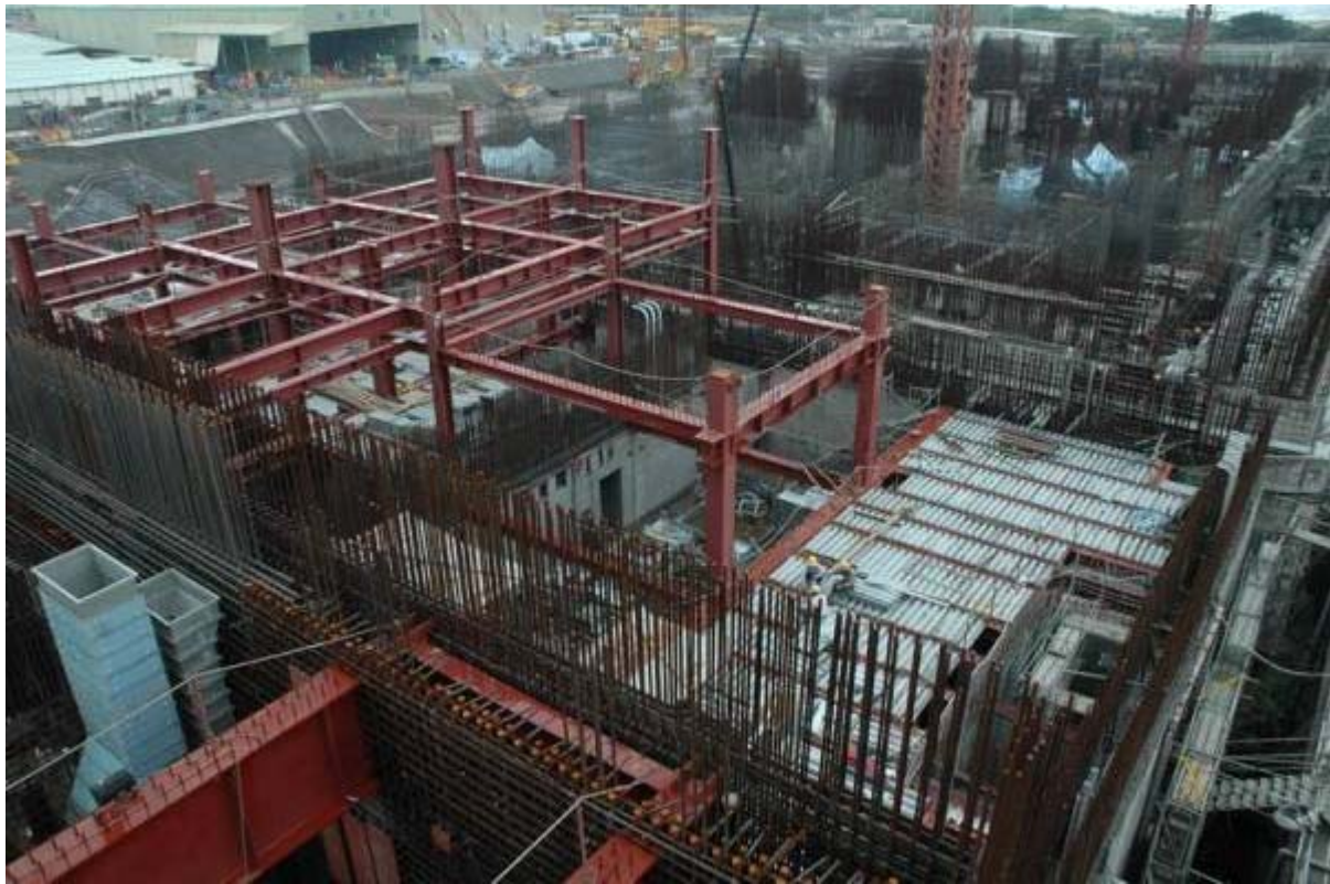
圖四：二號機控制廠房施工現況圖景
