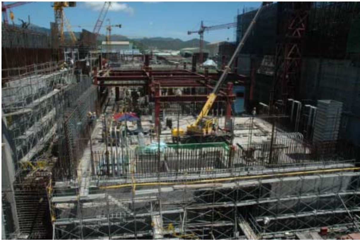
圖三：一號機控制廠房施工現況圖景
