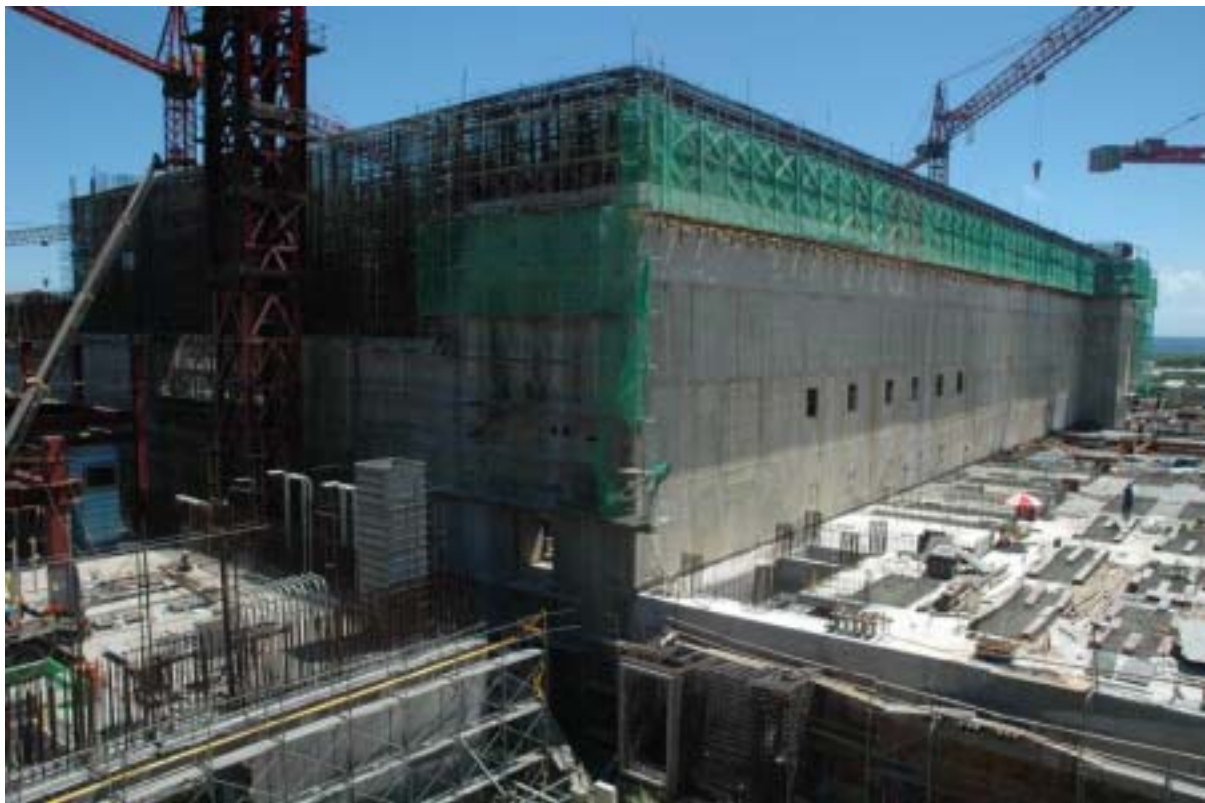
圖四：一號機汽機廠房施工現況圖景
