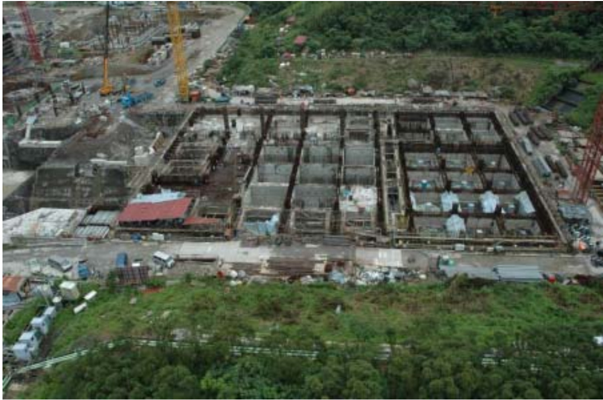
圖七：核廢料廠房施工現況圖景
