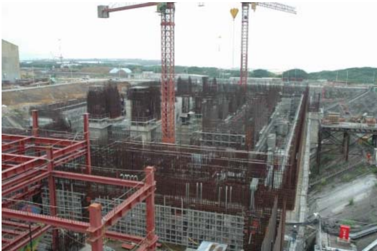
圖五：二號機汽機廠房施工現況圖景
