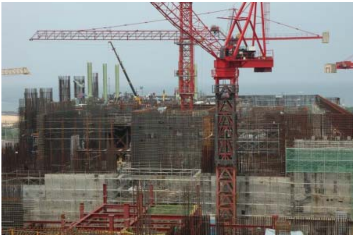
圖四：一號機汽機廠房施工現況圖景
