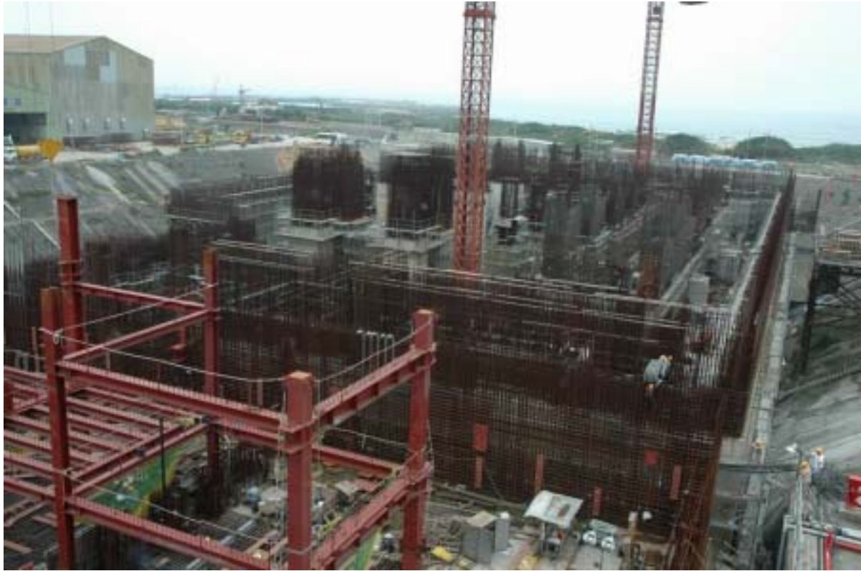
圖五：二號機汽機廠房施工現況圖景
