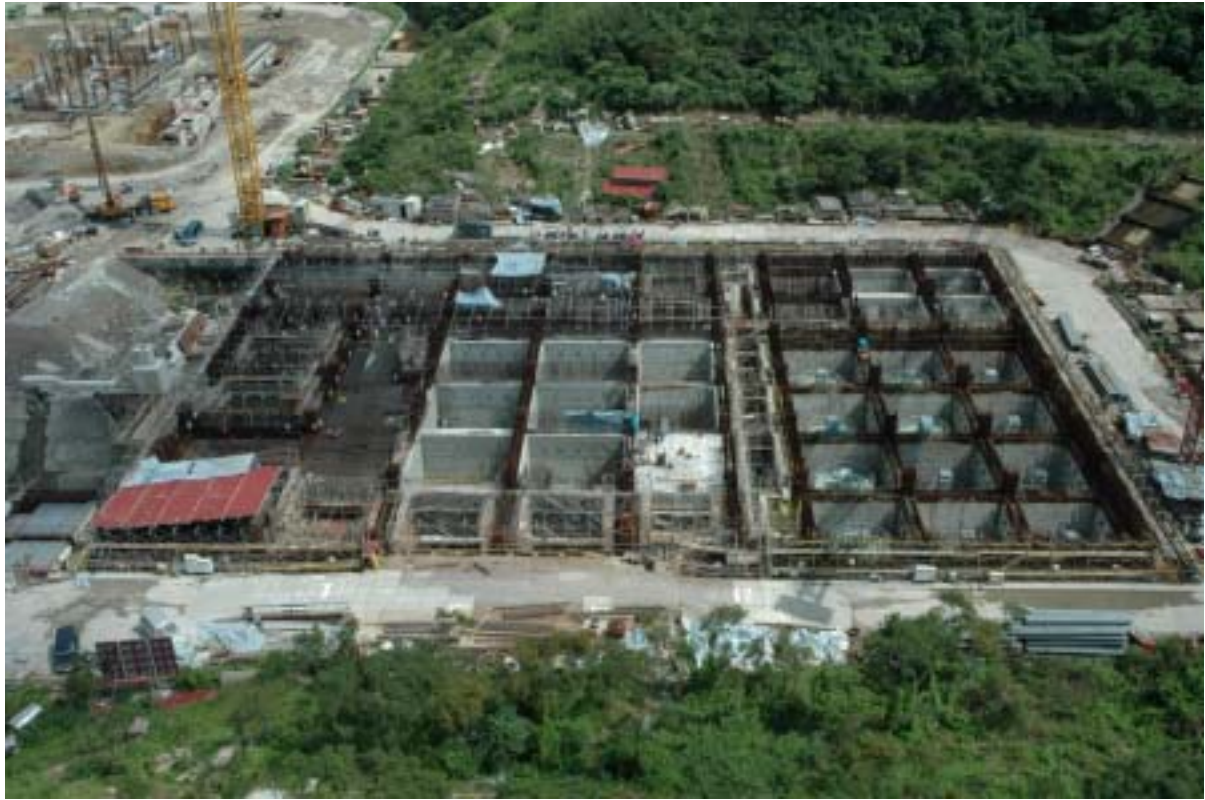
圖七：核廢料廠房施工現況圖景
