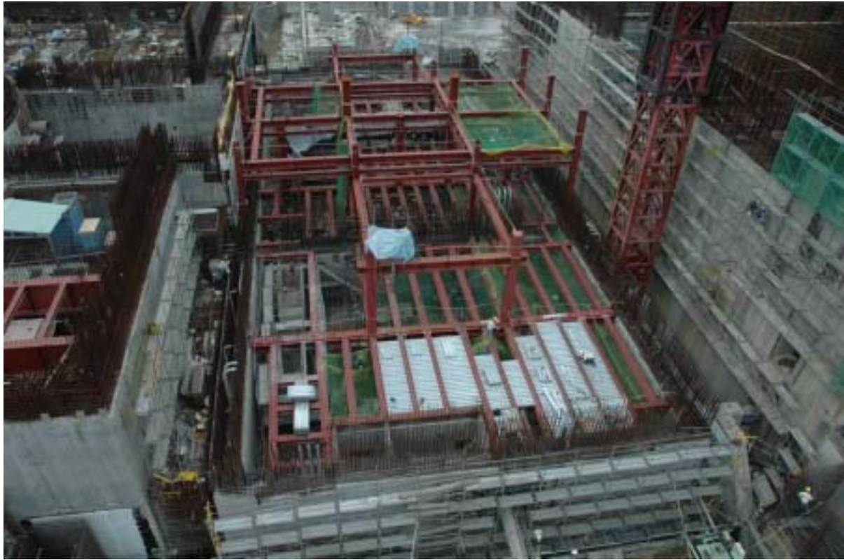
圖三：一號機控制廠房施工現況圖景
