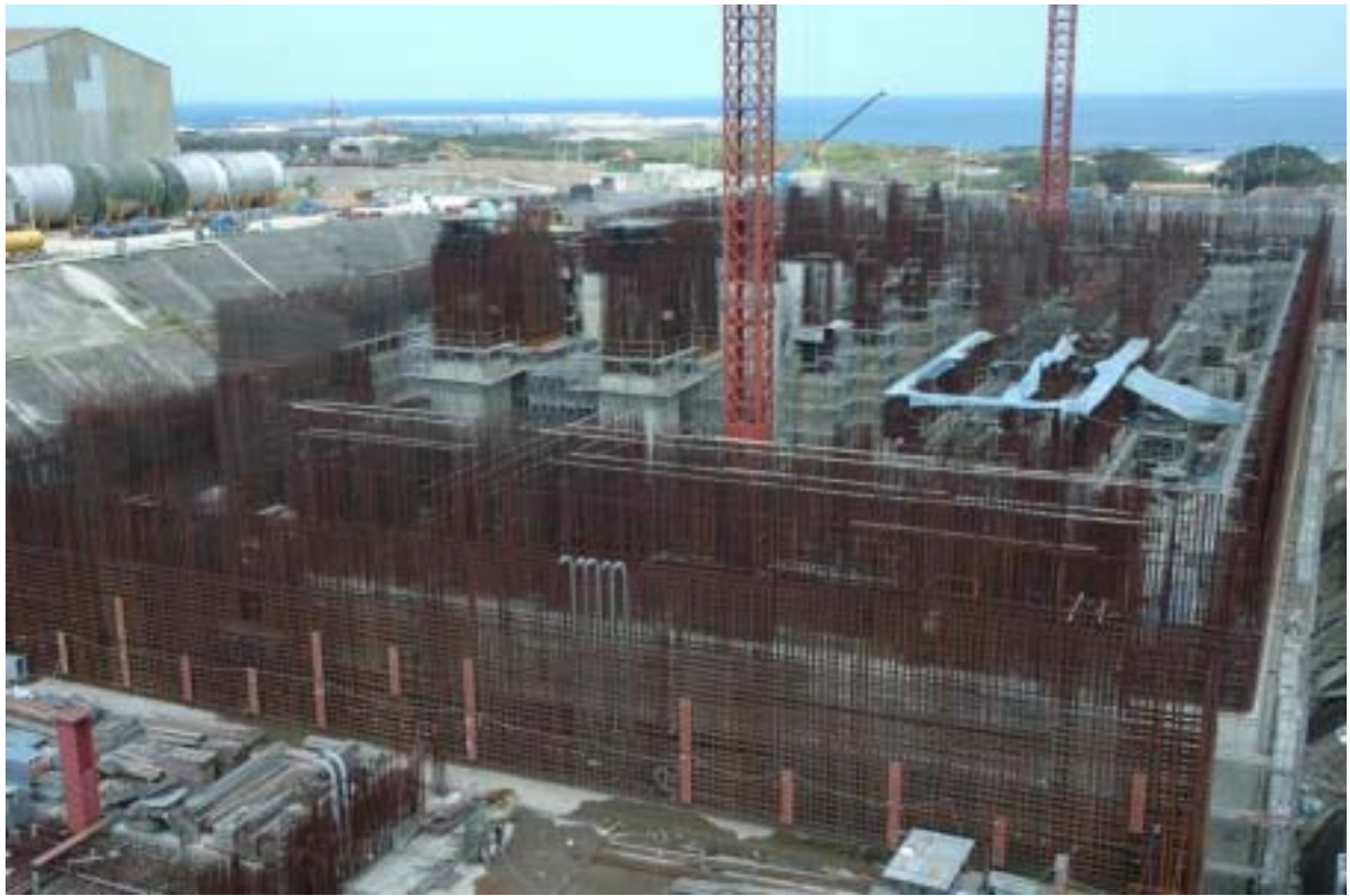
圖五：二號機汽機廠房施工現況圖景
