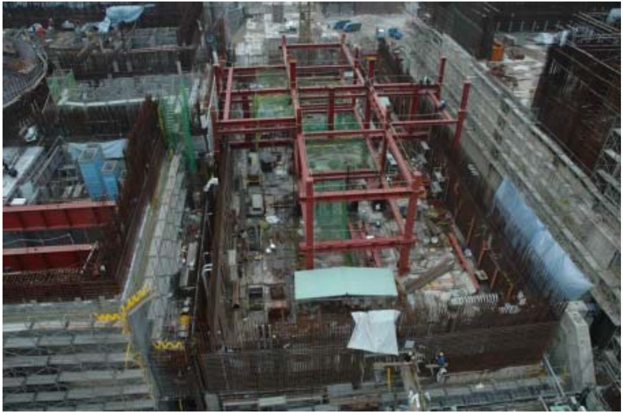
圖三：一號機控制廠房施工現況圖景
