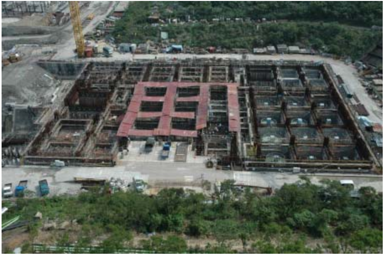
圖七：核廢料廠房施工現況圖景
