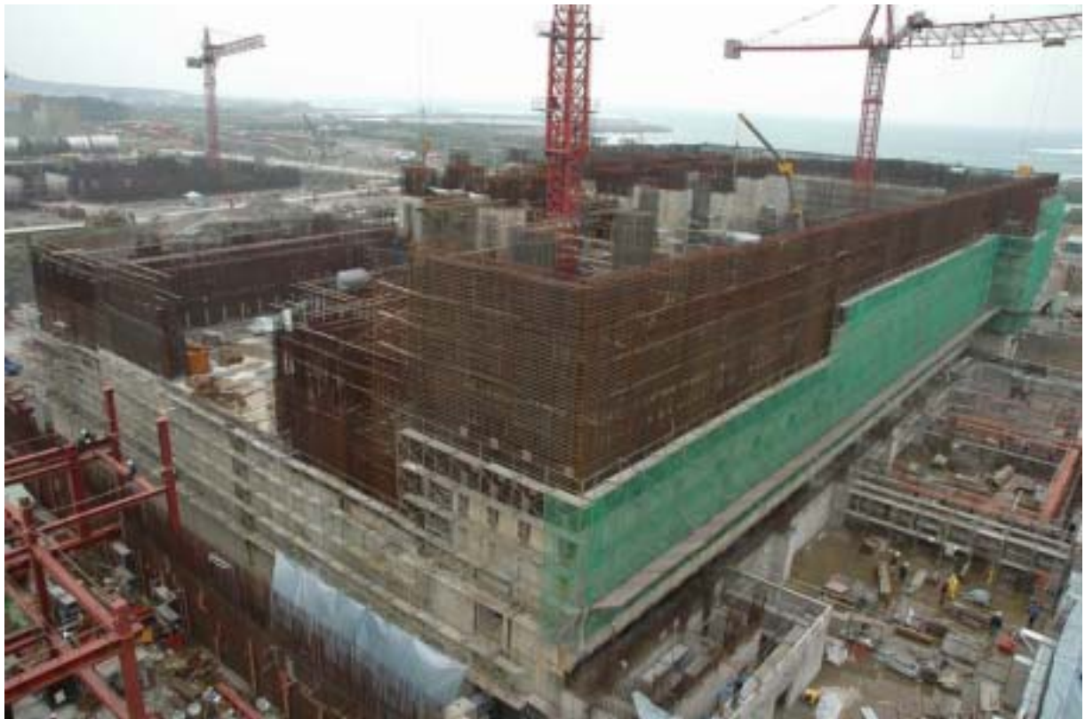
圖四：一號機汽機廠房施工現況圖景
