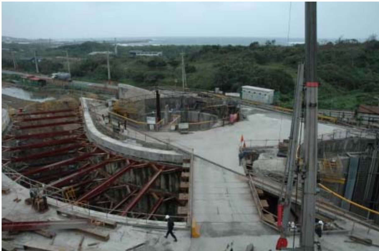
圖八：出水隧道出發井施工現況圖景
