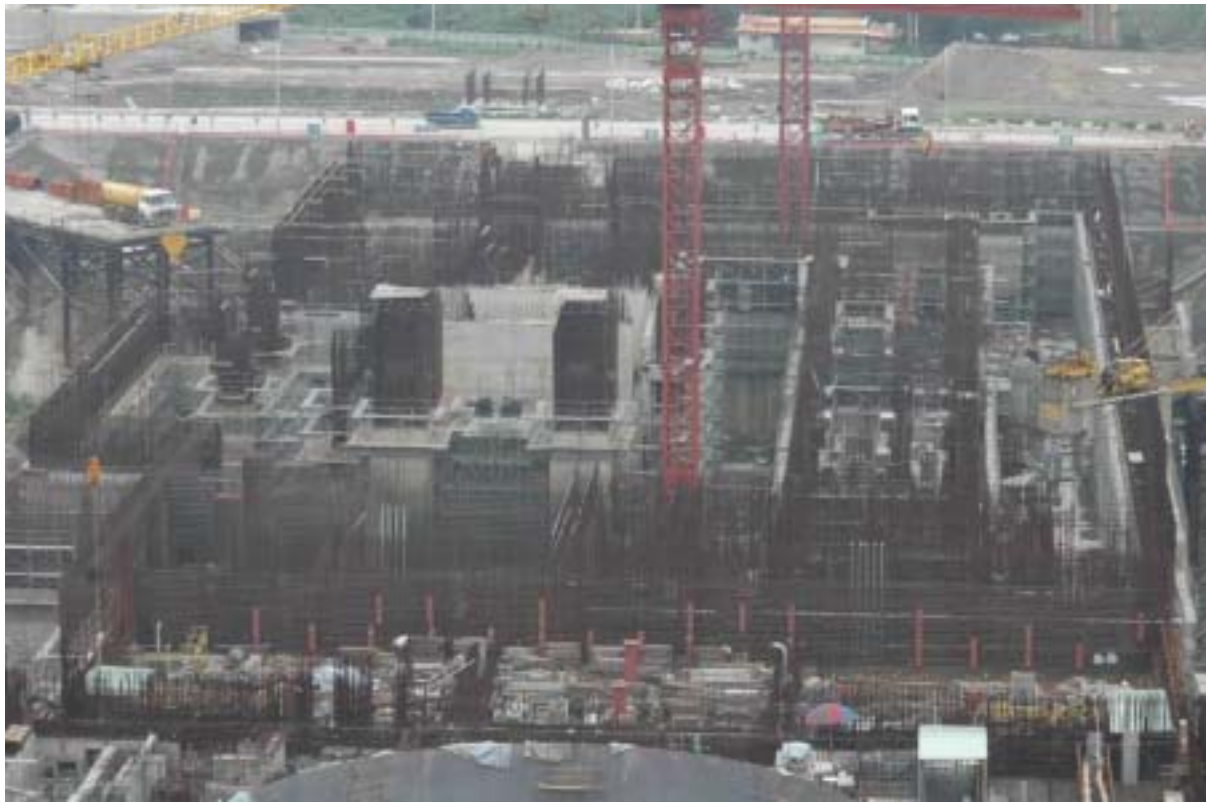
圖五：二號機汽機廠房施工現況圖景
