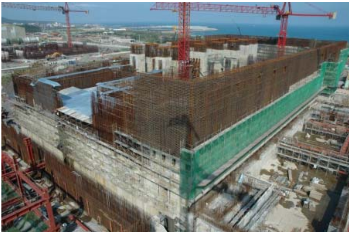
圖四：一號機汽機廠房施工現況圖景
