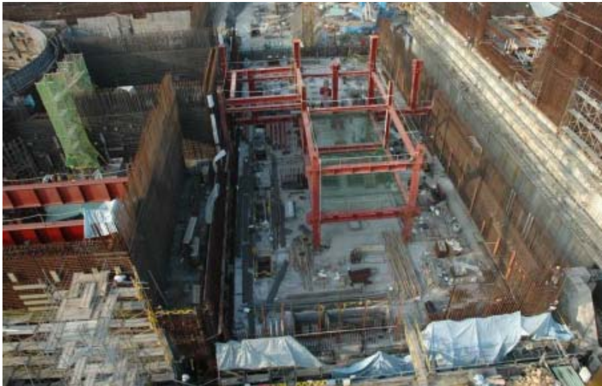
圖三：一號機控制廠房施工現況圖景
