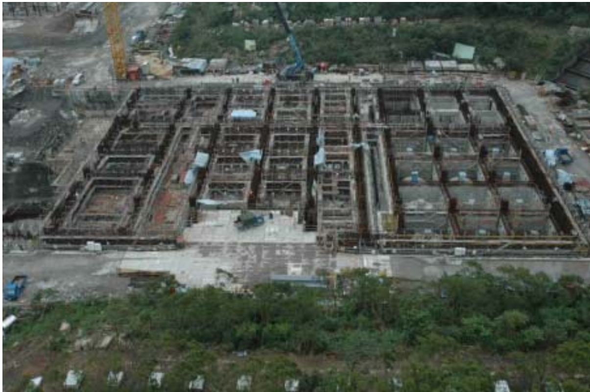
圖七：核廢料廠房施工現況圖景
