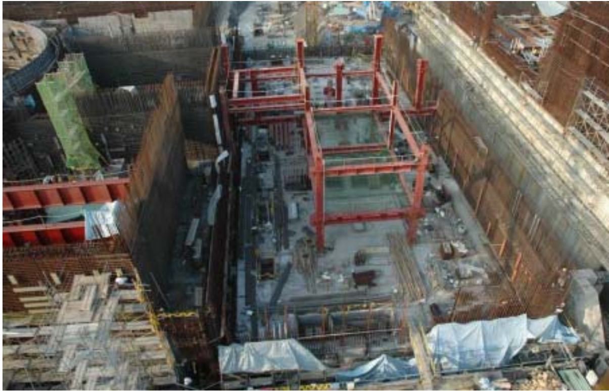
圖三：一號機控制廠房施工現況圖景
