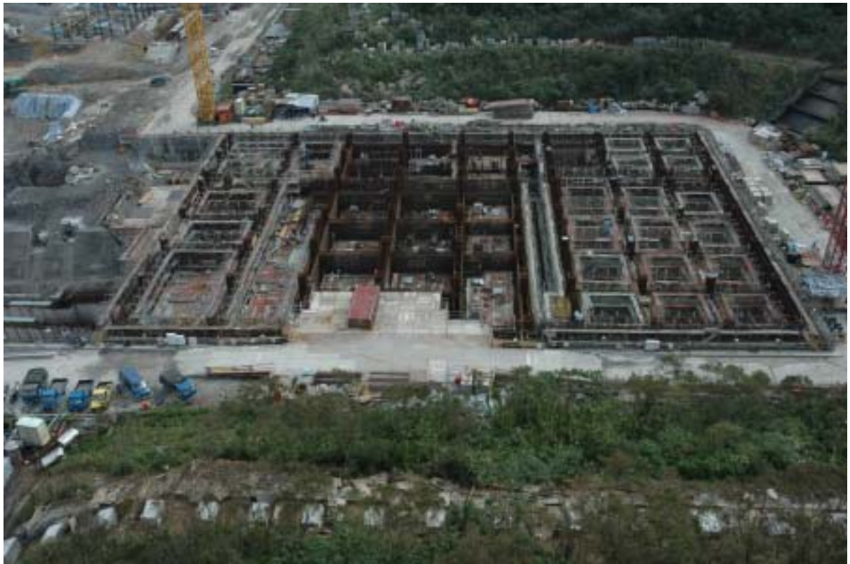
圖七：核廢料廠房施工現況圖景
