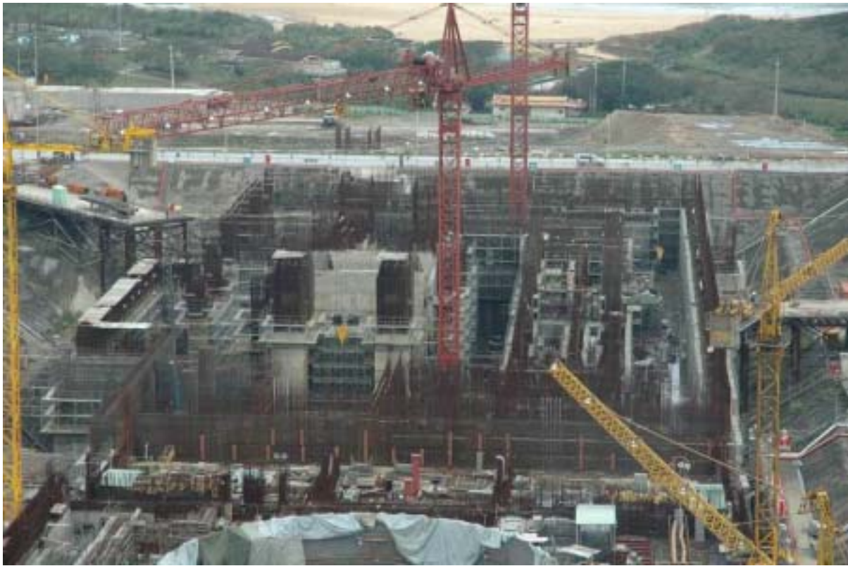
圖五：二號機汽機廠房施工現況圖景
