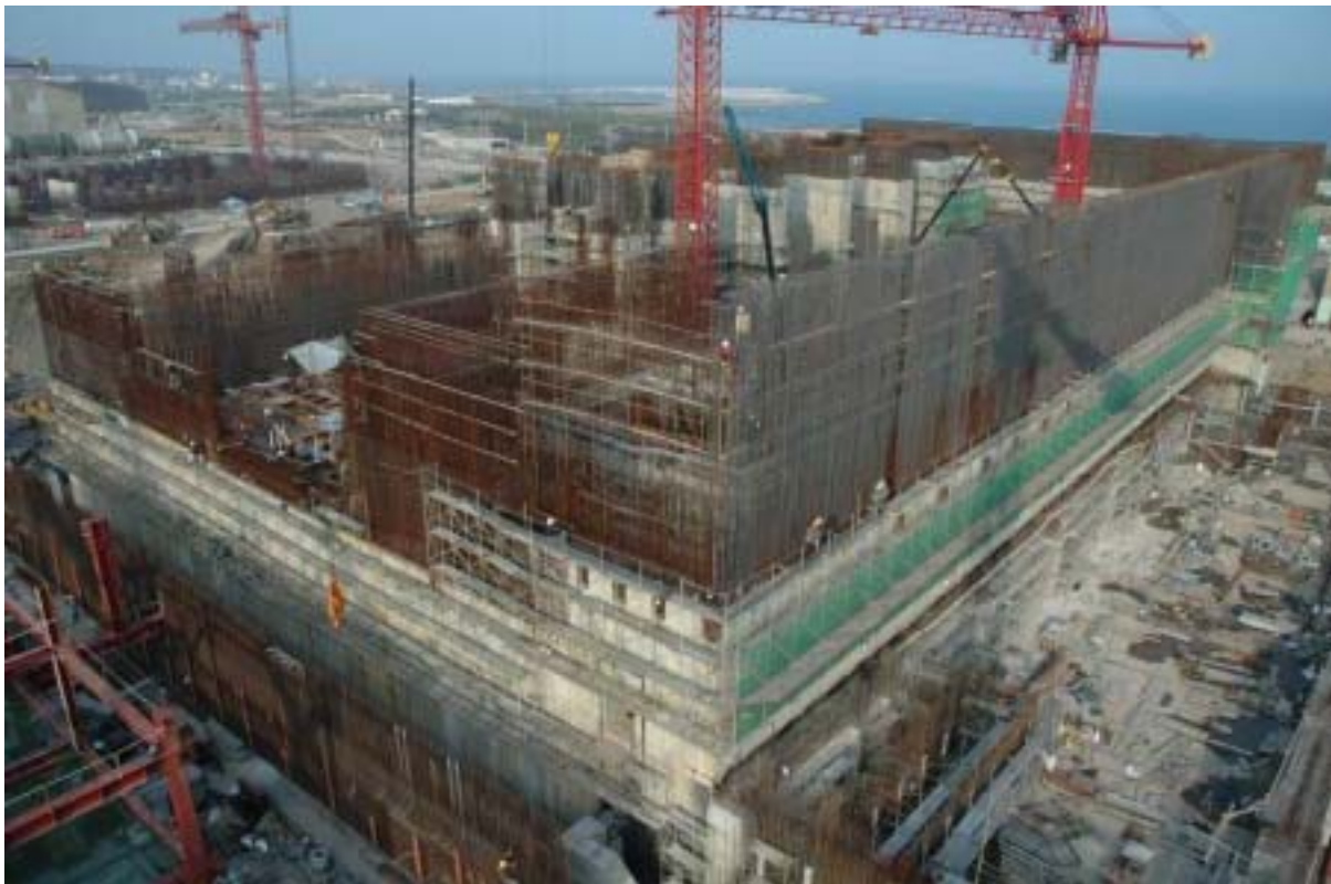
圖四：一號機汽機廠房施工現況圖景
