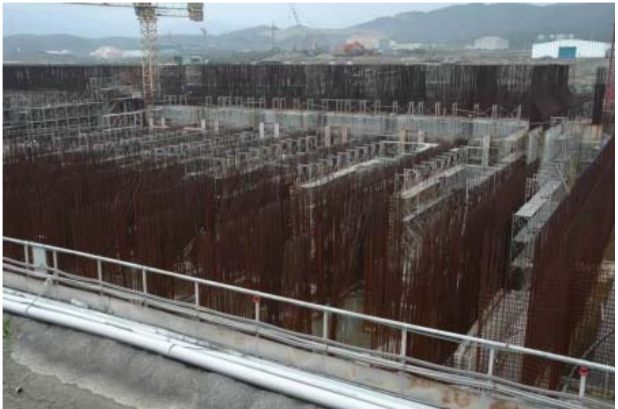
圖八：抽水機房施工現況圖景
