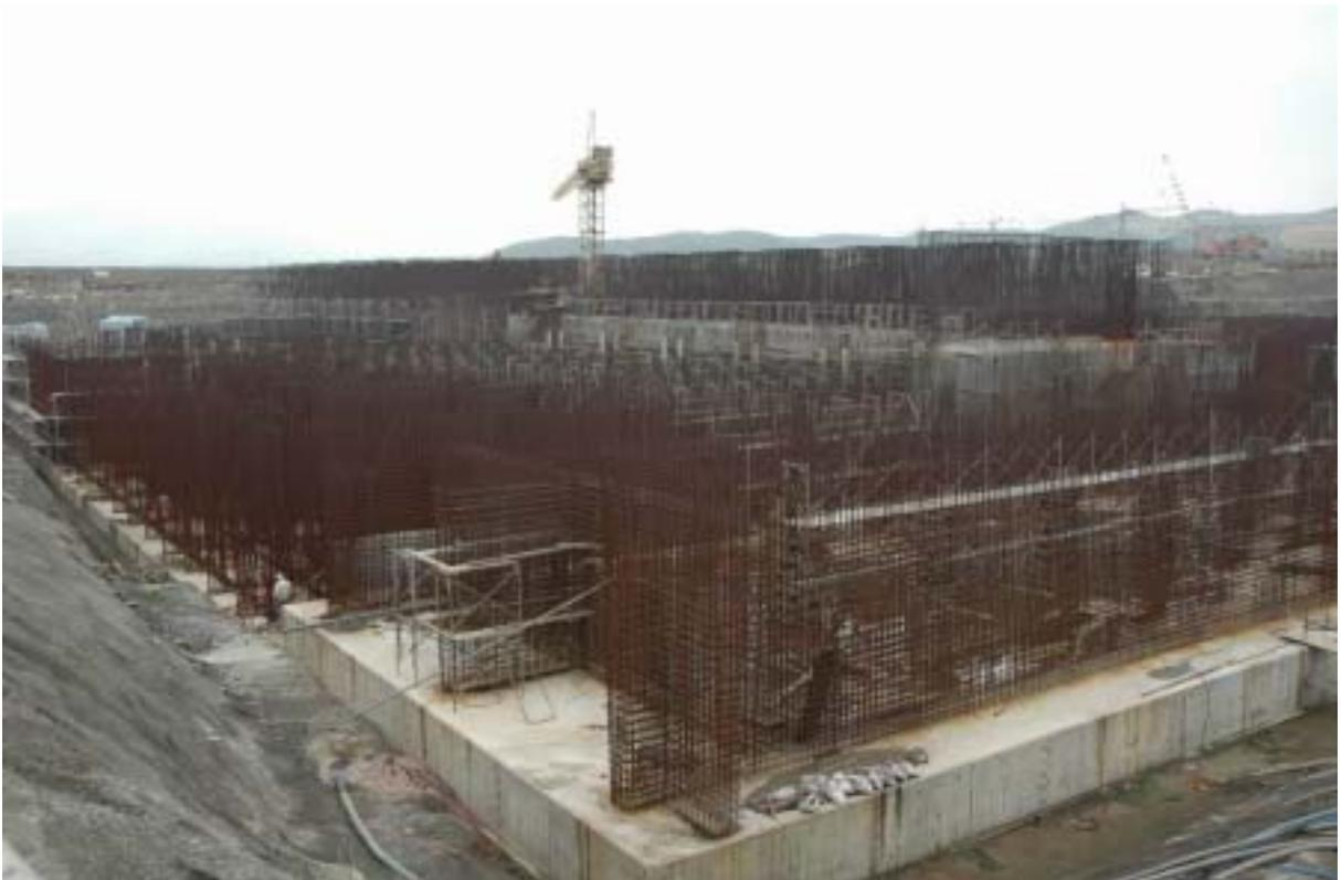
圖八：抽水機房施工現況圖景
