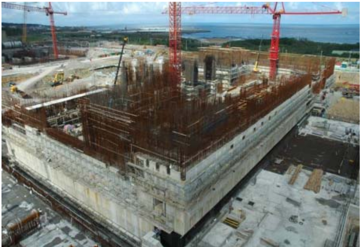
圖四：一號機汽機廠房施工現況圖景
