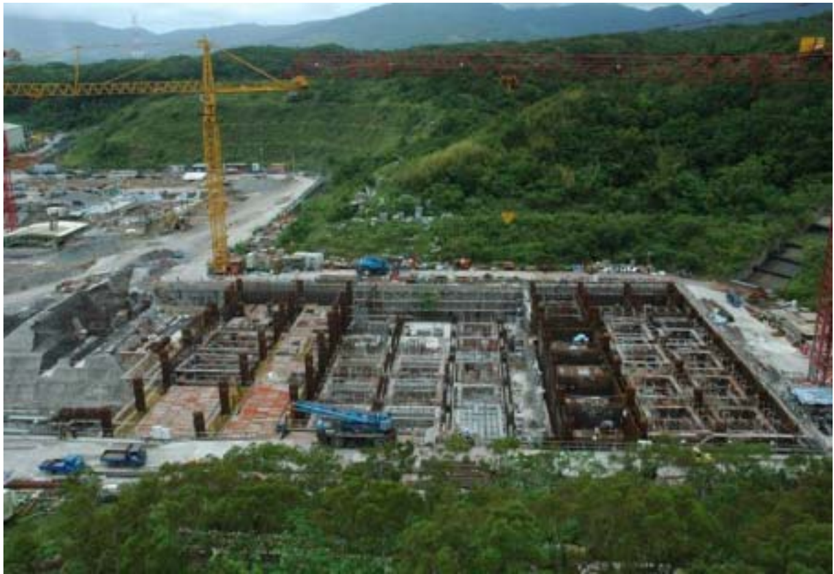
圖七：核廢料廠房施工現況圖景
