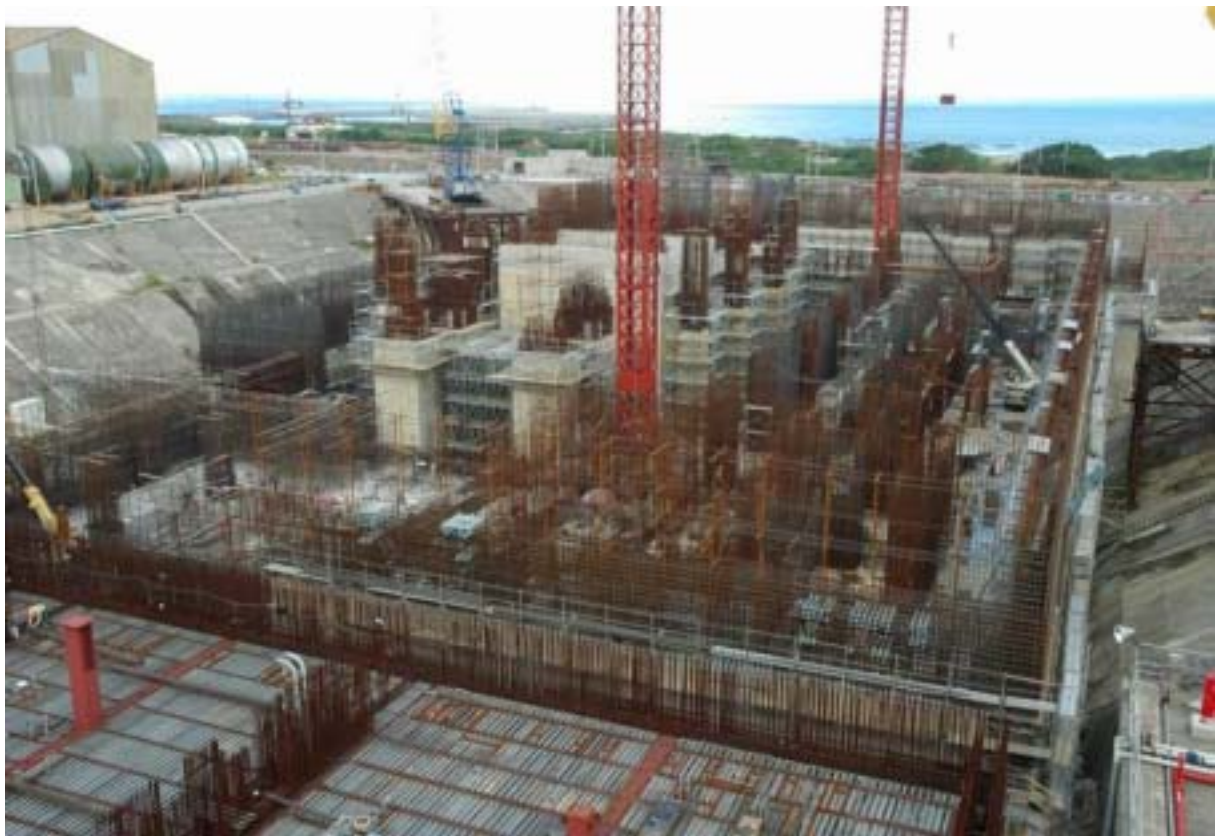
圖五：二號機汽機廠房施工現況圖景
