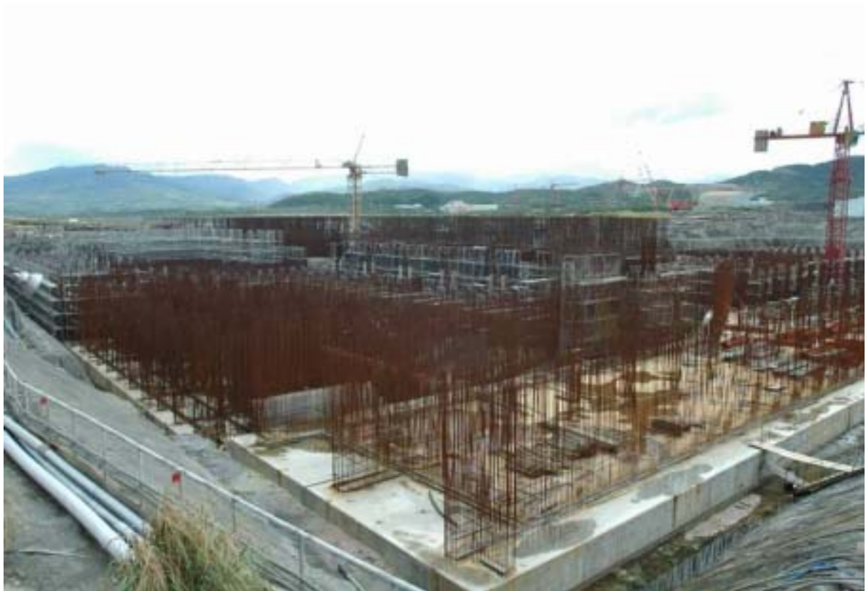
圖八：抽水機房施工現況圖景
