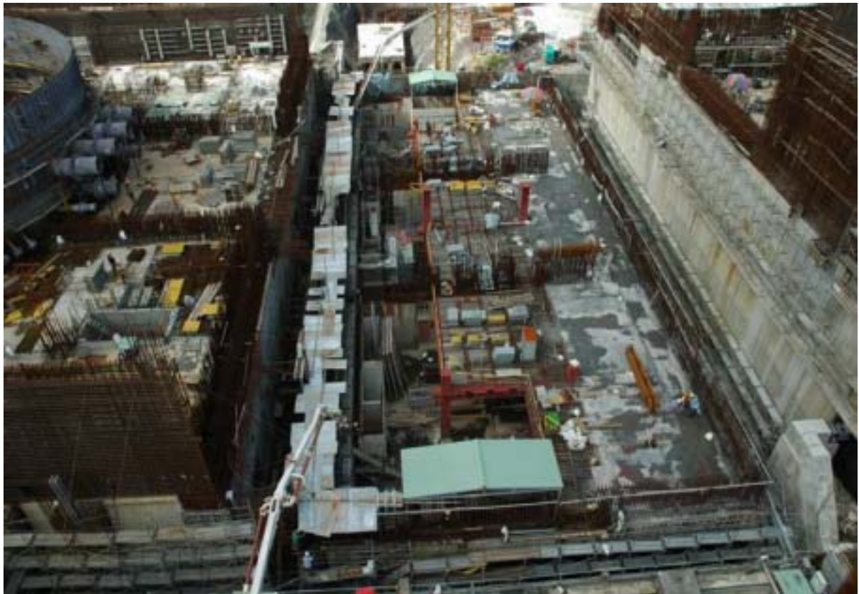
圖三：一號機控制廠房施工現況圖景
