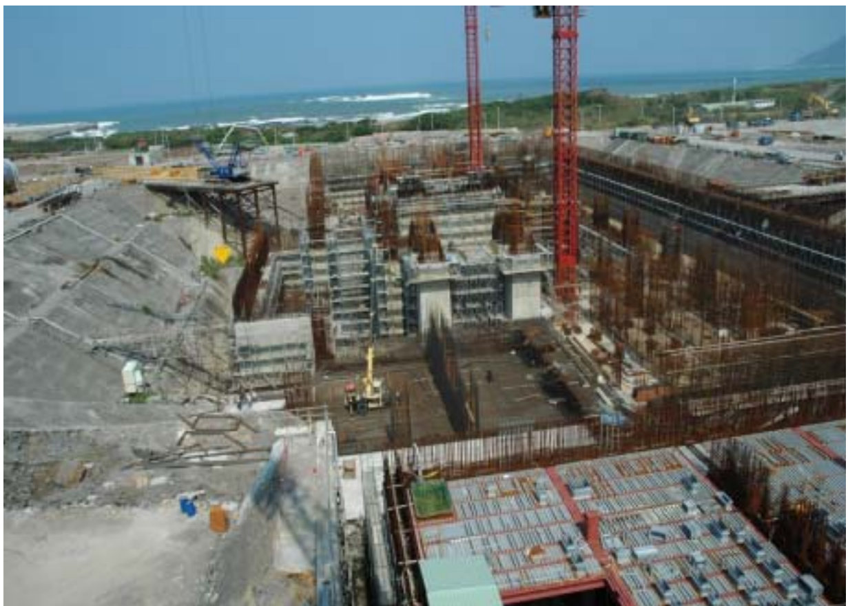
圖四：二號機汽機廠房施工現況圖景
