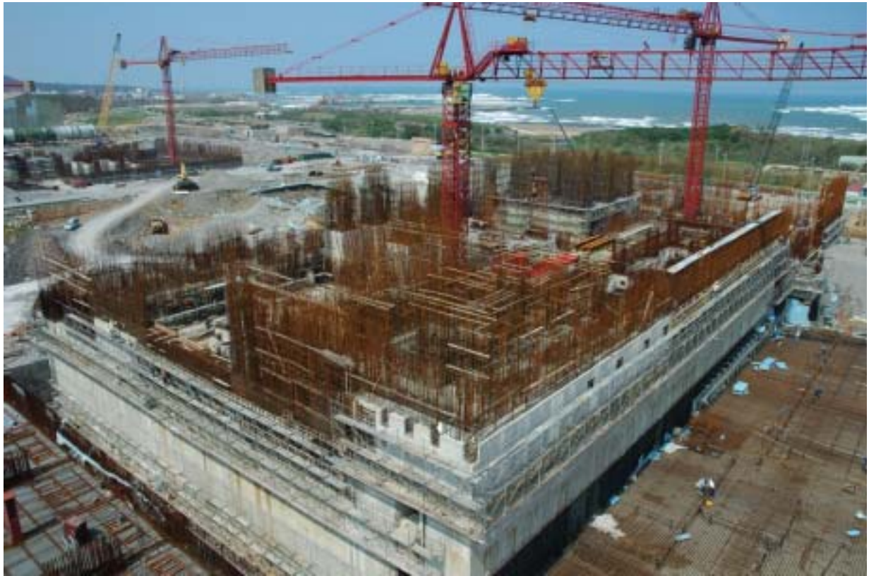
圖三：一號機汽機廠房施工現況圖景
