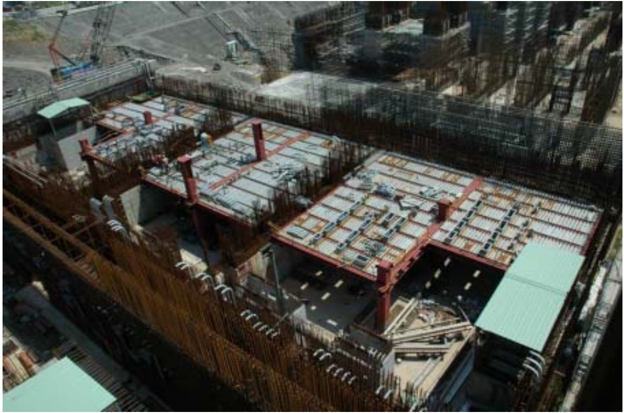
圖三：一號機控制廠房施工現況圖景
