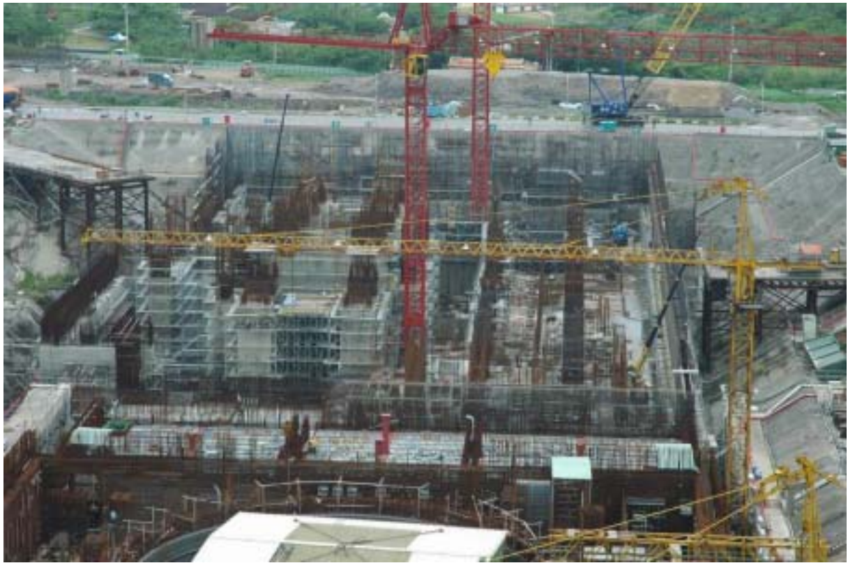
圖五：二號機汽機廠房施工現況圖景
