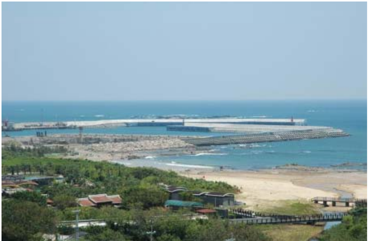
圖八：重件碼頭及南、北防波堤施工現況圖景
