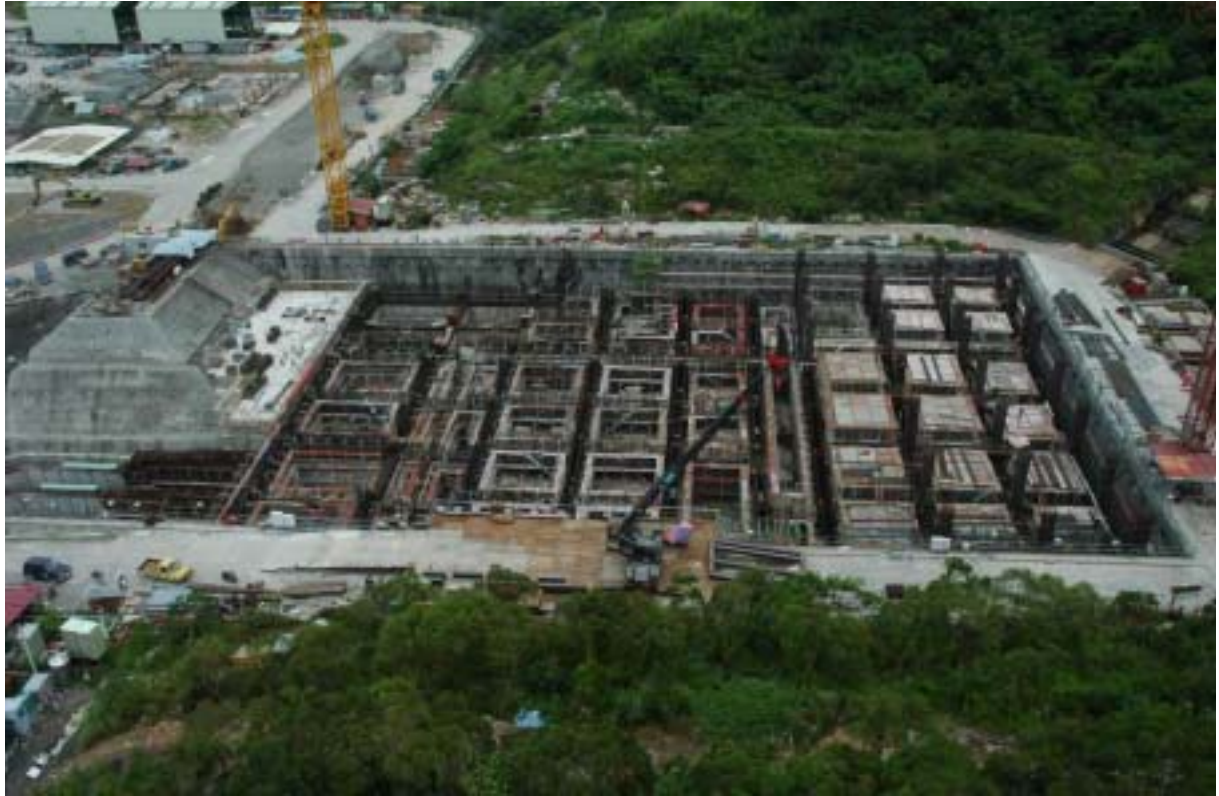
圖七：核廢料廠房施工現況圖景
