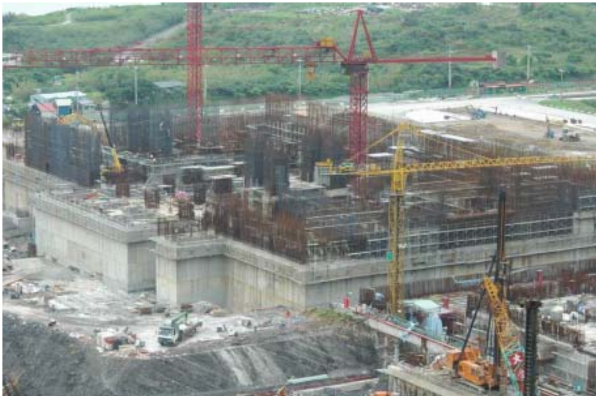
圖四：一號機汽機廠房施工現況圖景
