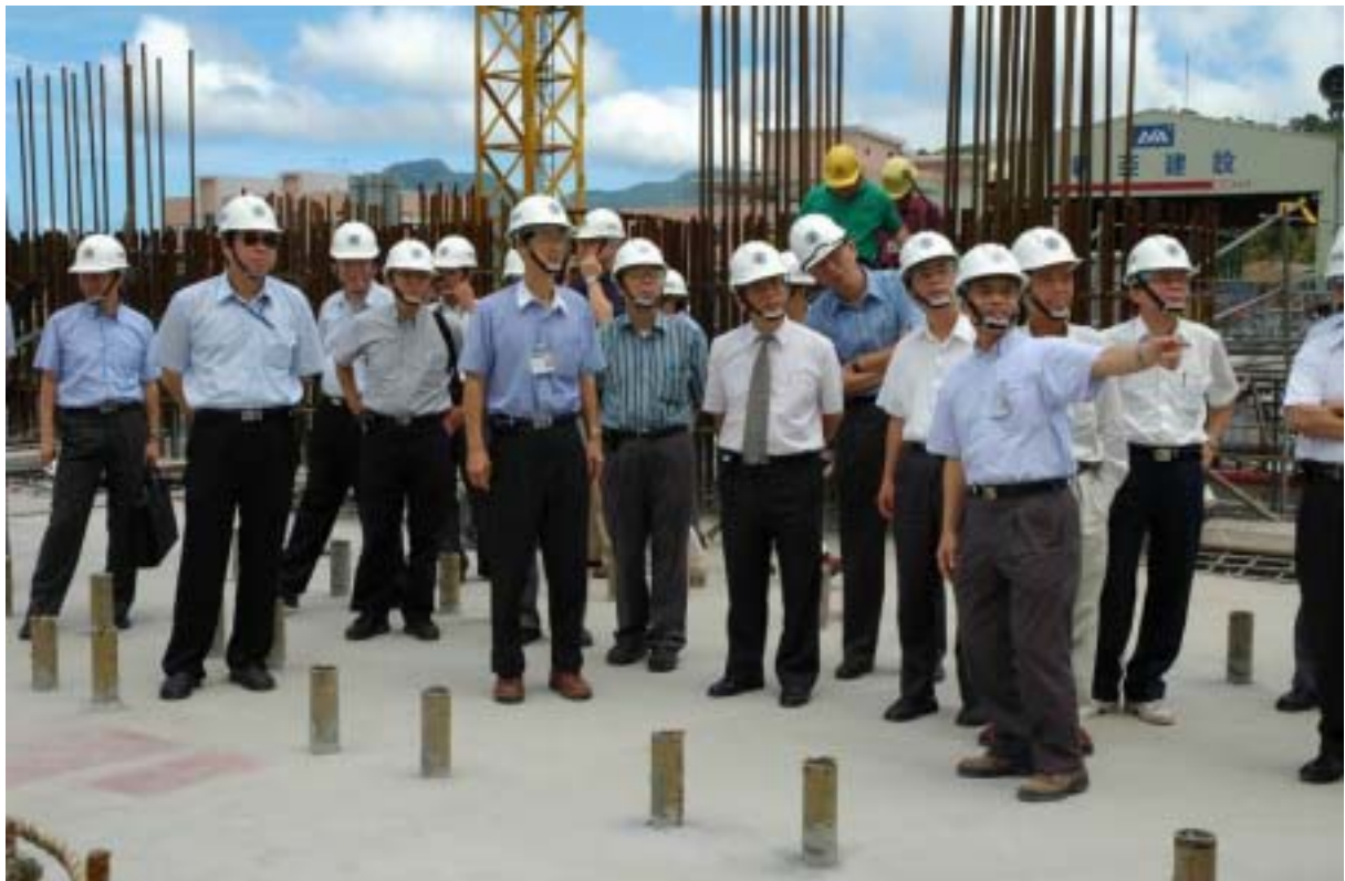
圖四：第五次核能四廠安全監督委員會議之現場巡視（一）
