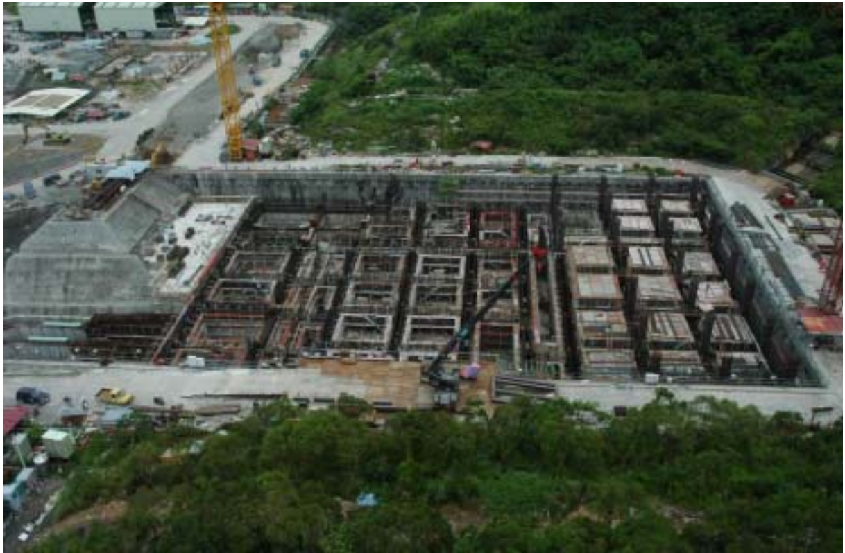
圖七：核廢料廠房施工現況圖景
