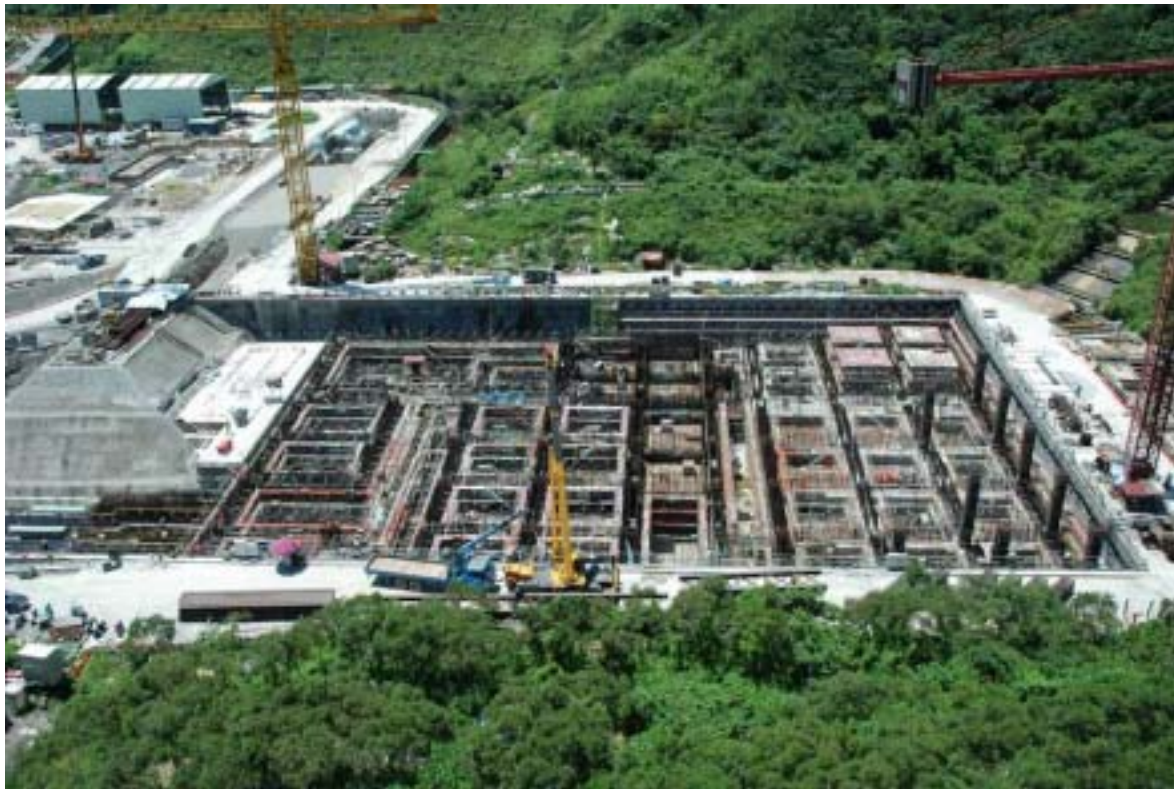
圖八：核廢料廠房施工現況圖景
