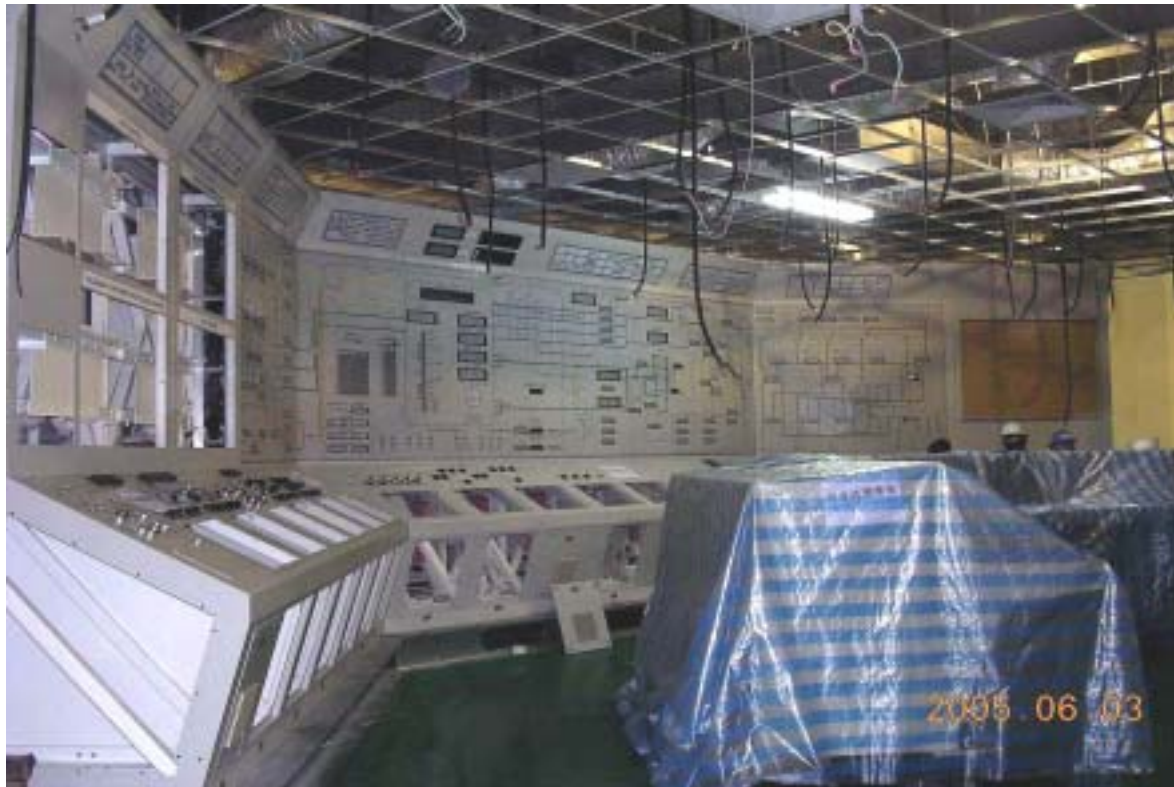
圖六：模擬器安裝工程現況
