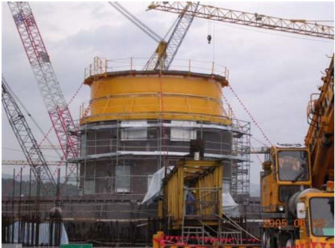
圖二 一號機反應器防撞遮雨棚吊裝後狀況
