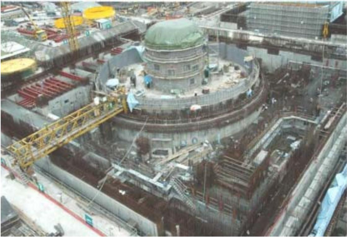
圖一 一號機反應器廠房施工情形(防撞遮雨棚吊裝前)
