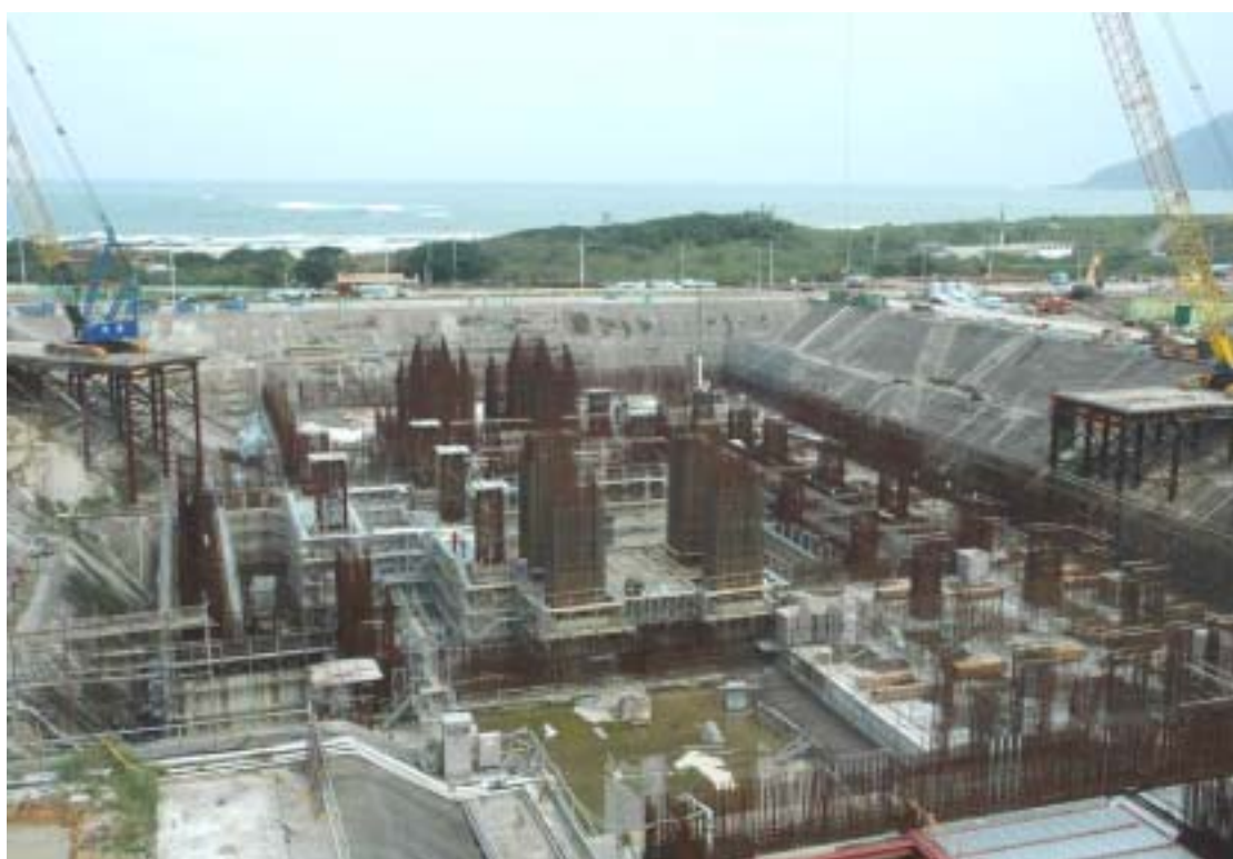
圖四 二號機汽機廠房施工現況圖景
