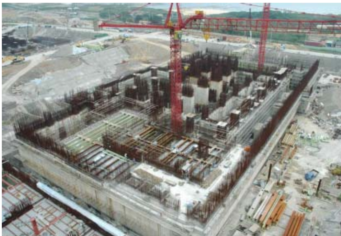
圖三 一號機汽機廠房施工現況圖景
