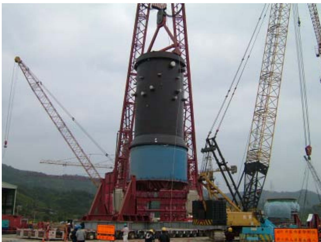
圖六 一號機反應爐壓力容器吊裝現況圖景
