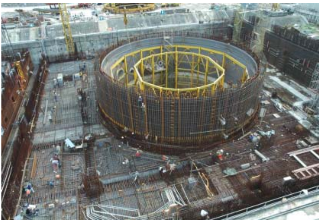
圖二 二號機反應器廠房施工現況圖景
