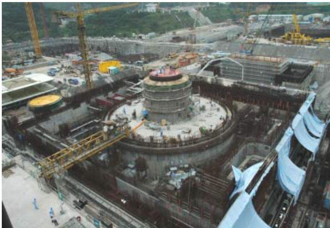
圖一 一號機反應器廠房施工現況圖景
