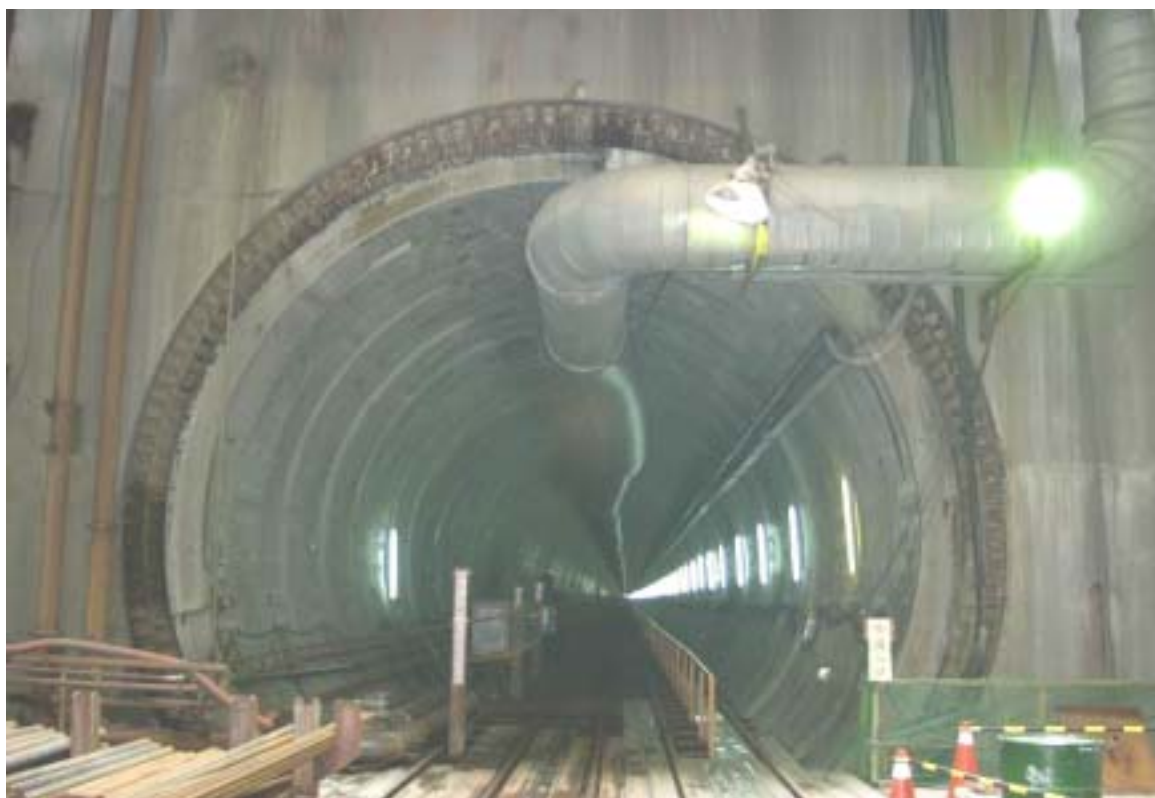
圖五 一號機出水道工程潛盾隧道施工圖景
