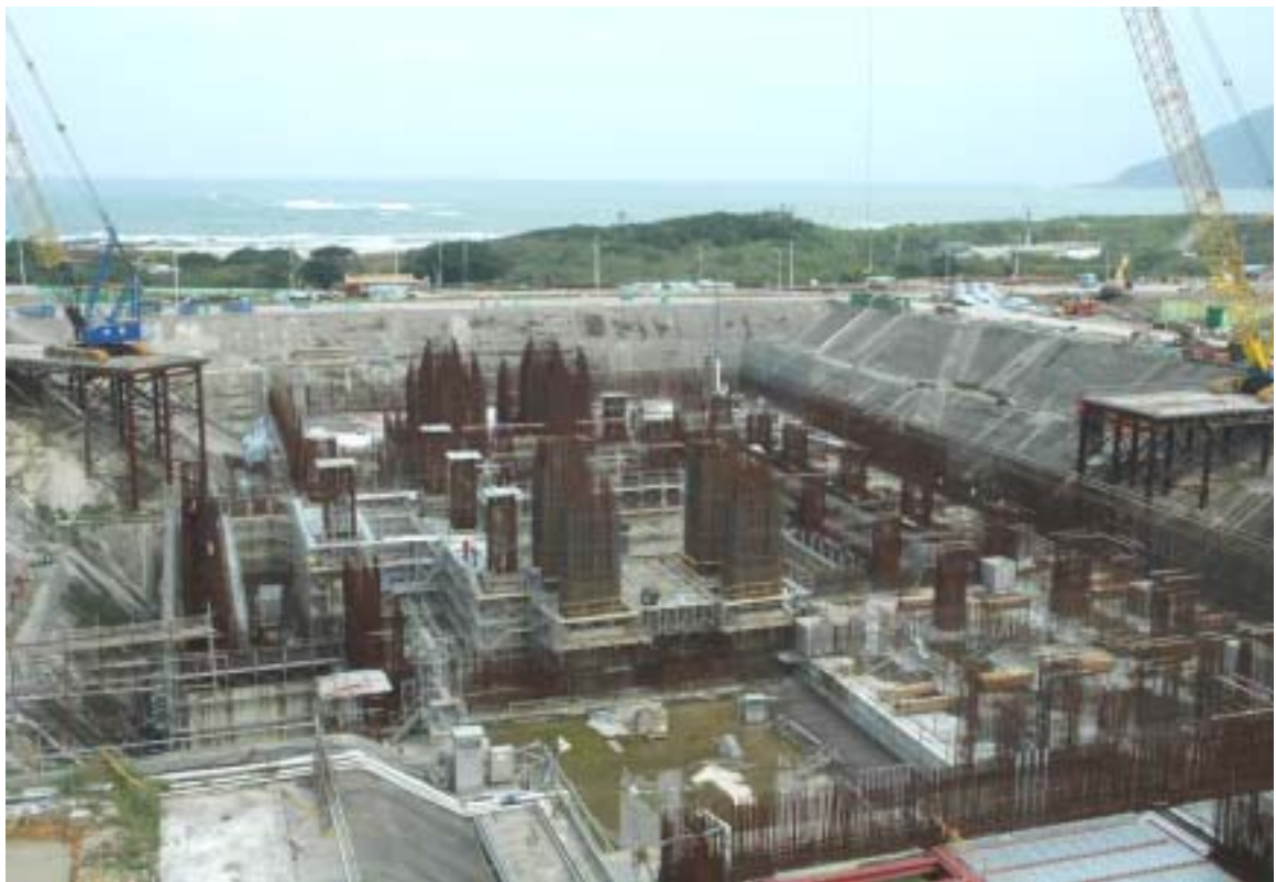
圖四 二號機汽機廠房施工現況圖景
