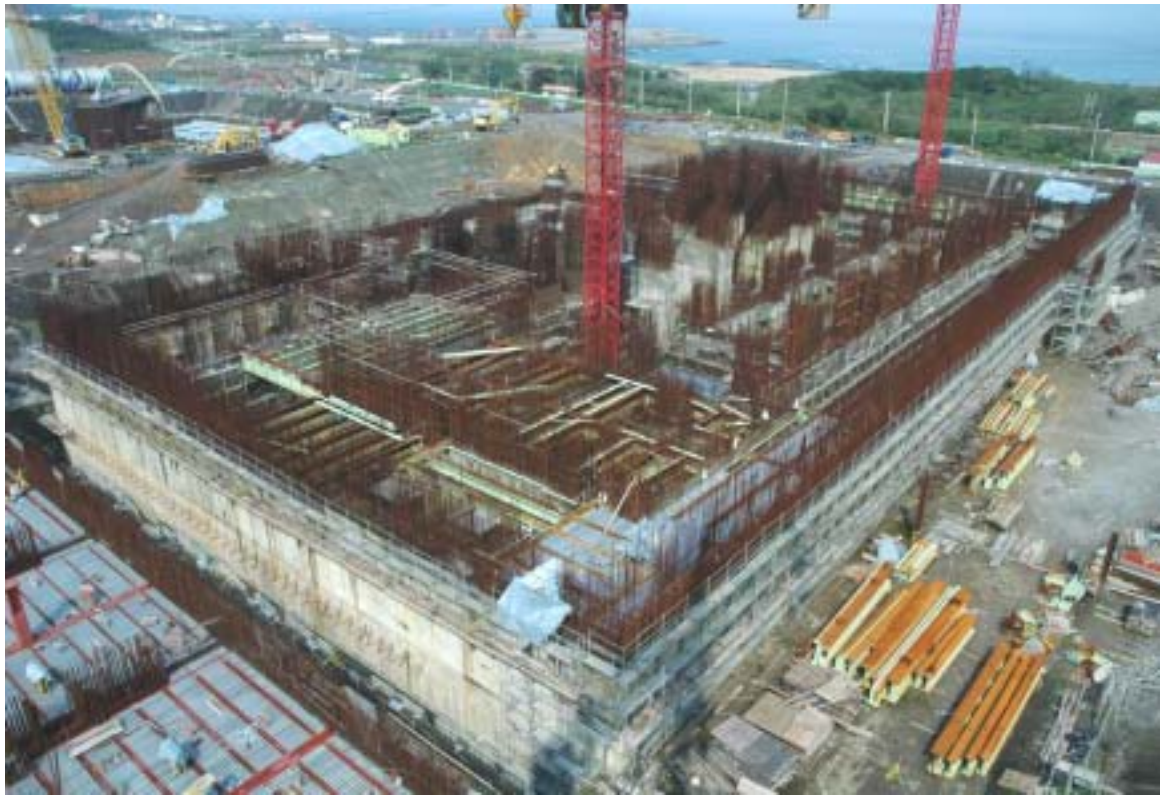
圖三 一號機汽機廠房施工現況圖景
