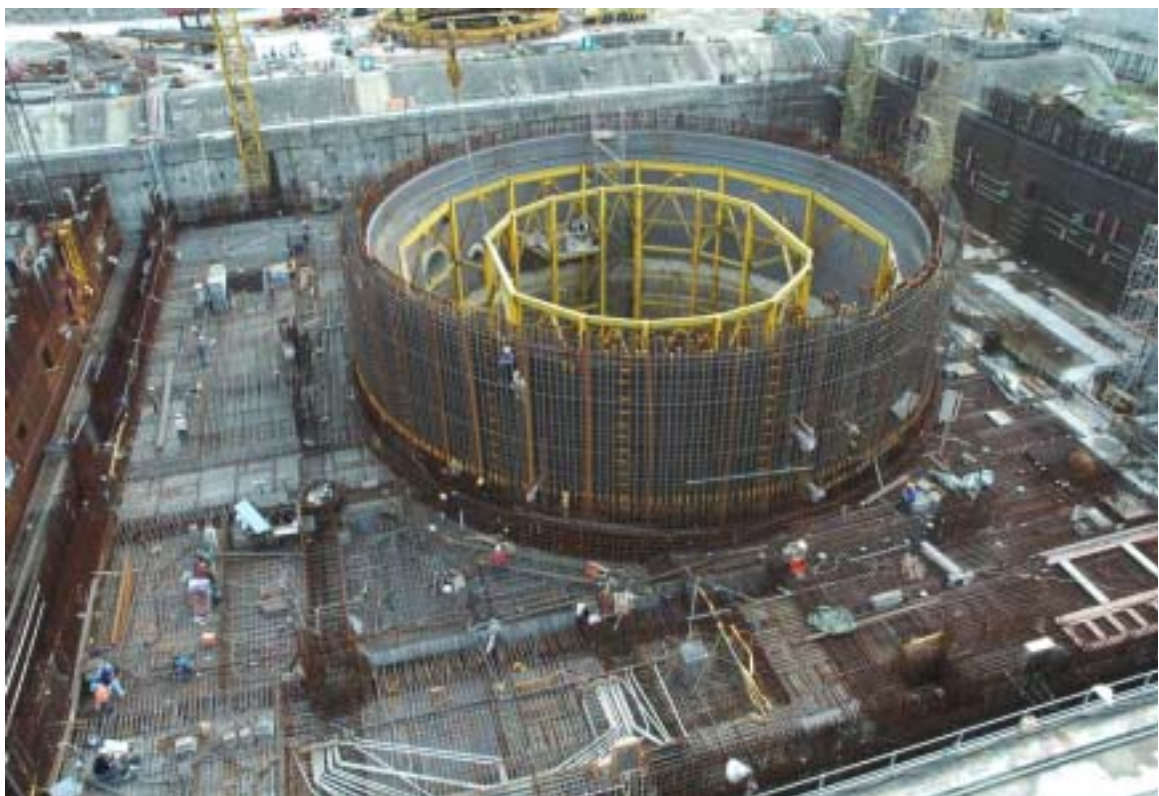
圖二 二號機反應器廠房施工現況圖景
