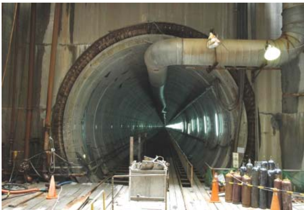
圖六 二號機出水道工程潛盾隧道施工圖景
