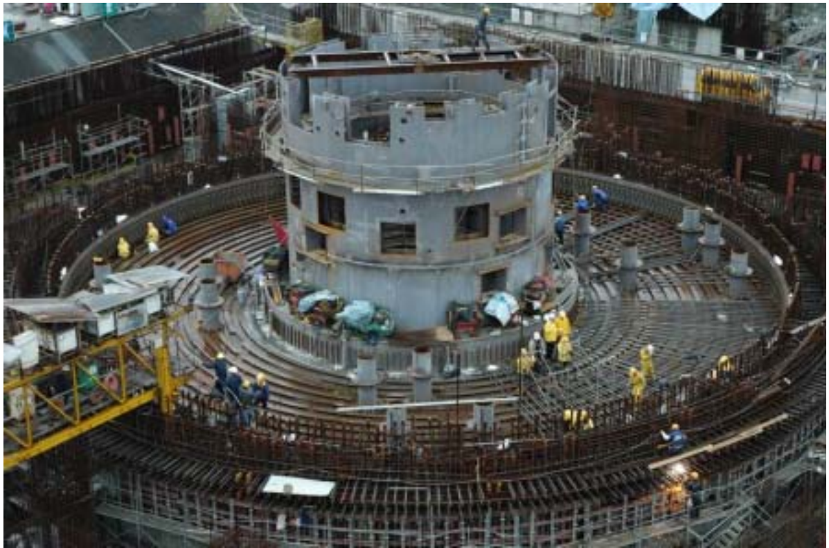
照片一：一號機反應器廠房施工現況圖景 (基座上已吊裝生物屏壁牆)
