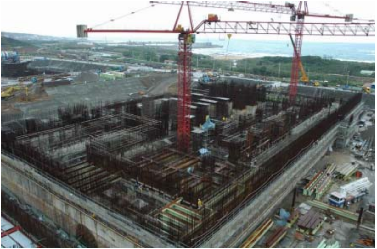
照片三：一號機汽機廠房施工現況圖景
