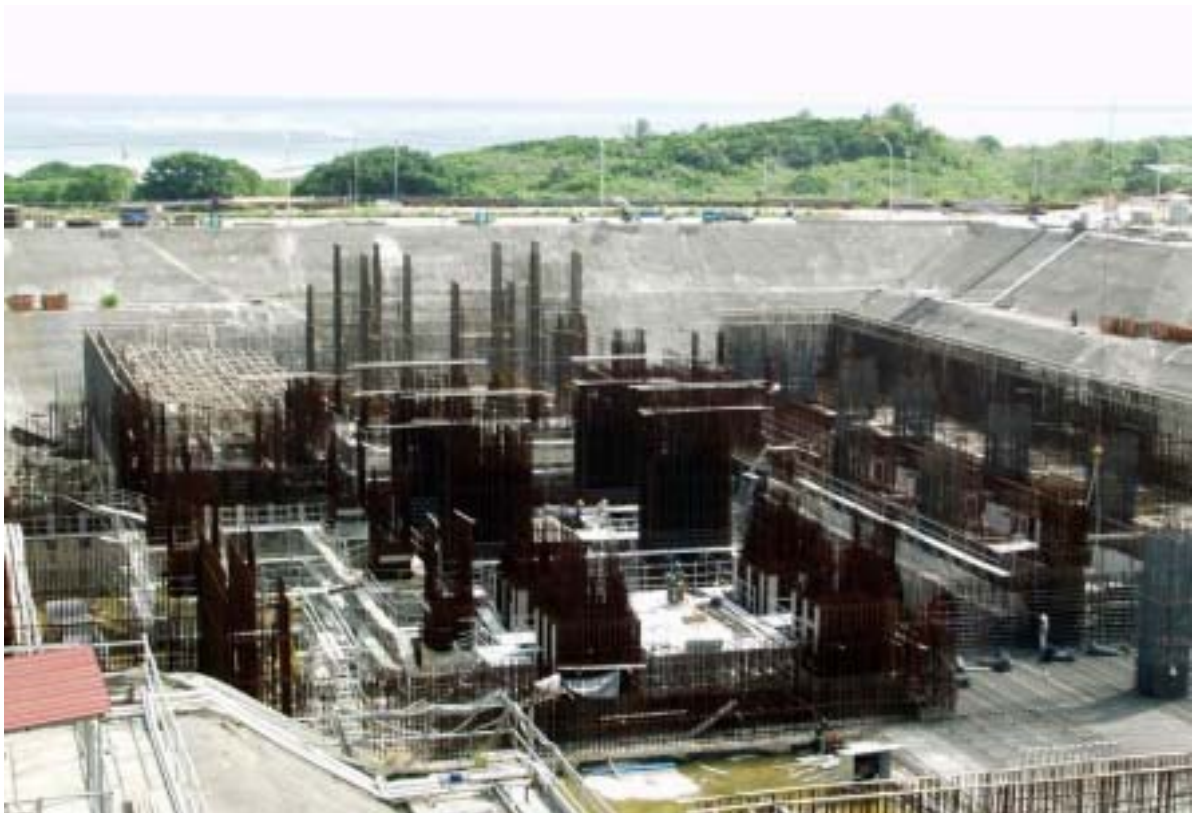
照片四：二號機汽機廠房施工現況圖景
