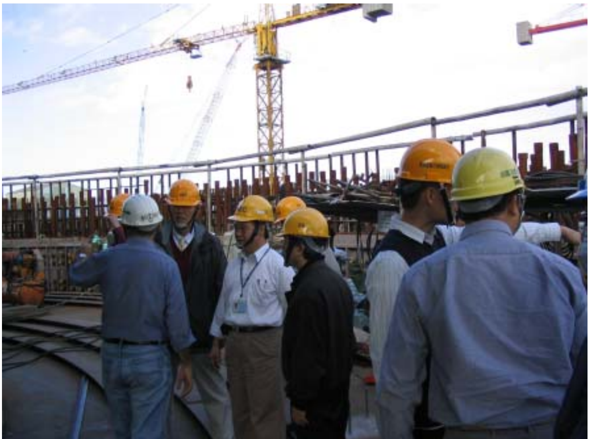
照片六：龍門計畫第十七次定期視察現場查證現況
