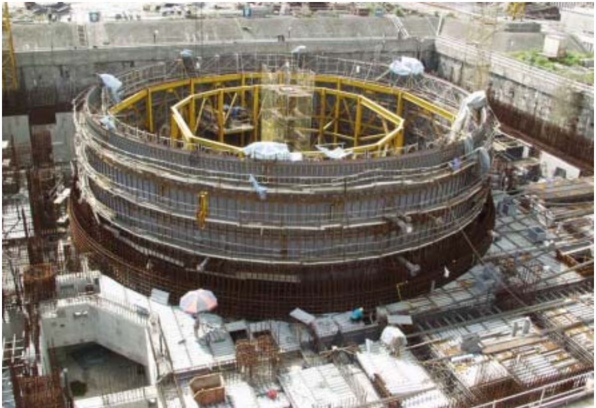
照片三：二號機反應器廠房施工現況圖景
