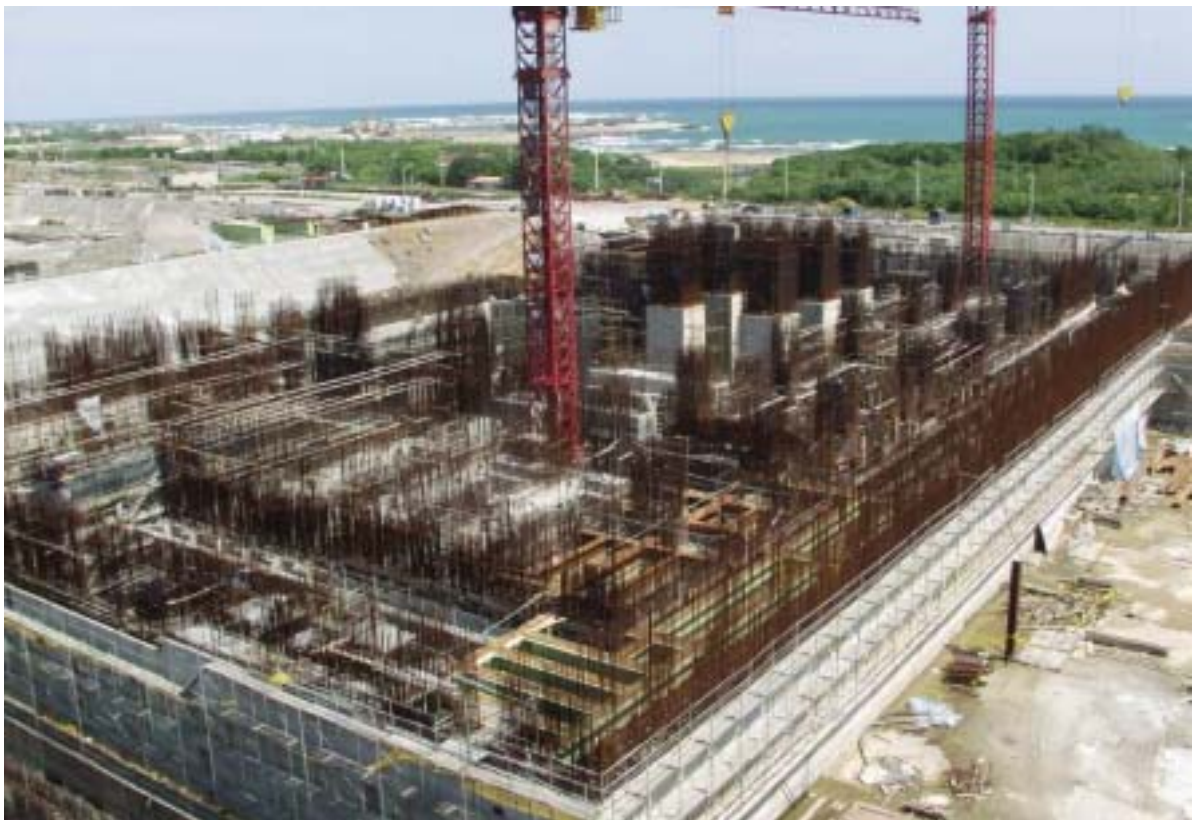
照片二：一號機汽機廠房施工現況圖景
