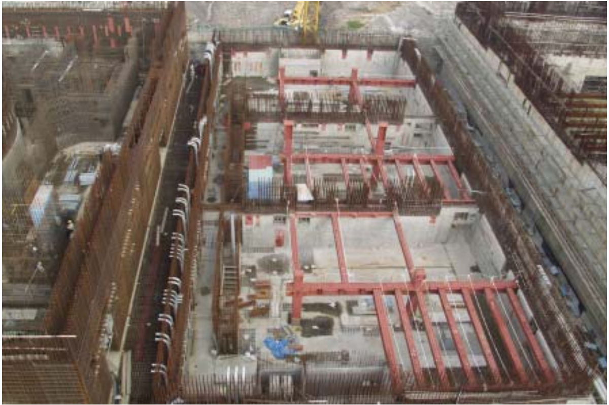
照片三：一號機控制廠房施工現況圖景
