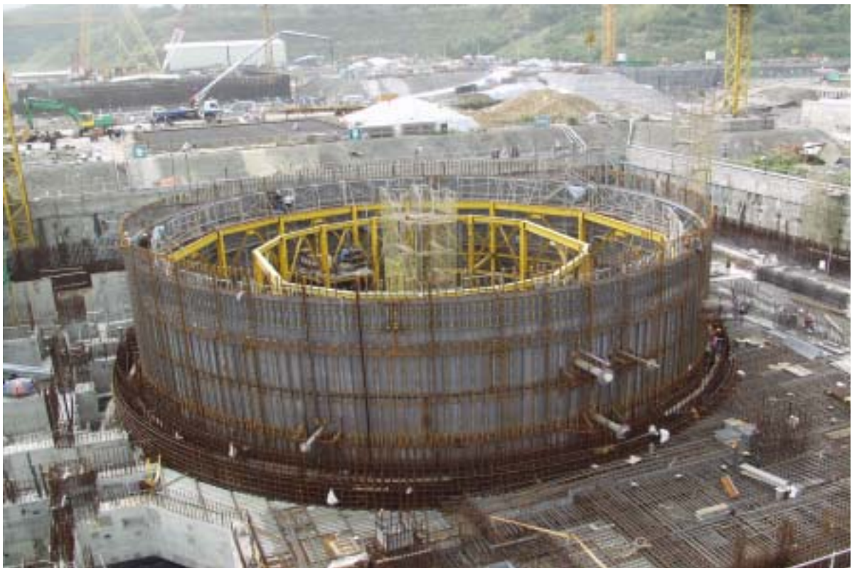
照片二：二號機反應器廠房施工現況圖景
