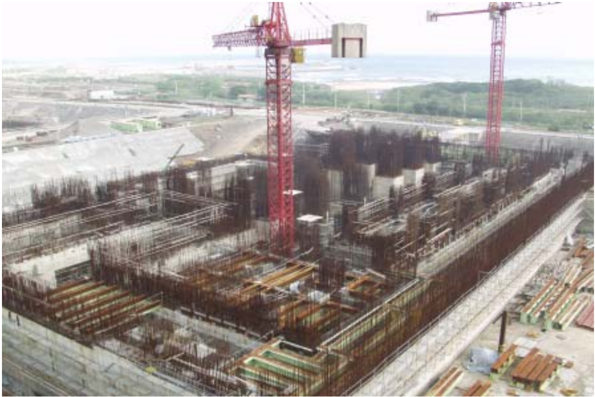
照片五：一號機汽機廠房施工現況
