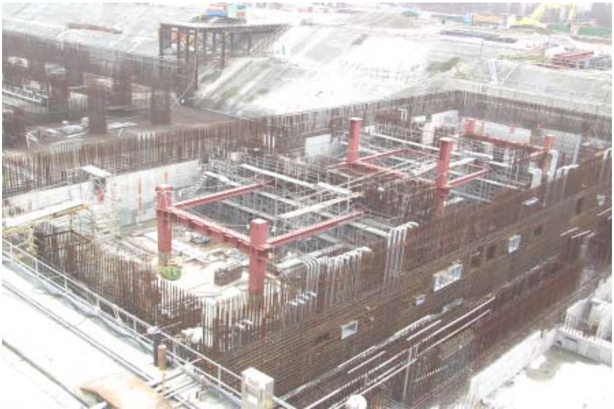
照片四：二號機控制廠房施工現況圖景
