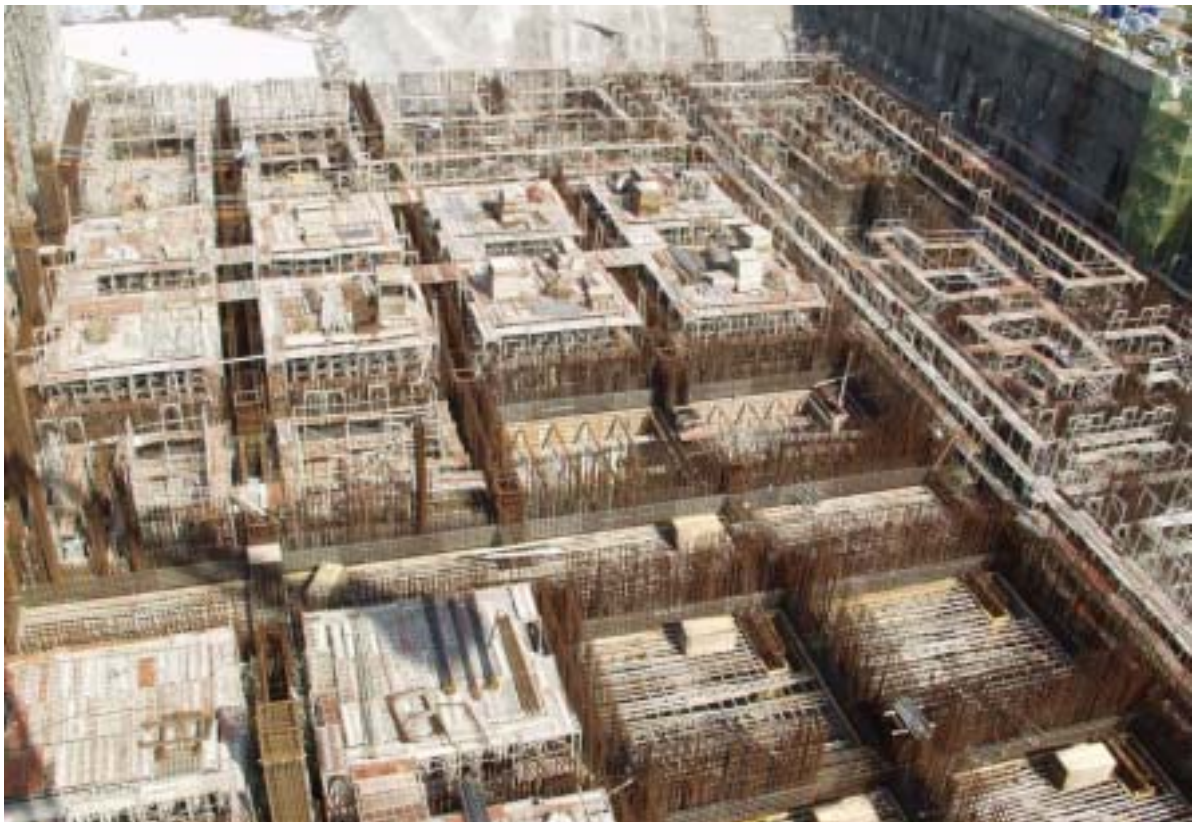
照片六：廢料廠房施工現況
