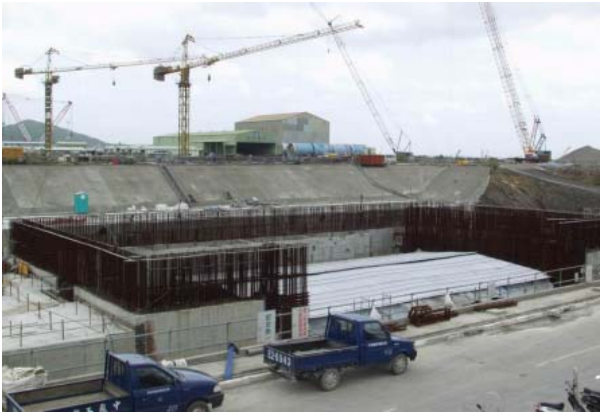
照片五：輔助用過燃料廠房施工現況
