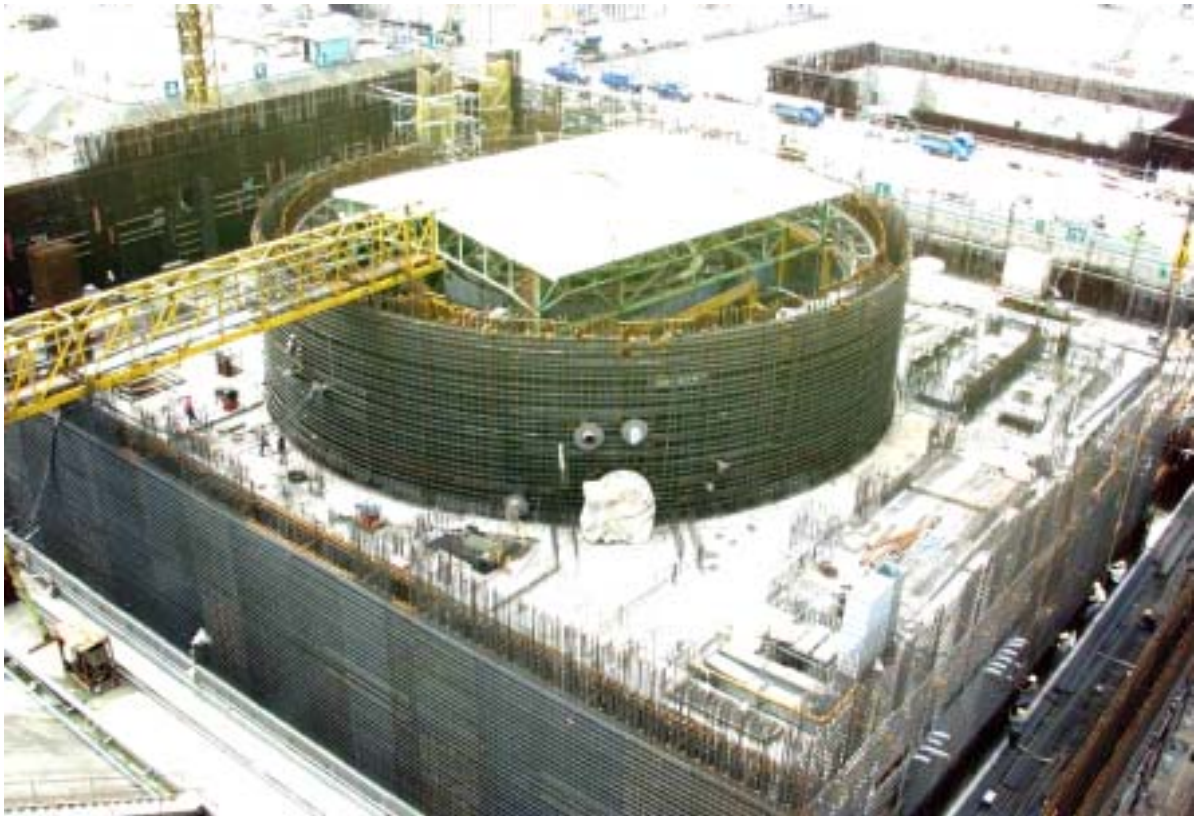
照片一：一號機反應器廠房施工現況圖景
