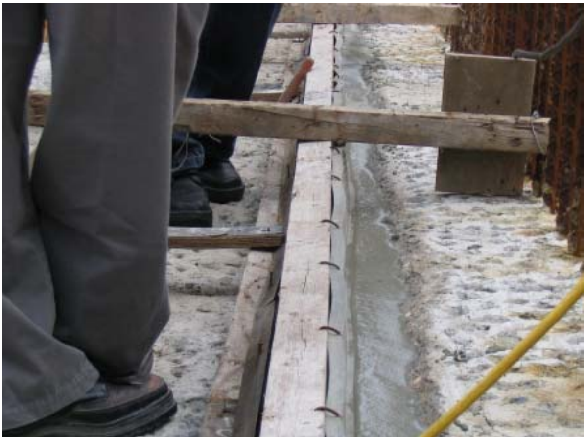
照片六：循環水抽水機房止水帶改善單面施作情形
