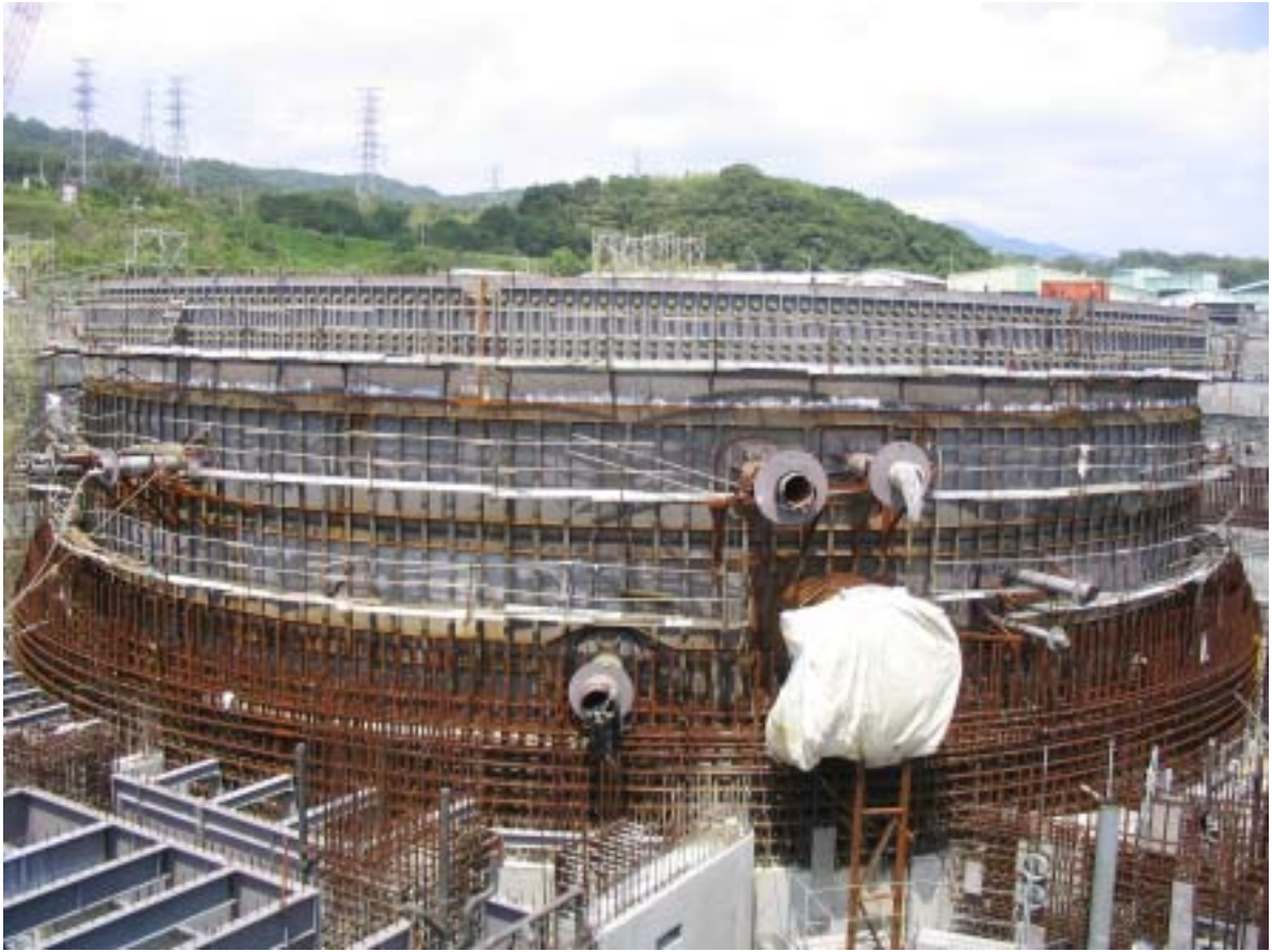
照片三：二號機反應器廠房施工現況圖景
