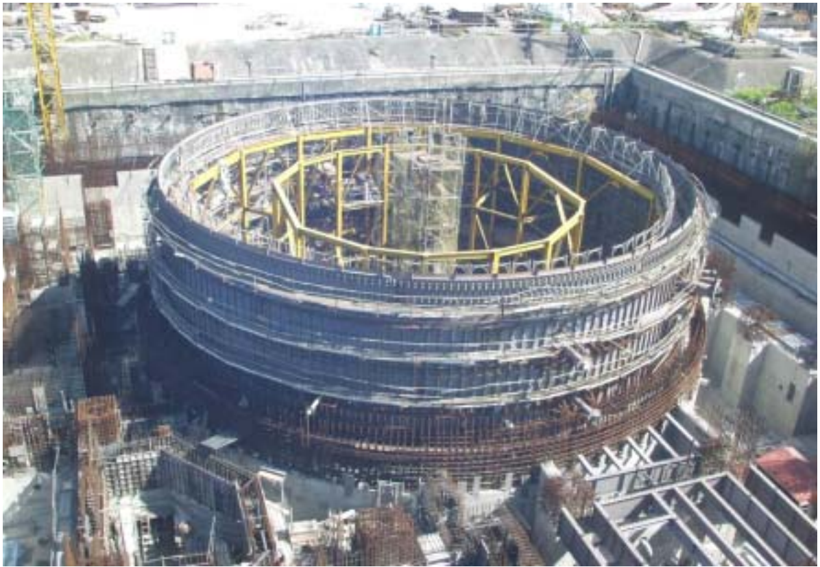
照片三：二號機反應器廠房施工現況圖景
