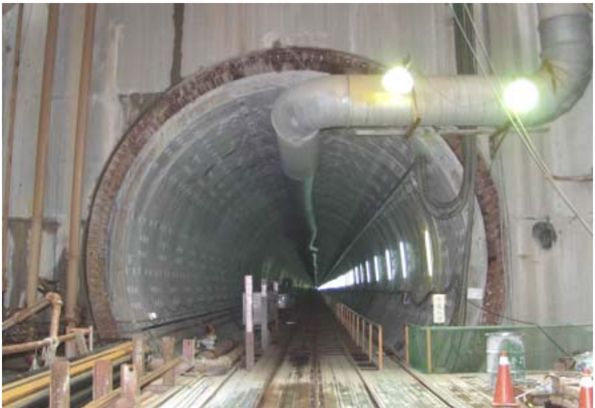
照片四：二號循環出水隧道工程施工現況
