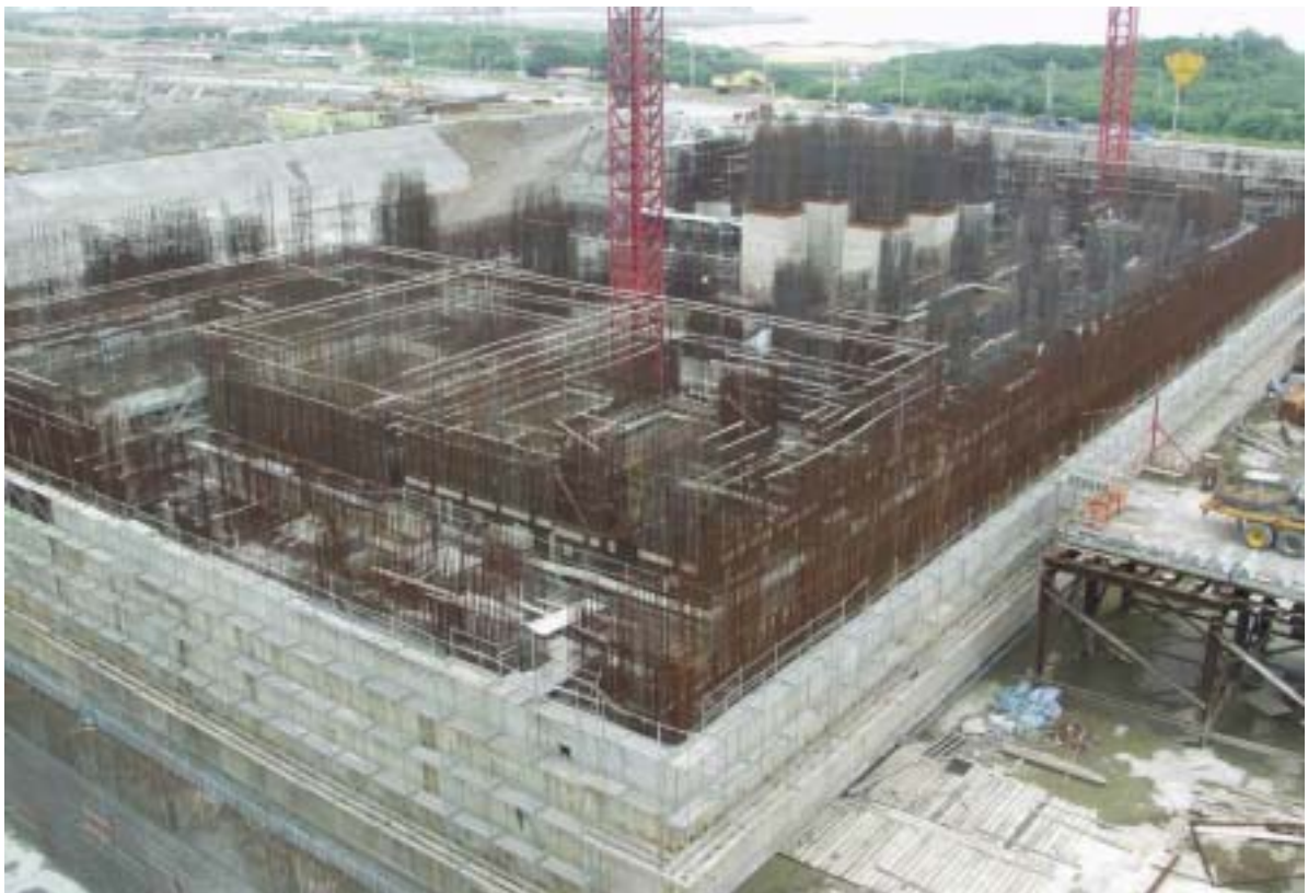
照片二：一號機汽機廠房施工現況
