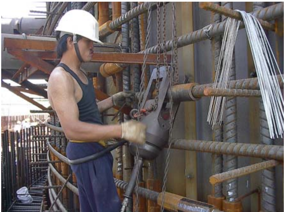
照片四：一號機 RCCV Wall #18 鋼筋續接器現場壓接作業情形
