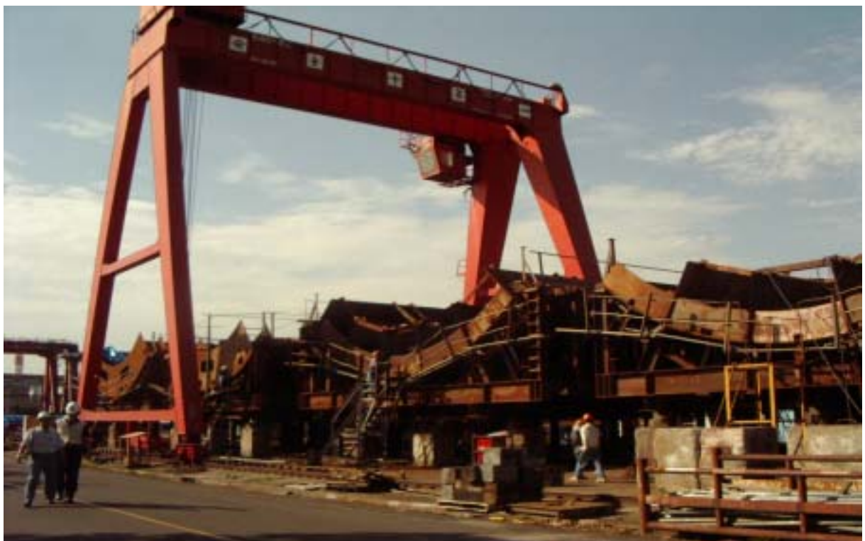
照片二：中船公司高雄廠承製二號機反應爐基座鋼構製造現況
