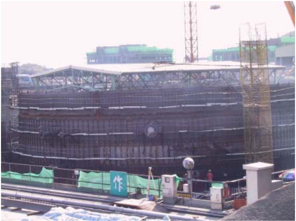
照片一：一號機反應器廠房施工現況圖景
