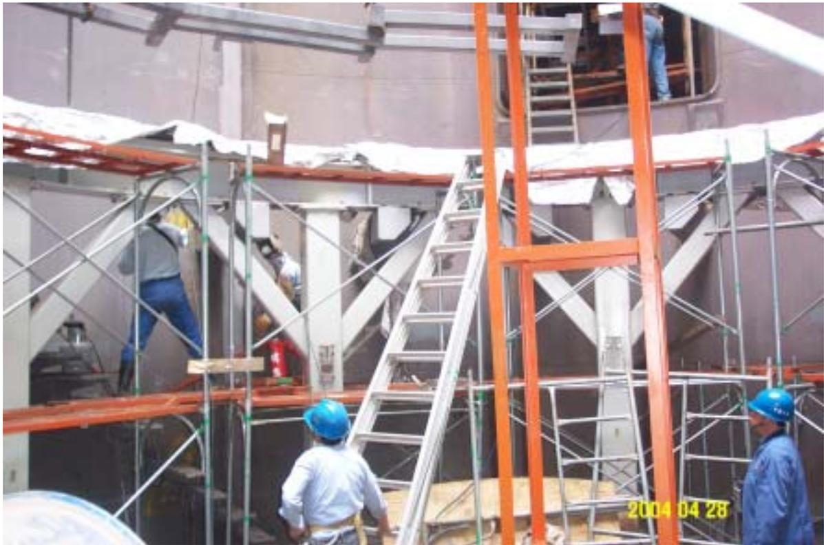
照片三：一號機反應爐基座下乾井作業平台施工作業情形
