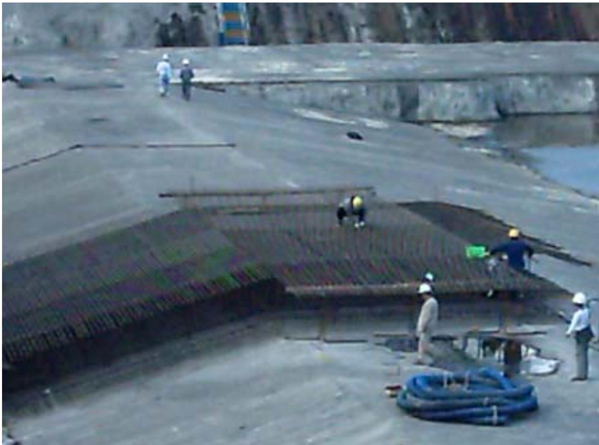
照片四：循環海水、反應器廠房冷卻水等抽水機房基礎施工現況
