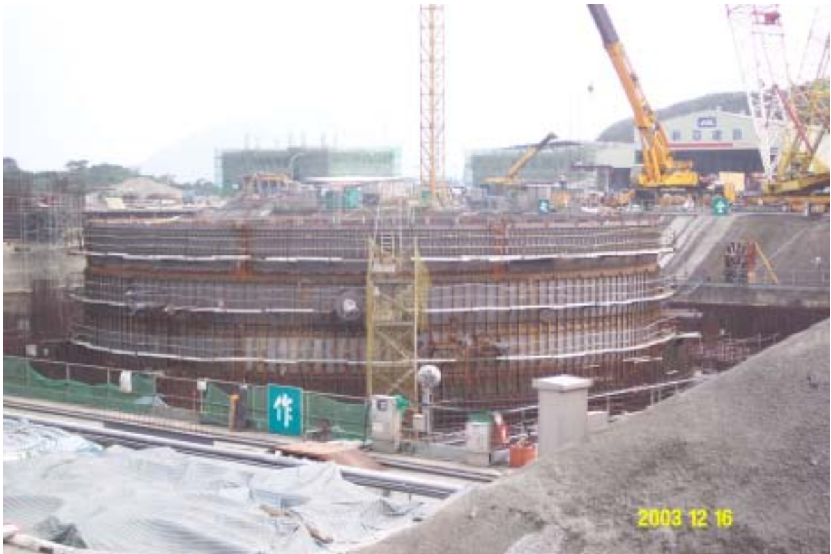
照片三：核四廠一號機反應器廠房施工現況
