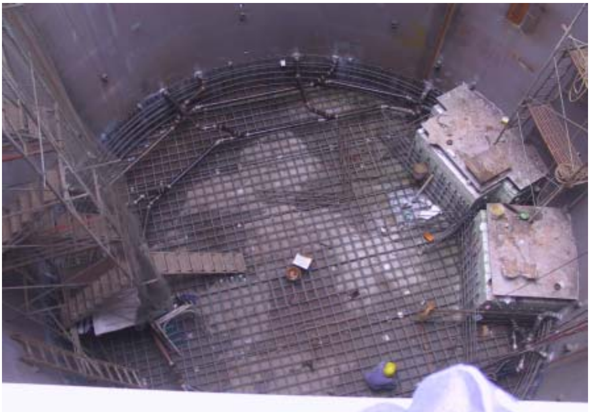
照片二：核四廠一號機反應爐基座內底層鋼筋排紮作業現況
