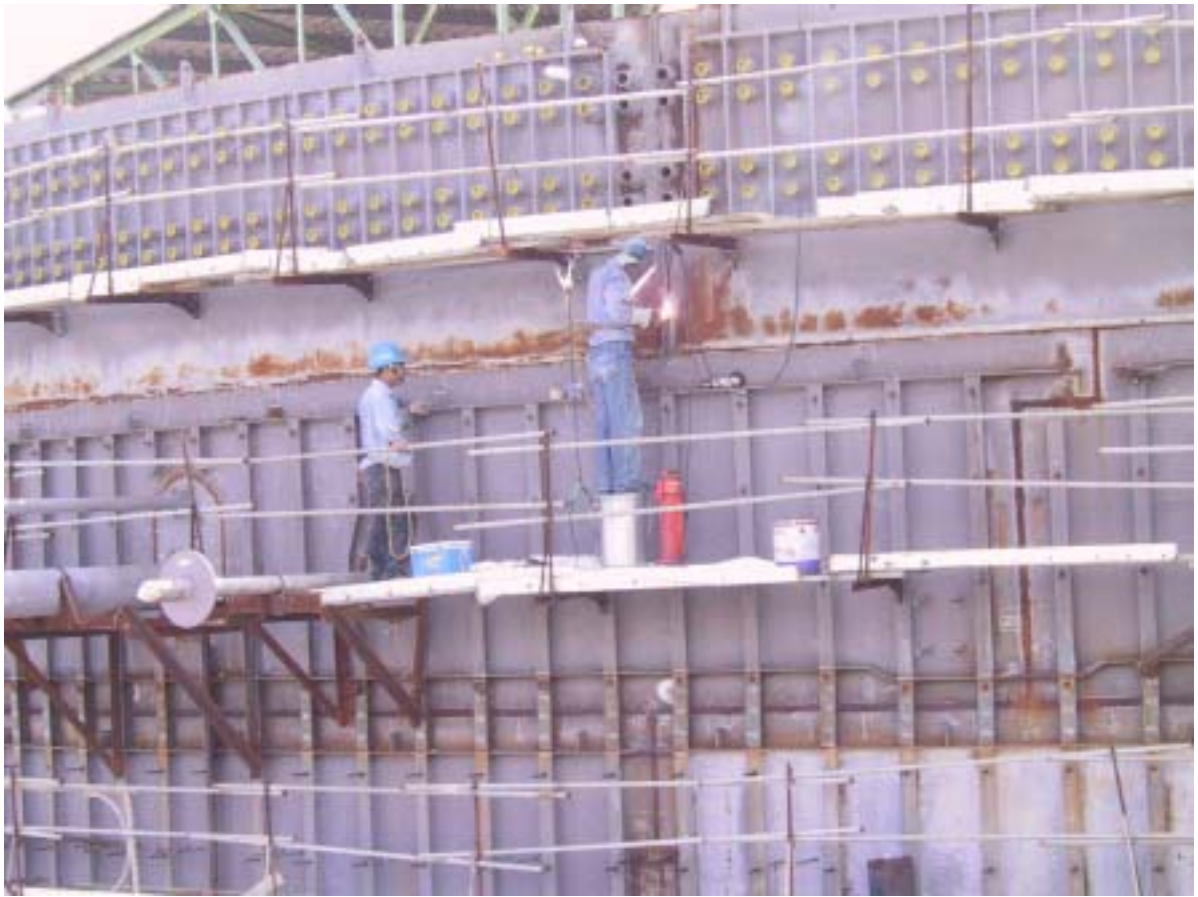
照片一：一號機反應器廠房 RCCV LINER 第八層垂直銲道銲接情形
