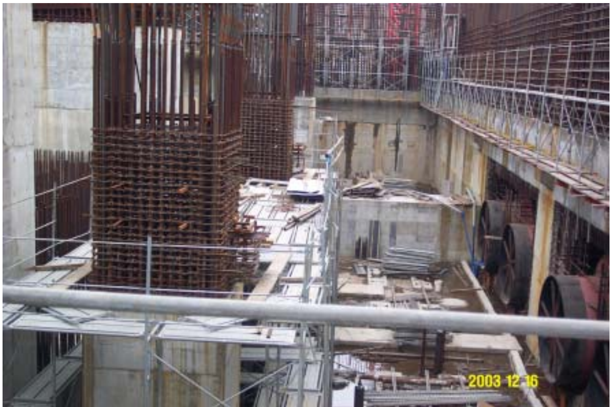
照片六：一號機汽機廠房施工現況一景
