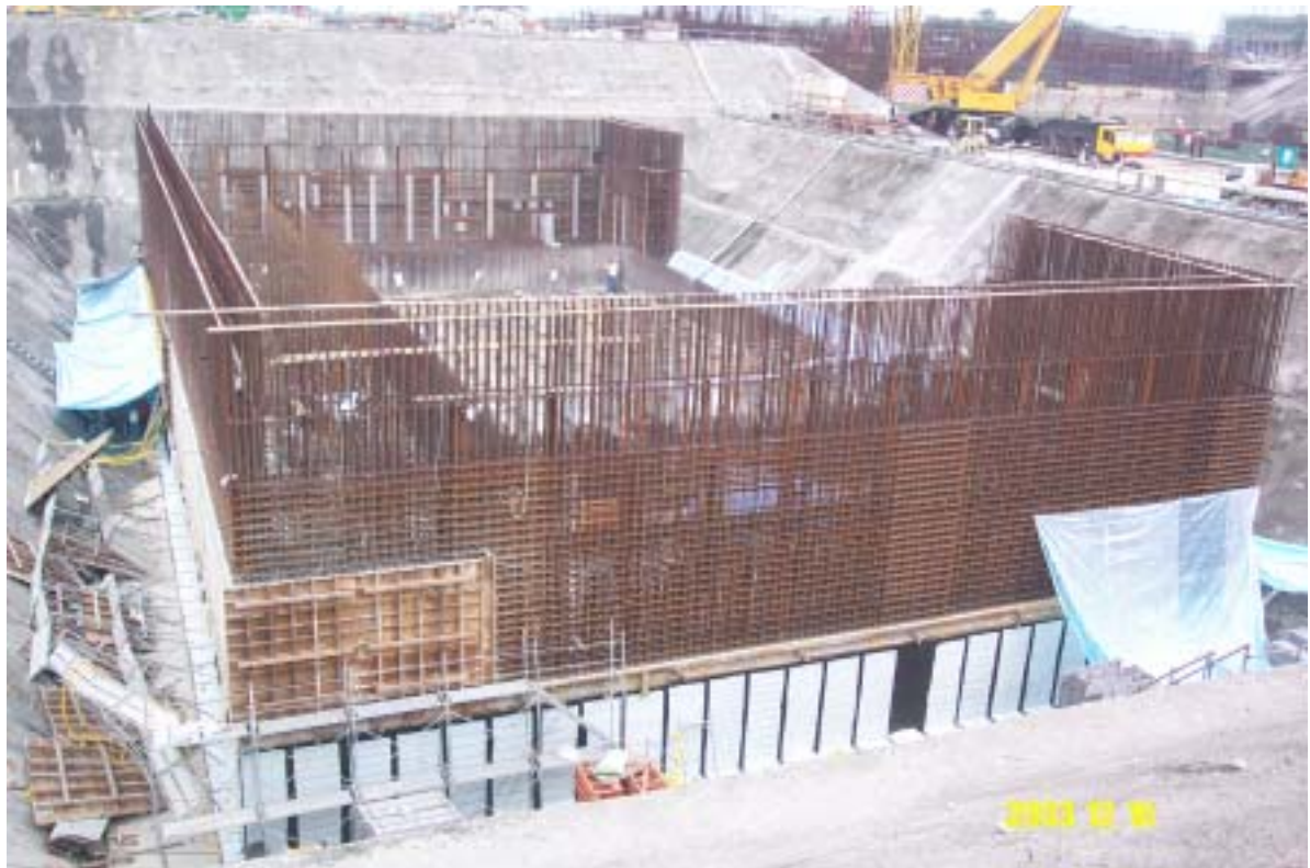
照片四：核四廠輔助用過燃料廠房施工現況
