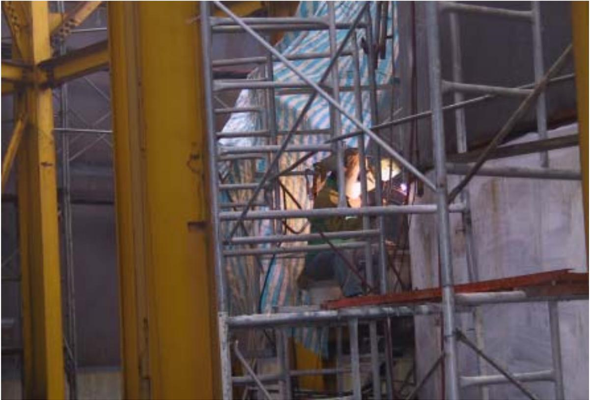
照片三：核四廠一號機反應爐基座第一、二層間水平銲道
