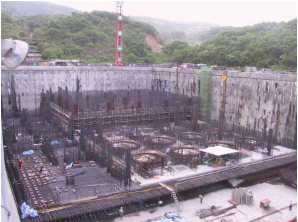
照片五：核廢料廠房施工現況
