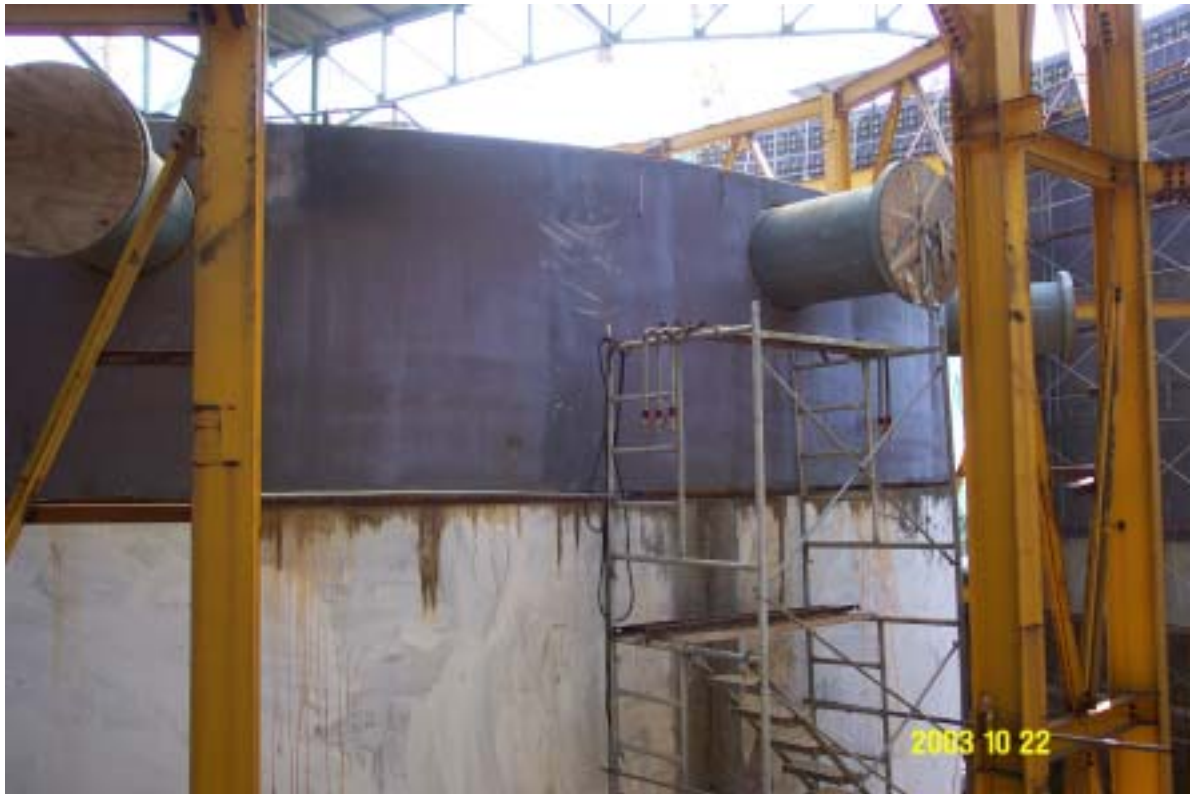
照片三：核四廠一號機反應爐基座第二層現場安裝現況
