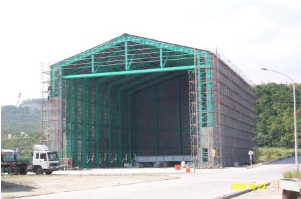
照片六：二號機 RPV 鋼骨結構儲存倉庫構築施工現況
