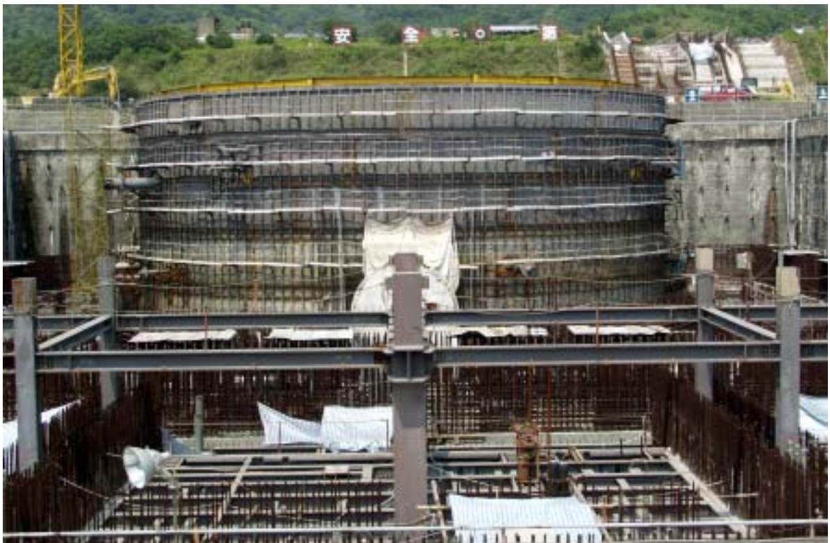
照片二：二號機反應器廠房及控制廠房鋼結構組立施工情形
