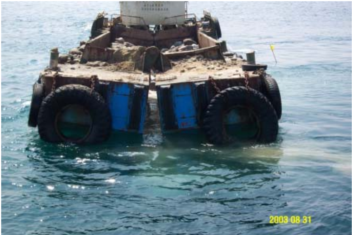
照片五：核四重件碼頭沉箱基礎拋石作業情形
