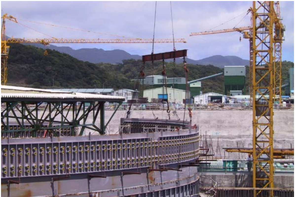
照片一：一號機反應器廠房 RCCV LINER 第八層組裝情形
