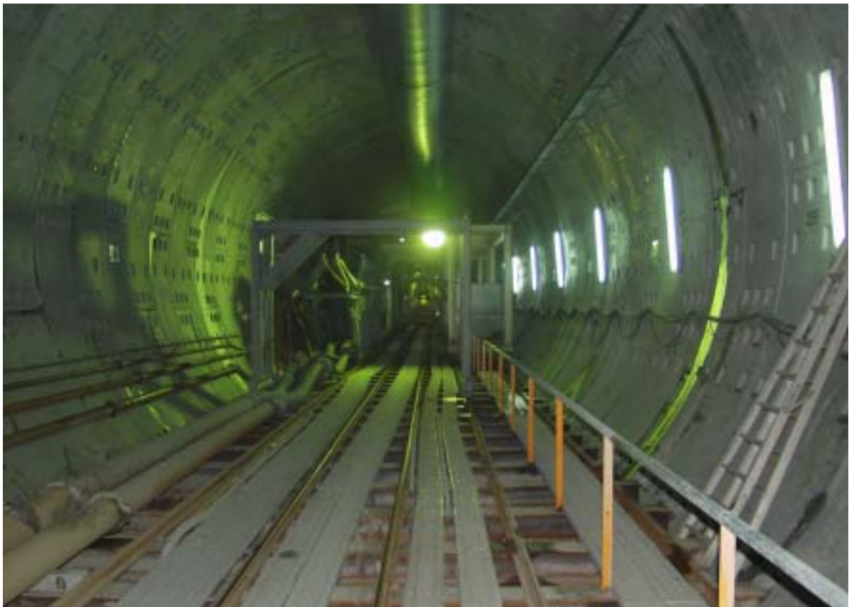
照片六：循環水出水道工程 # 1 出水隧道潛進約 400 公尺現況
