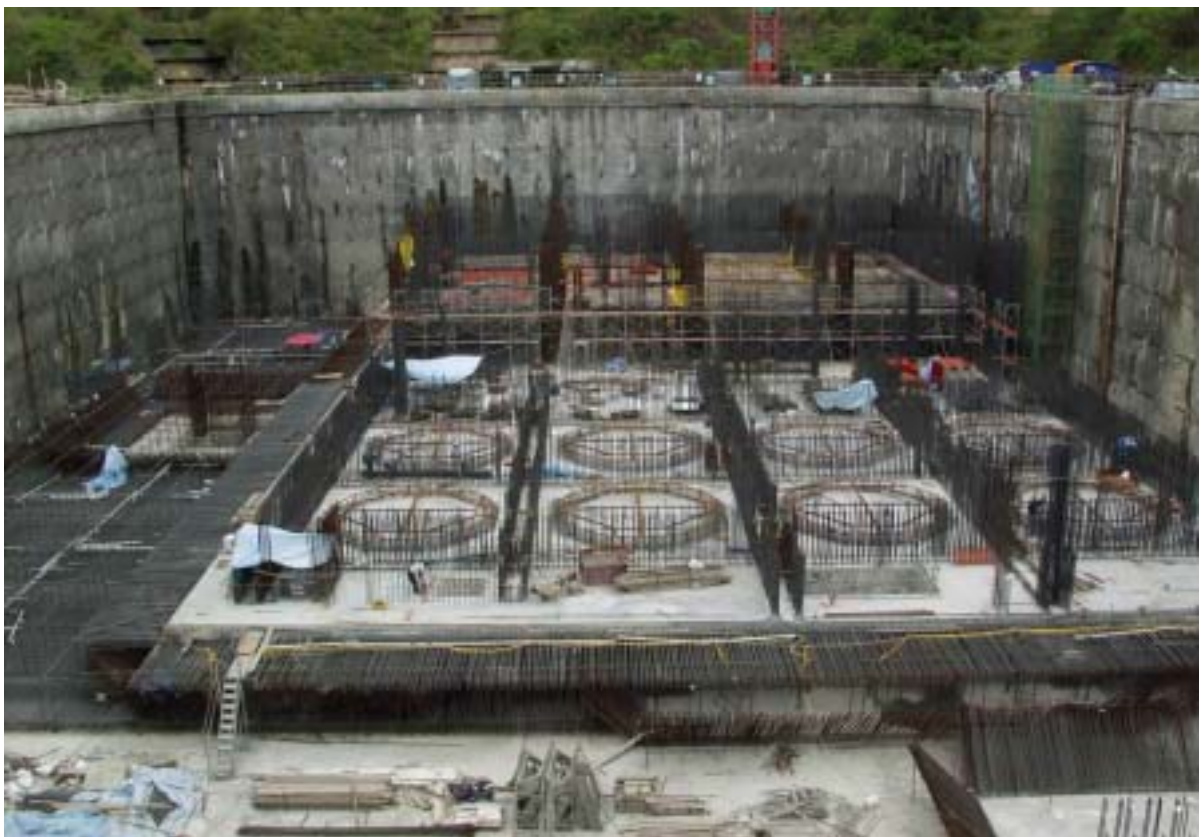
照片四：核廢料廠房施工現況
