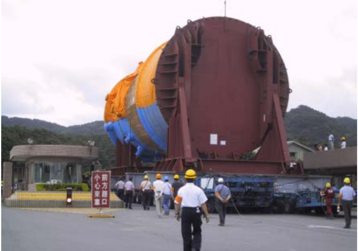
照片五：一號機 RPV 運送進廠情形
