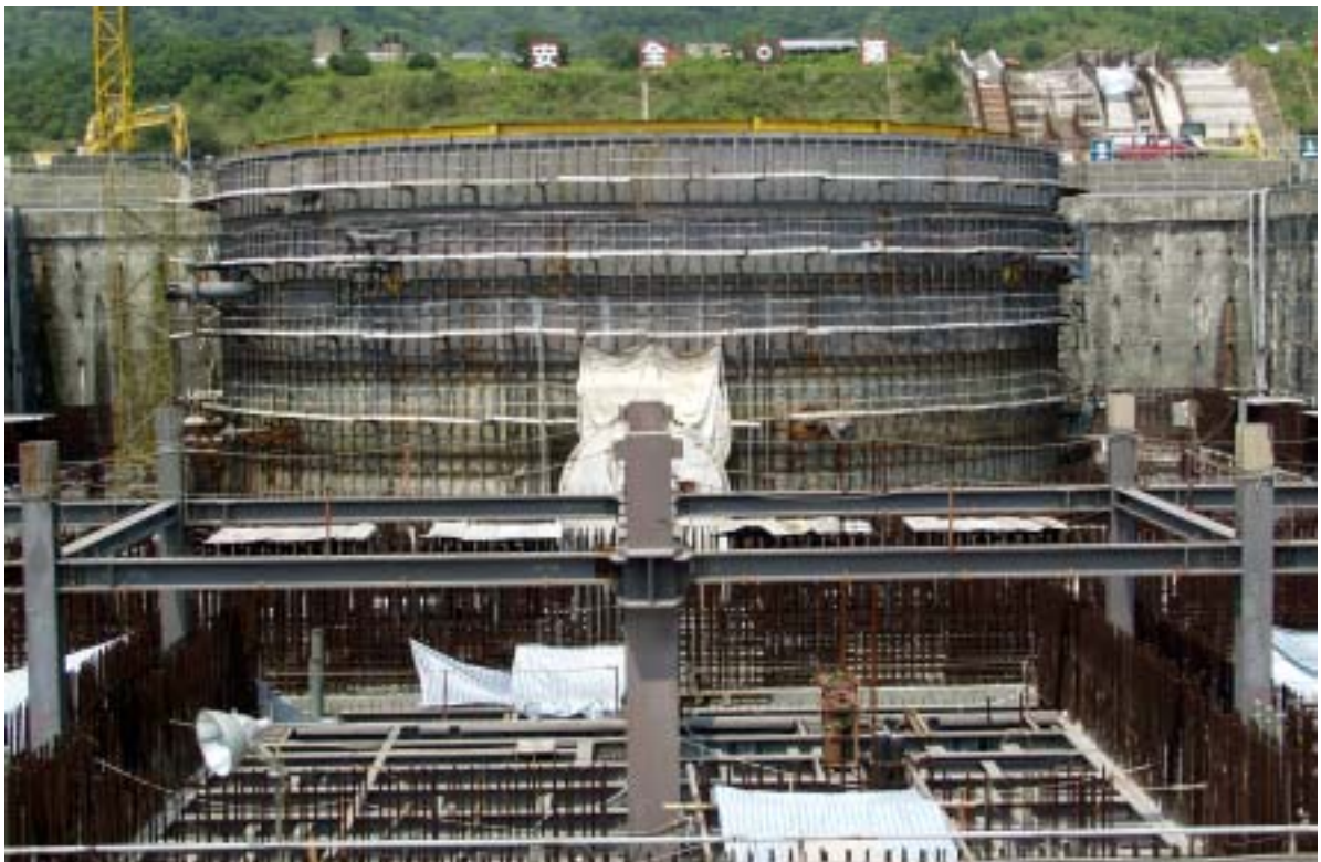
照片二：二號機反應器廠房及控制廠房鋼結構組立施工情形
