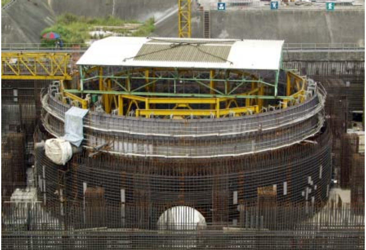
照片一：一號反應器廠房 RCCV 施工現況圖
