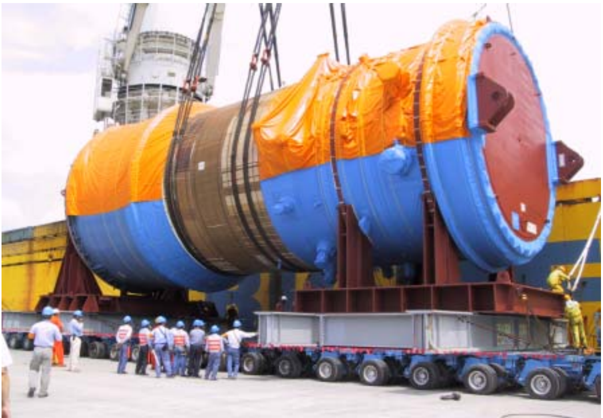
照片四：一號機 RPV 自重件船吊至自走式拖板車情形
