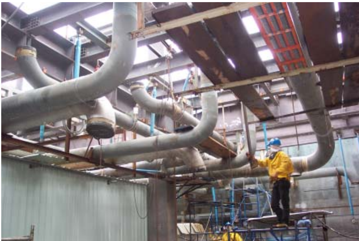
照片三：一號機控制廠房管路架設施工作業情形
