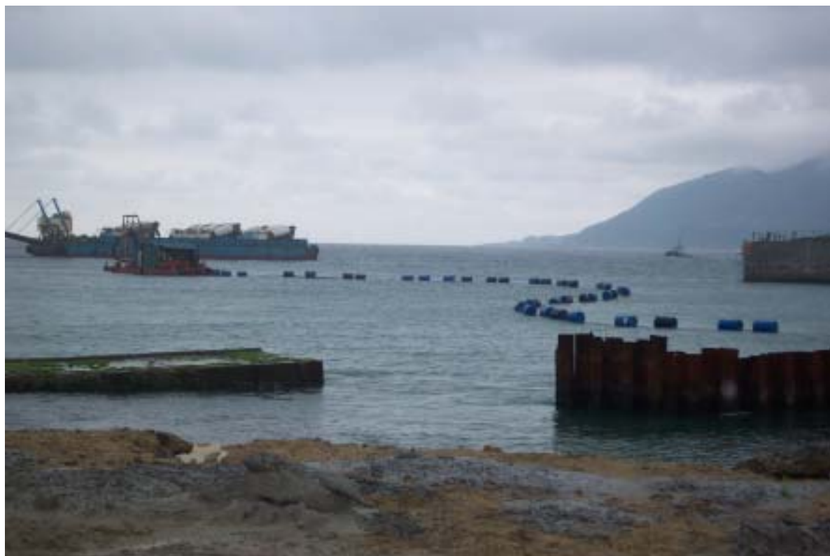
照片四：重件碼頭海上浚挖（抽砂）管路佈設作業情形
