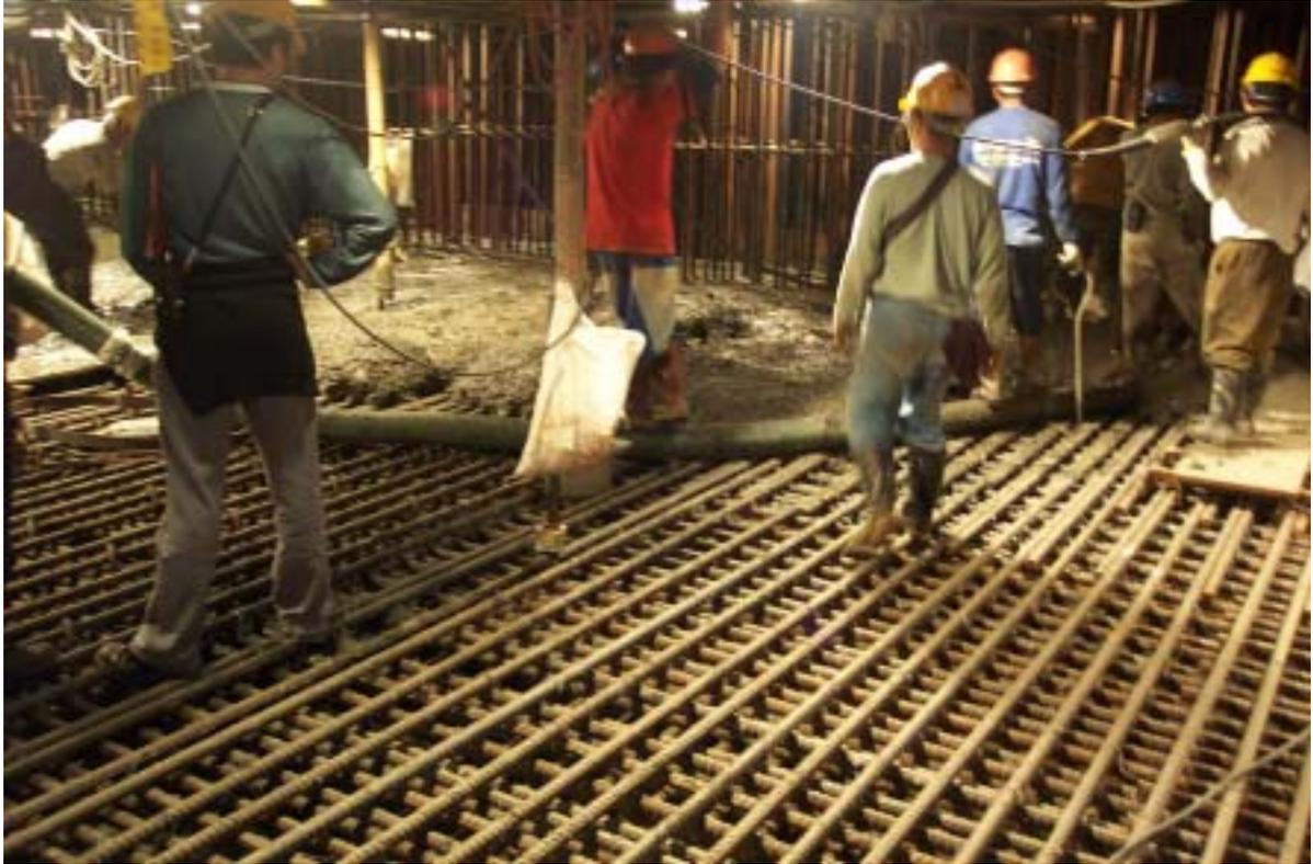
照片三：一號機汽機廠房基礎第十五區塊鋼筋間距改善完成
