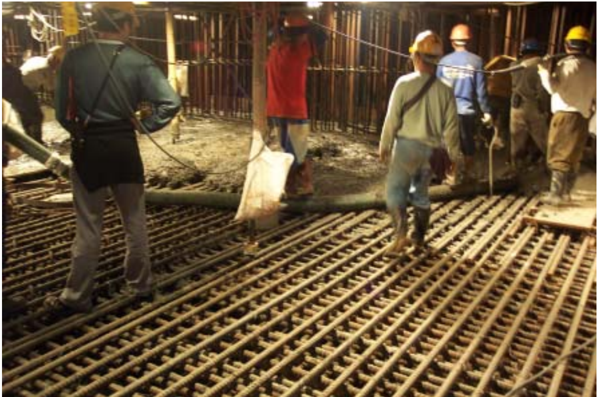
照片三：一號機汽機廠房基礎第十五區塊鋼筋間距改善完成 進行混凝土澆置作業情形
