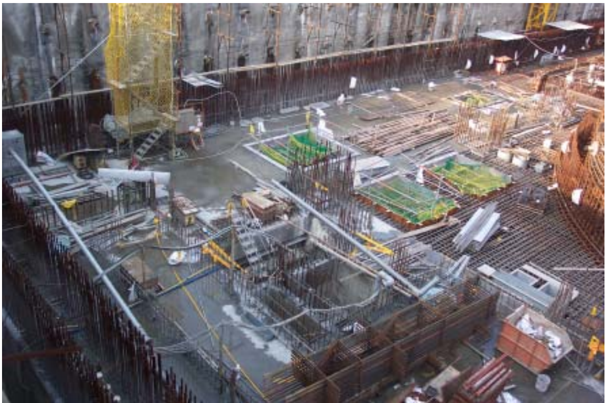
照片二：一號反應器廠房西北側 EL-1700mm 之樓板混凝土澆置完成後情形
