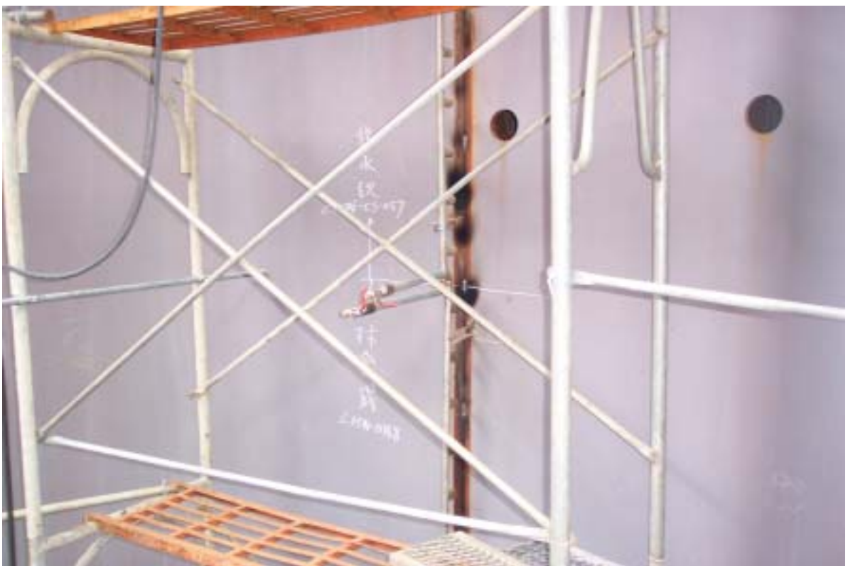
照片四：一號機反應器基座第一層進行銲接前預熱作業情形
