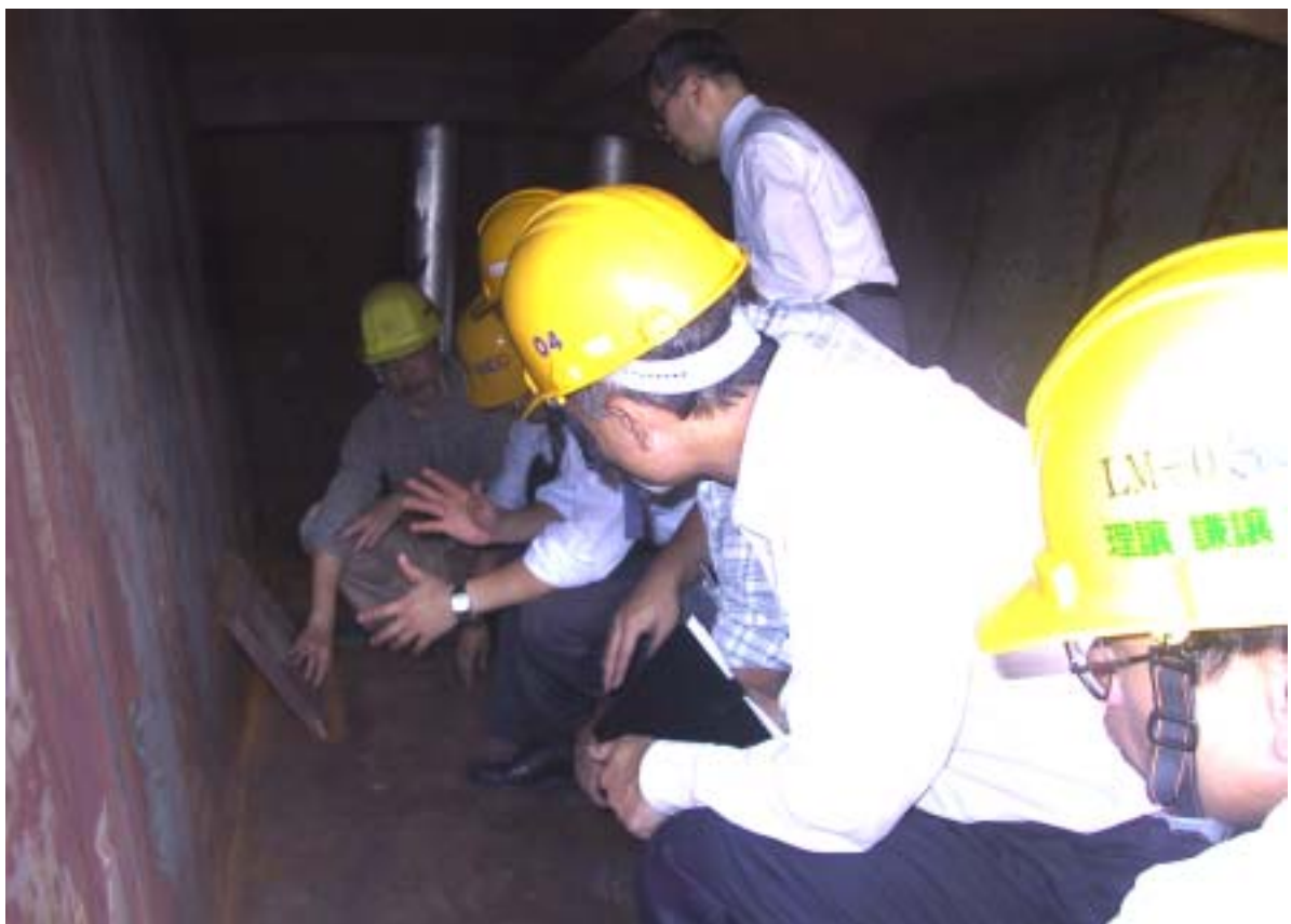
照片四：第九次定期視察-JAPEIC 日本專家至反應爐基座視察
