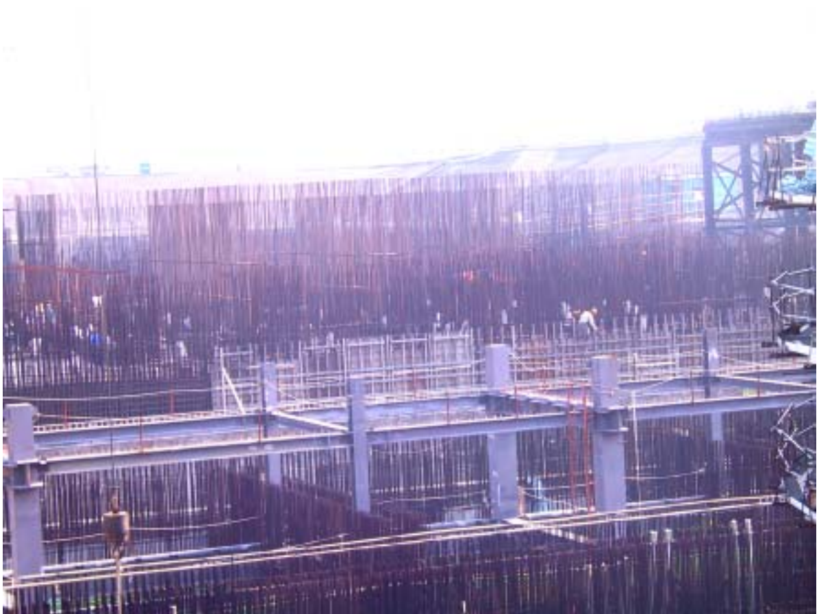
照片二：一號機控制室廠房及後方汽機廠房目前施工現況
