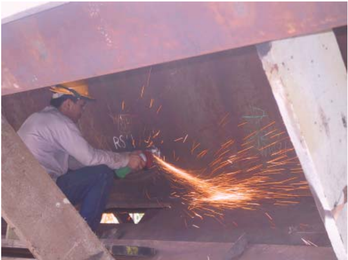
照片七：第一層基座製造品質管制作業-輔助板設計變更前輔助 鉚切除作業之情形
