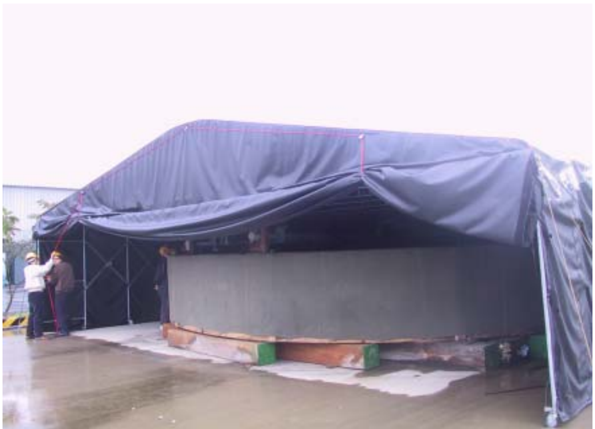
照片四：設備儲存管制查證-RPV REFUELING BELLOWS 為 C 級儲存 等級之儲存現況
