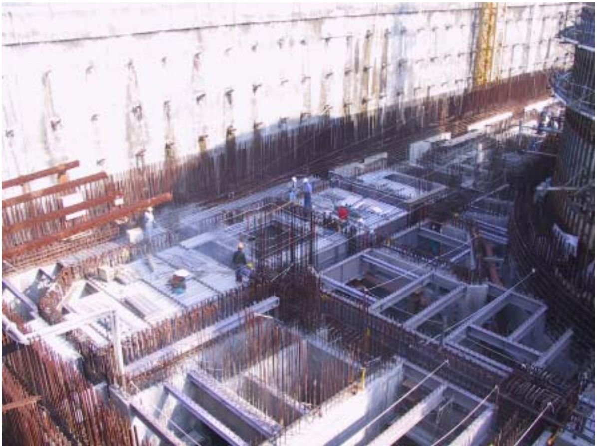
照片一：一號反應爐廠房西北區 EL-1700mm 之樓版鋼樑組立情形
