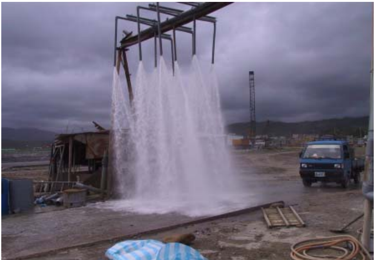
照片二：重件碼頭拋石石塊清洗之水柱噴灑情形
