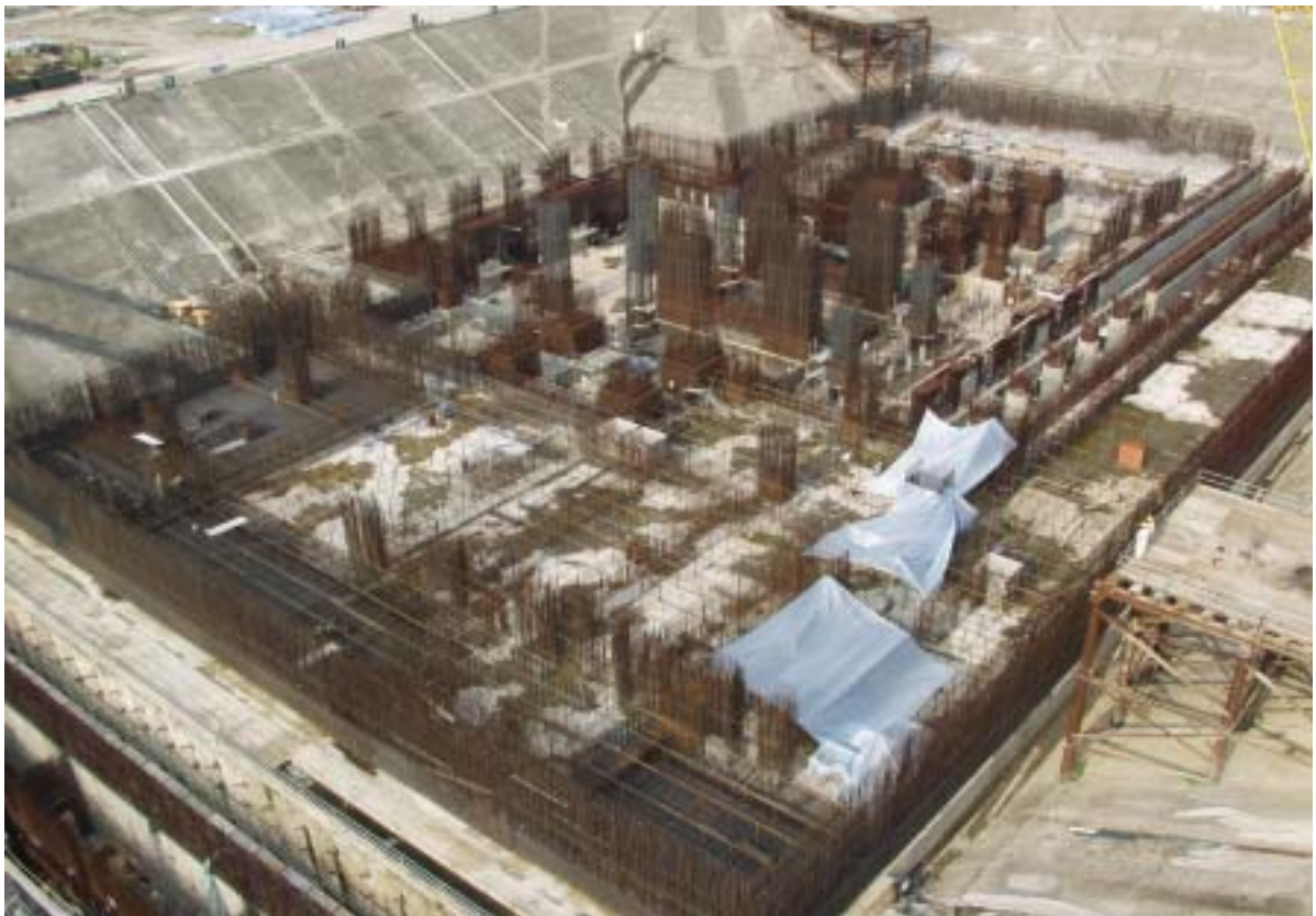
照片二：二號機汽機廠房施工現況情形
