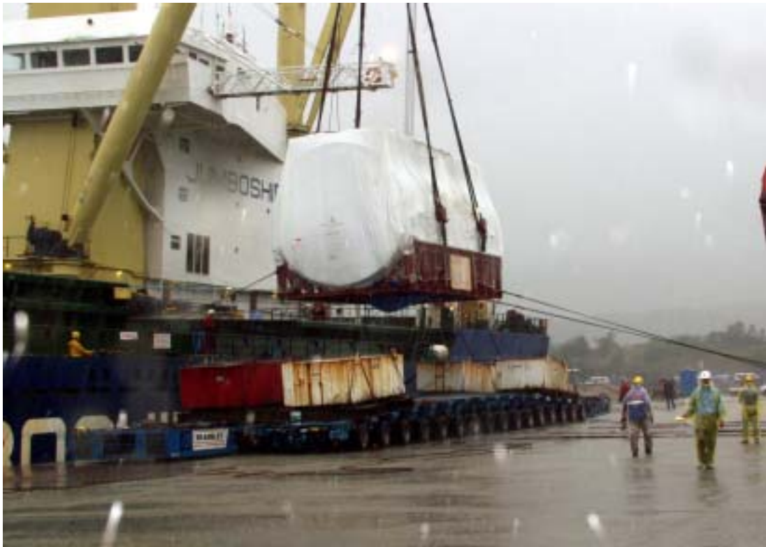
照片五：一號機發電機定子吊卸狀況
