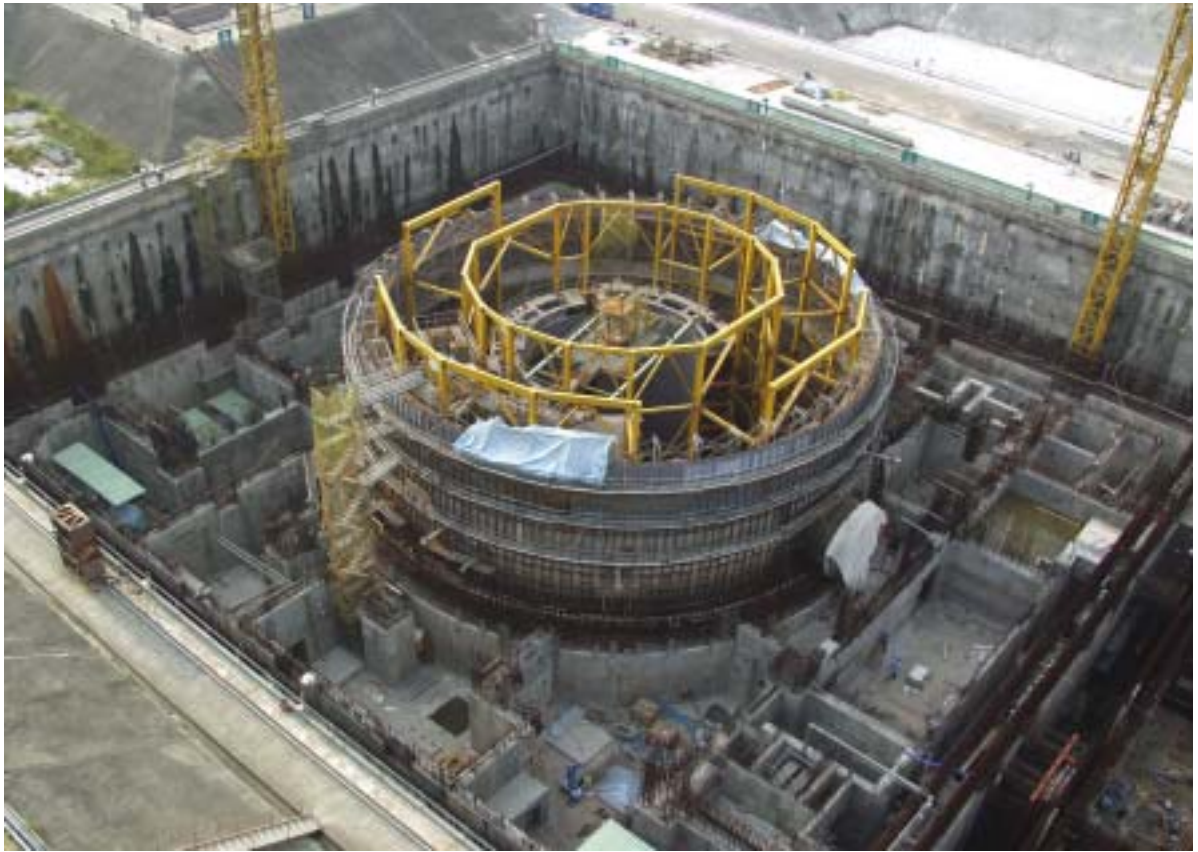
照片一：一號機反應爐廠房施工現況情形
