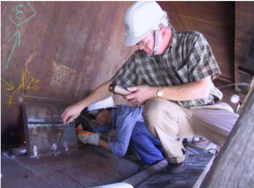
反應爐基座第一層 267 銲道切取試樣作業（二）
