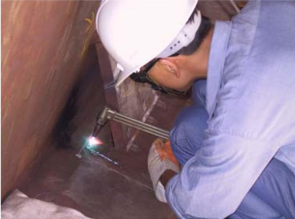
反應爐基座第一層 267 銲道切取試樣作業（一）
