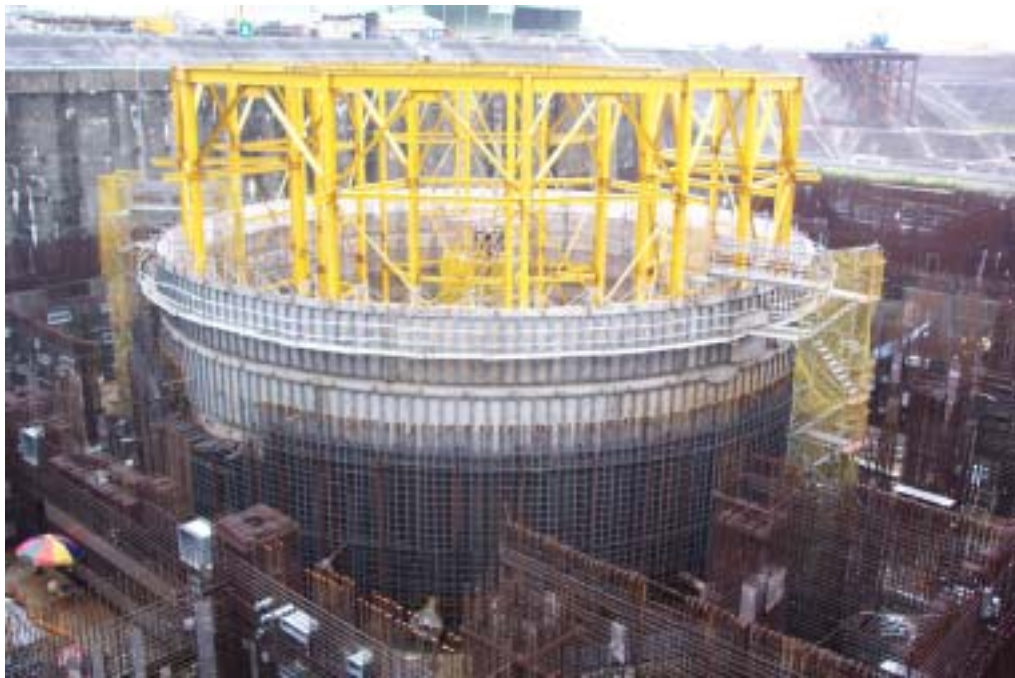
一號機反應器廠房工程施工現況
