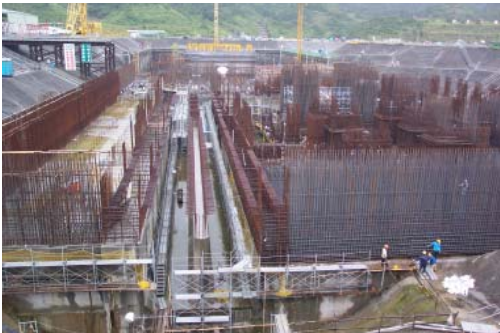
一號機汽機廠房結構工程施工現況
